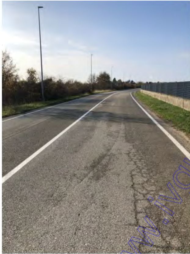
Fotografia A.1 - Viabilità Via Brava
