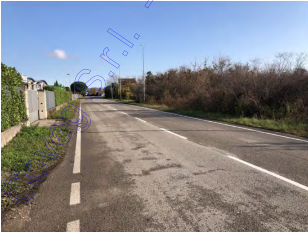
Fotografia A.2 - Viabilità via Brava
