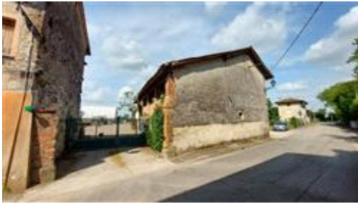
Vista esterna sud - est
