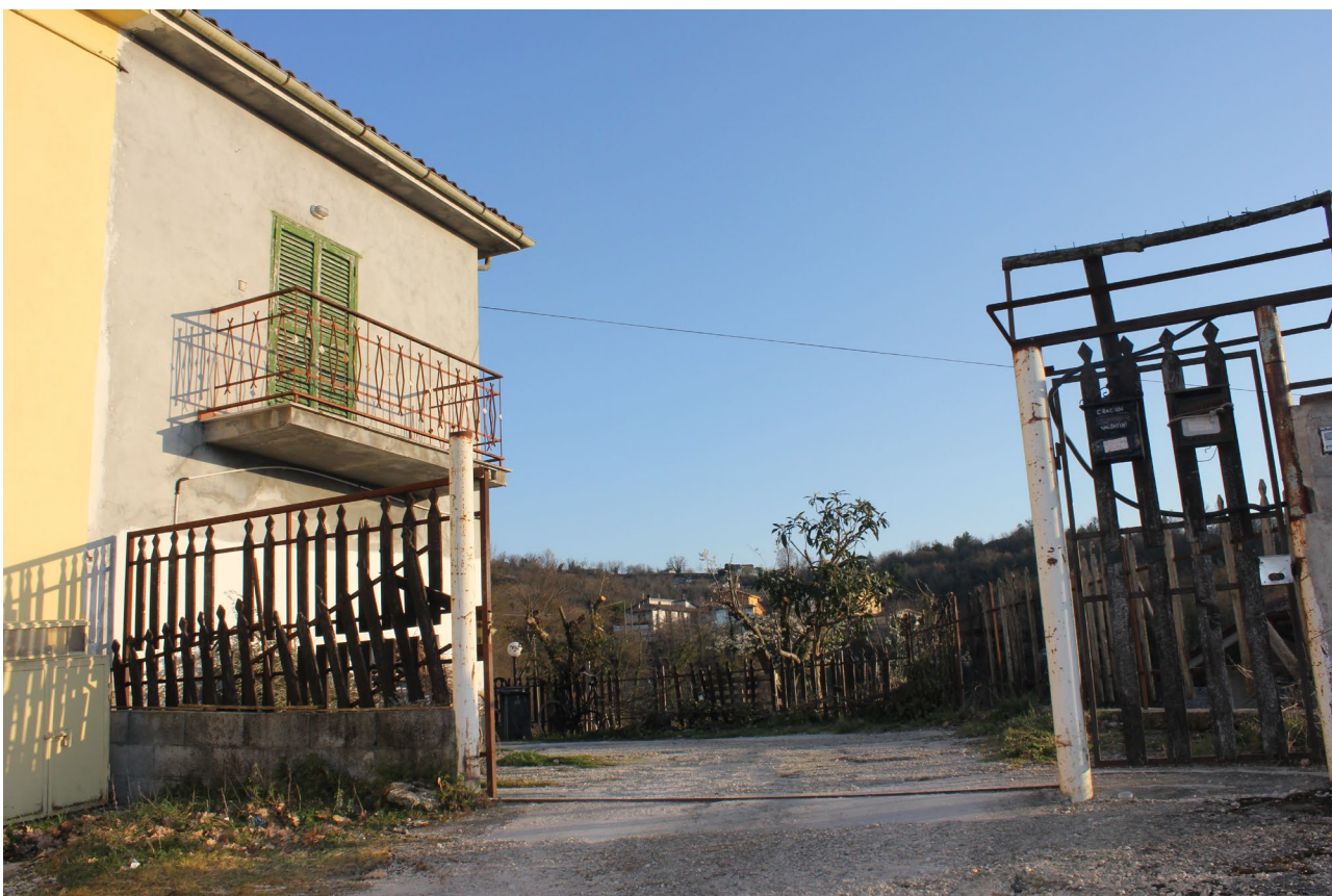
Ingresso dalla strada vicinale con accesso carrabile e pedonale nella Part.IIa 840 e nel fabbricato Part.IIa 646 sub. 4 e Part.IIa 841 sub. 1 - Prospetto Nord-Ovest
