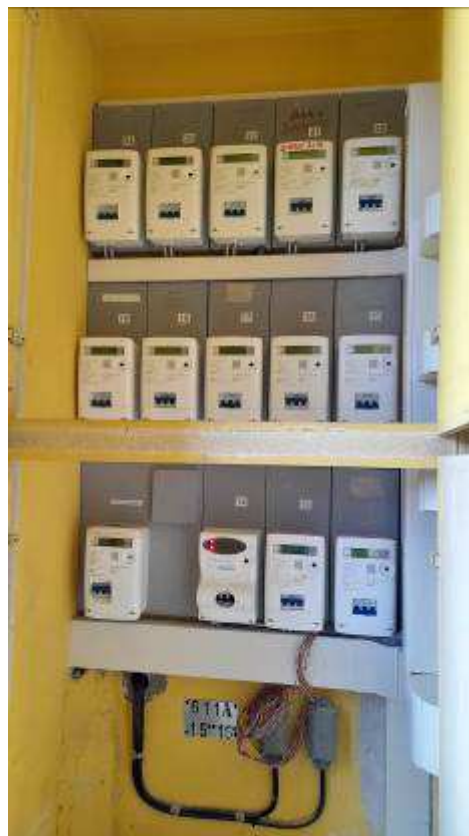
Figura 20. Quadri elettrici e contatori elettricit .
