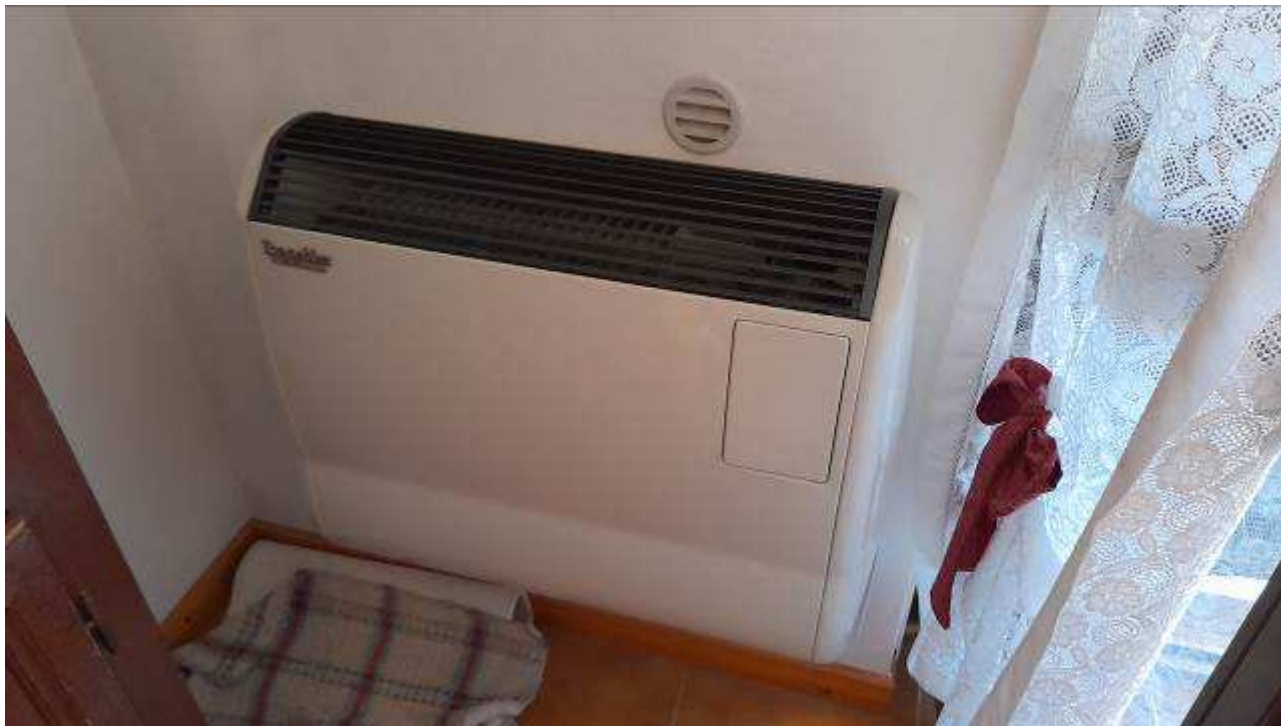
Figura 17. Generatore aria calda a gas.
