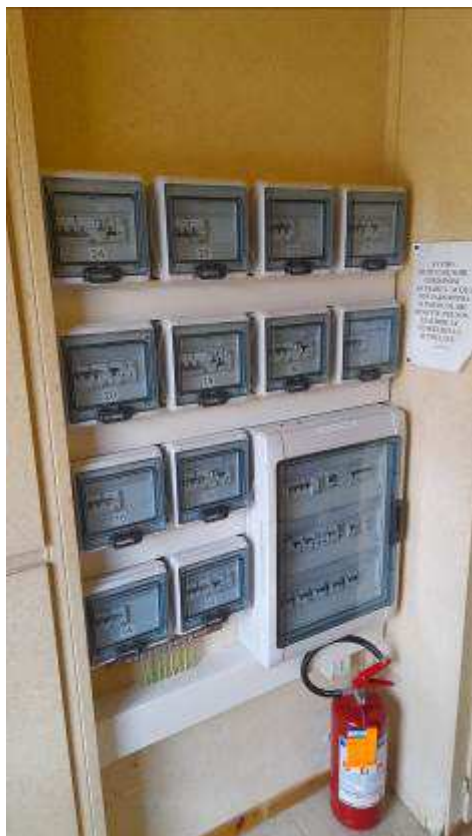
Figura 20. Quadri elettrici e contatori elettricit .
