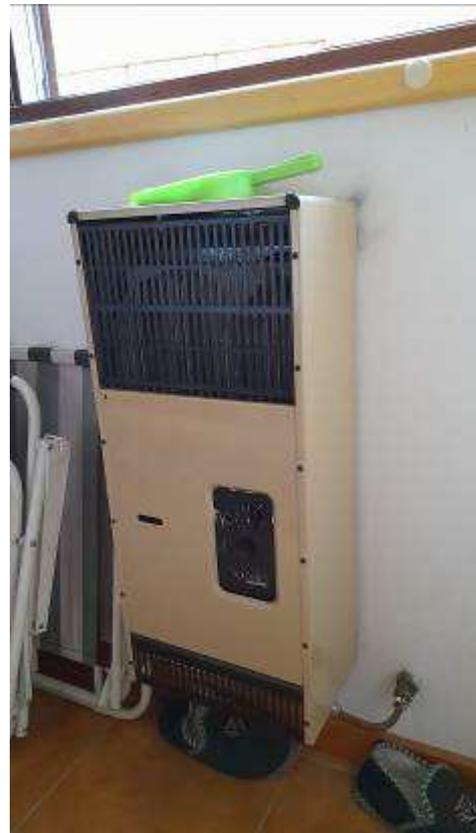
**Figura 12. Ripostiglio e generatore aria calda a gas.**
