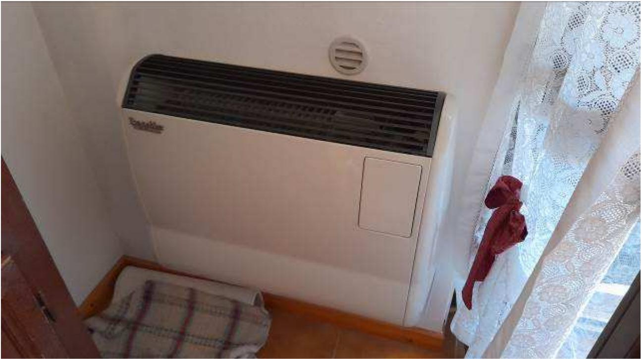
**Figura 13. Generatore aria calda a gas.**
