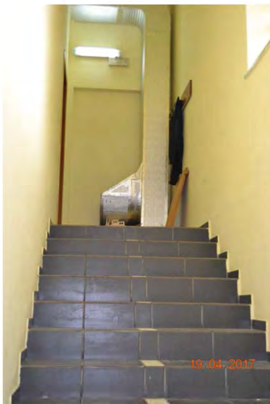
Foto n. 18: Scale piano rialzato - piano seminterrato
