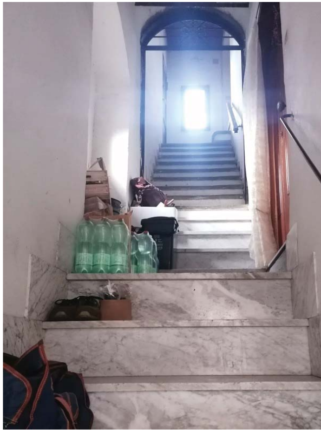
FOTO N. 2 SCALA DI ACCESSO AL SECONDO PIANO
