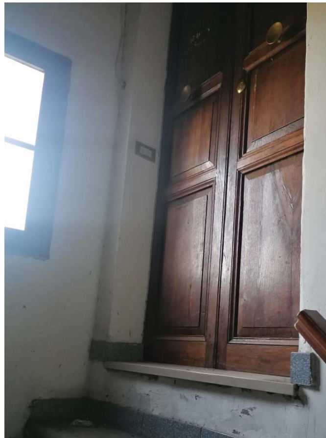
FOTO N. 3 PORTONCINO D'INGRESSO ALL'APPARTAMENTO
