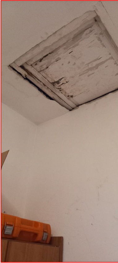
Foto 16 / 16 a) - Botola ispezione sottotetto da cui sono visibili le infiltrazioni di acqua piovana
