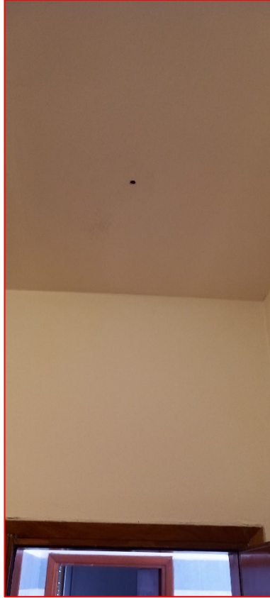
Segni di infiltrazioni dalla copertura.
