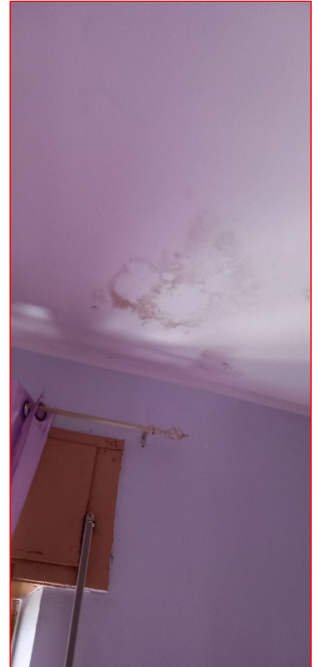
Segni di infiltrazioni dalla copertura.
