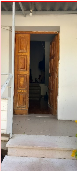
Foto 5 - Ingresso al corpo scala
