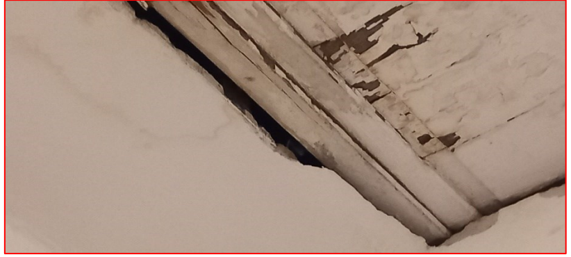
Foto 16 / 16 a) - Botola ispezione sottotetto da cui sono visibili le infiltrazioni di acqua piovana
