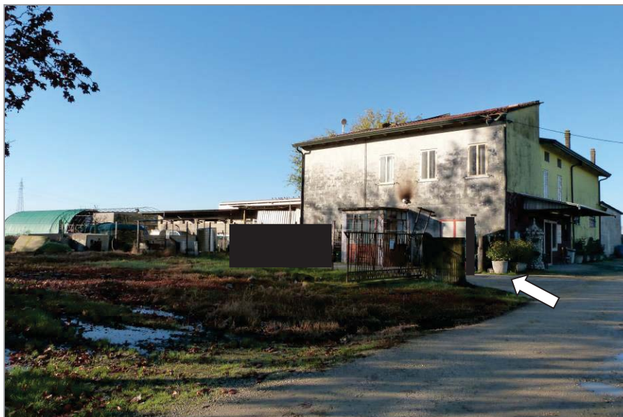
1 Vista da nord-est di parte dei fabbricati del complesso agricolo. La freccia indica l'accesso alla parte residenziale da via Grigoletto e Pasqualato.
