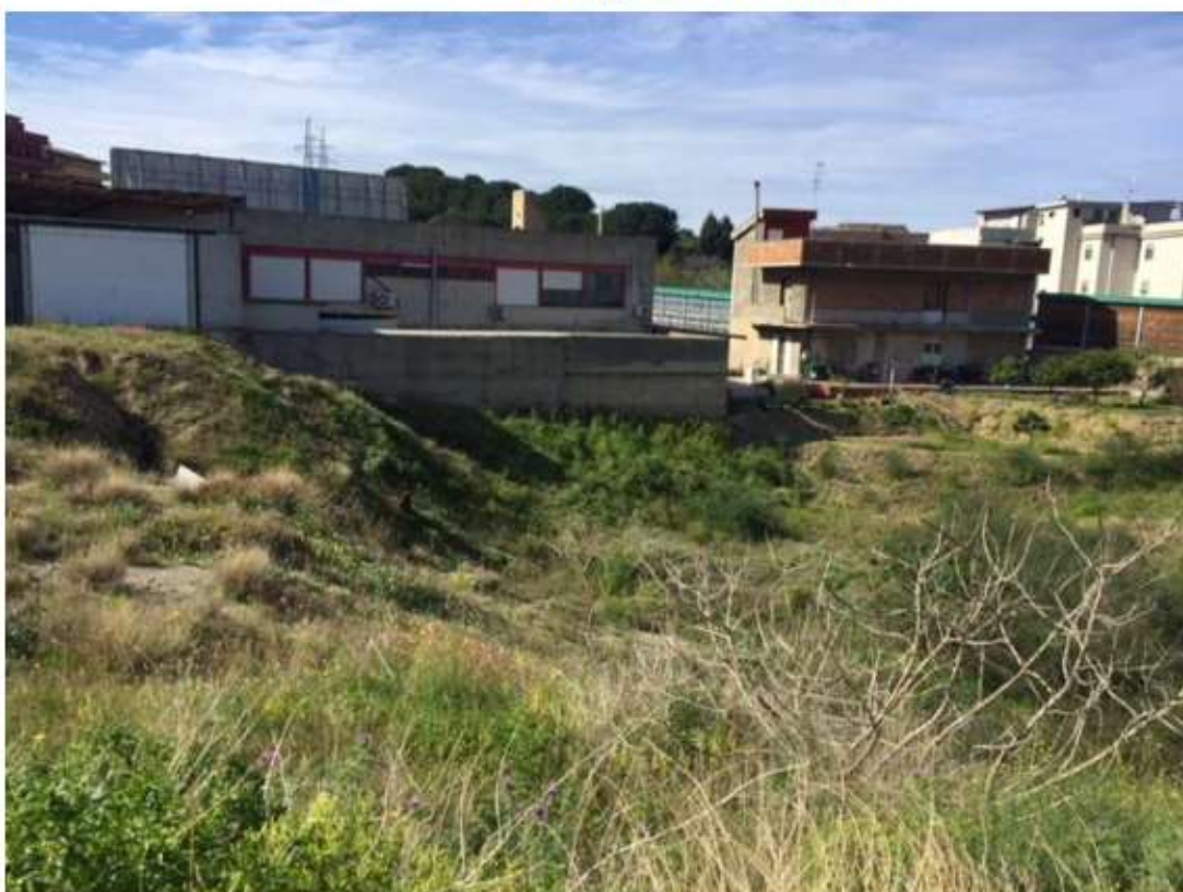
Foto 3 – Vista panoramica dell'Immobile 2
