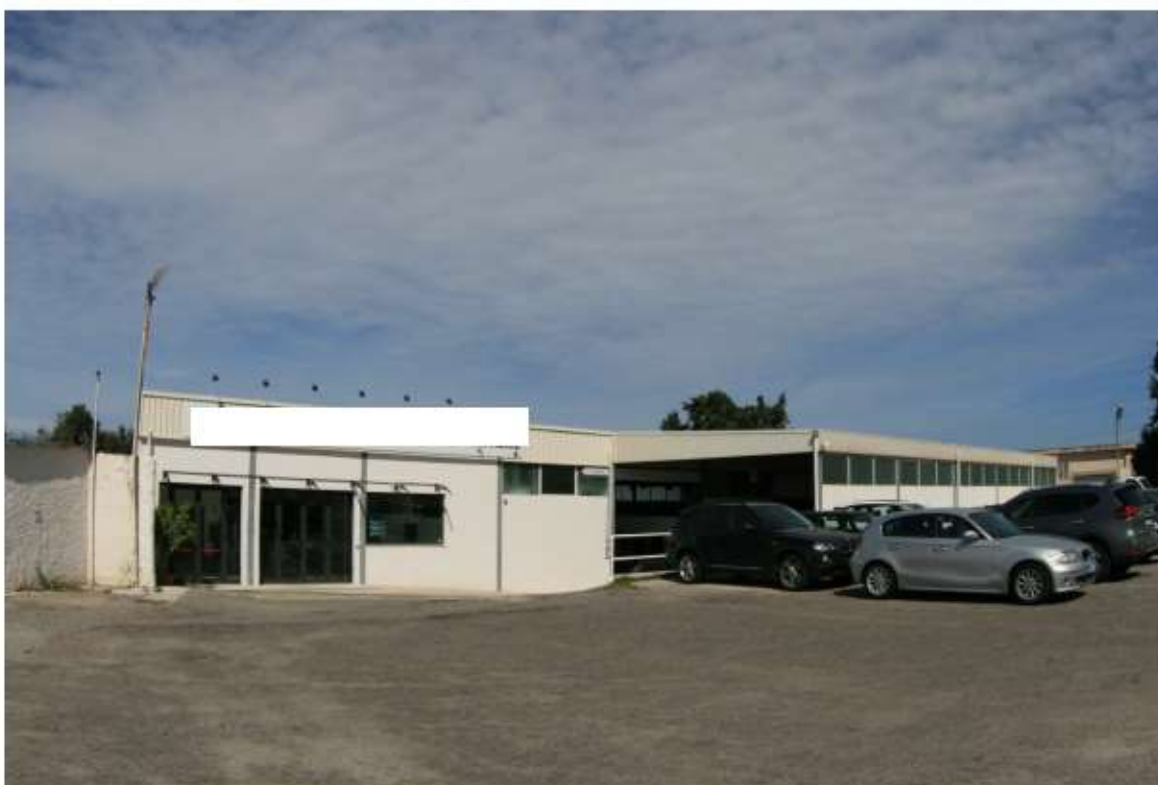
Foto 3 – Vista panoramica dell'Immobile 4
