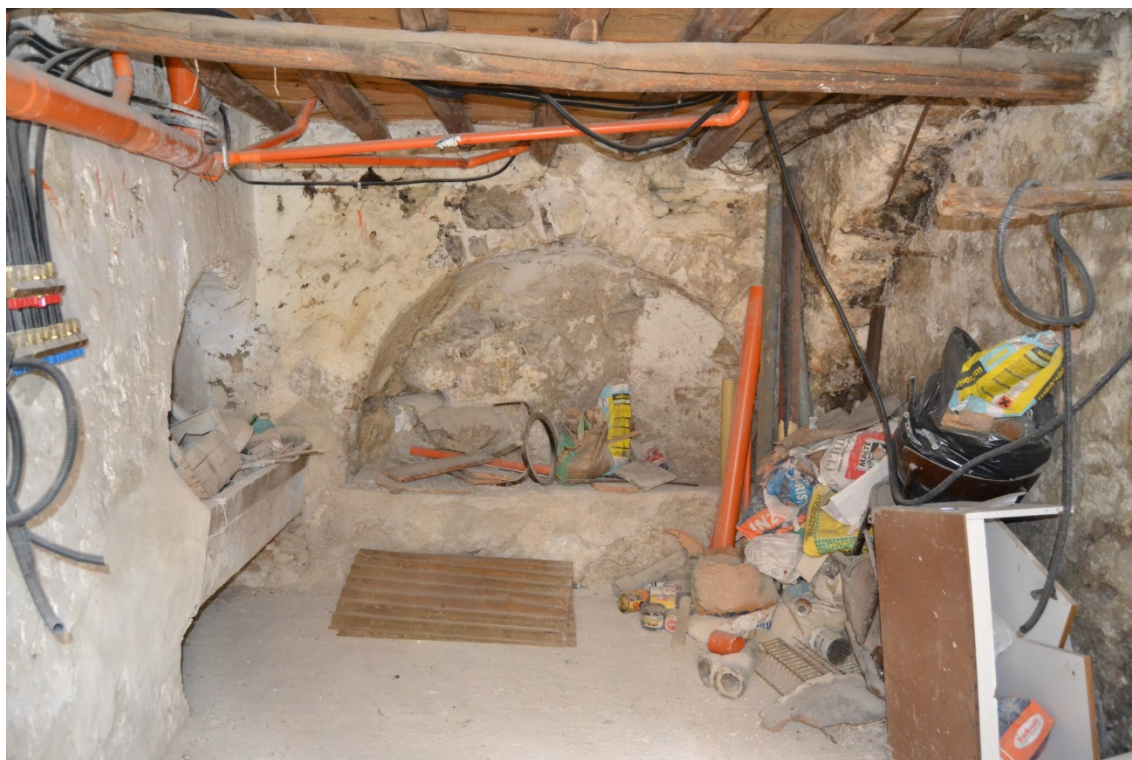
Fotografia 28 - P.I. - cantina, via Della croce n. 5
