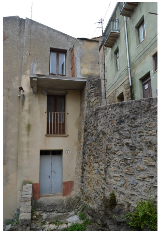
Fotografia 4 – Prospetto via Della Croce n. 5 Lotto Unico – Immobile identif. al N.C.E.U. del Comune di Gangi (PA), fg. M.U., part. n. 2671 – sub. n. 1 graffata a part. n. 2672 – sub. n. 2.
