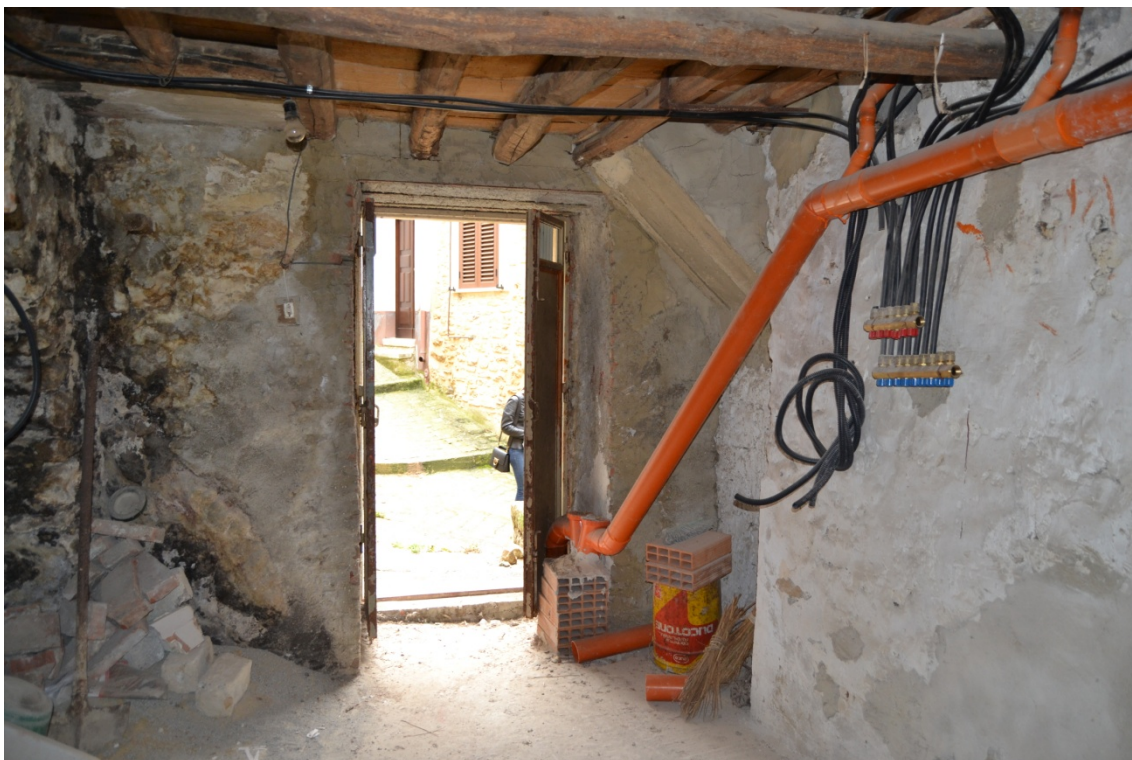
Fotografia 27 - P.I. - cantina, via Della croce n. 5
