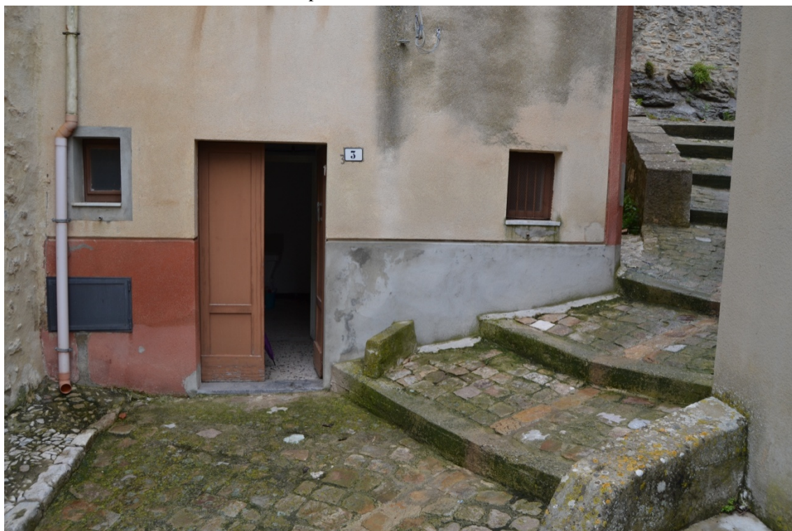
Fotografia 6 – Ingresso via Della Croce n. 3
