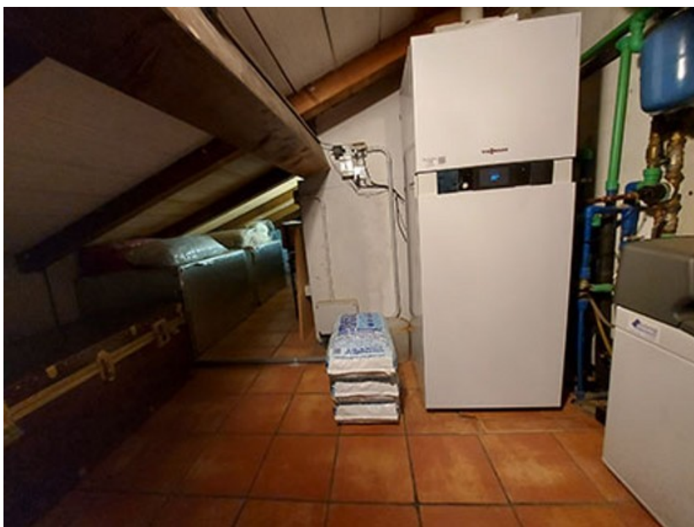
Fotografia H.40 - Soffitta - locale caldaia comune
