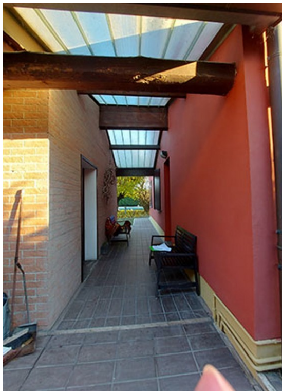
Fotografia H.10 - accesso coperto comune
