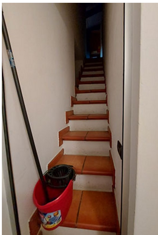
Fotografia H.39 - Scala per accesso soffitta
