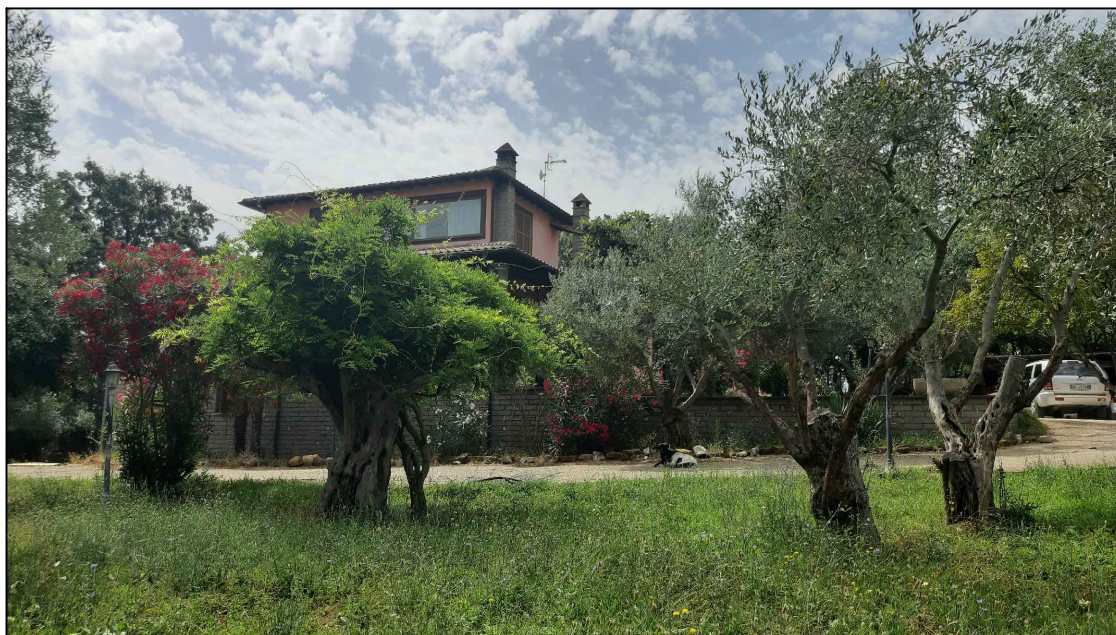
foto 5 - vista d'insieme dell'immobile dal terreno pertinenziale.
