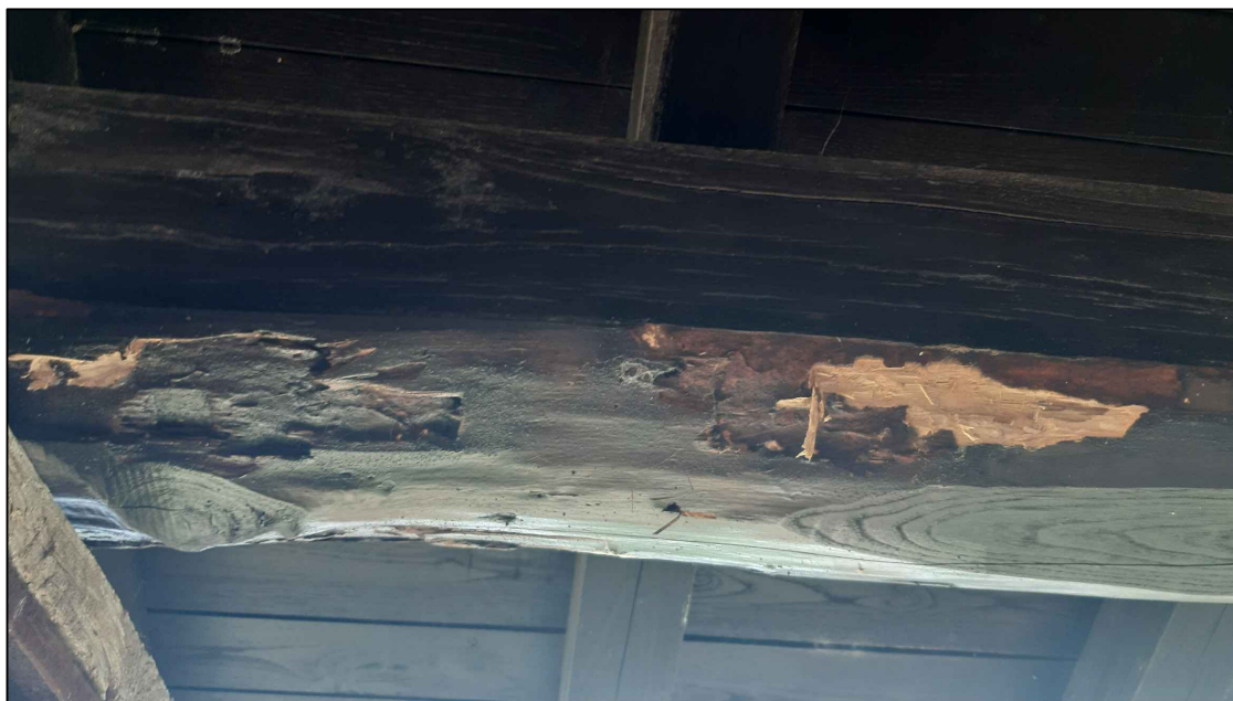
foto 9 - particolare di una porzione della travatura in legno del porticato attaccata dai tarli.
