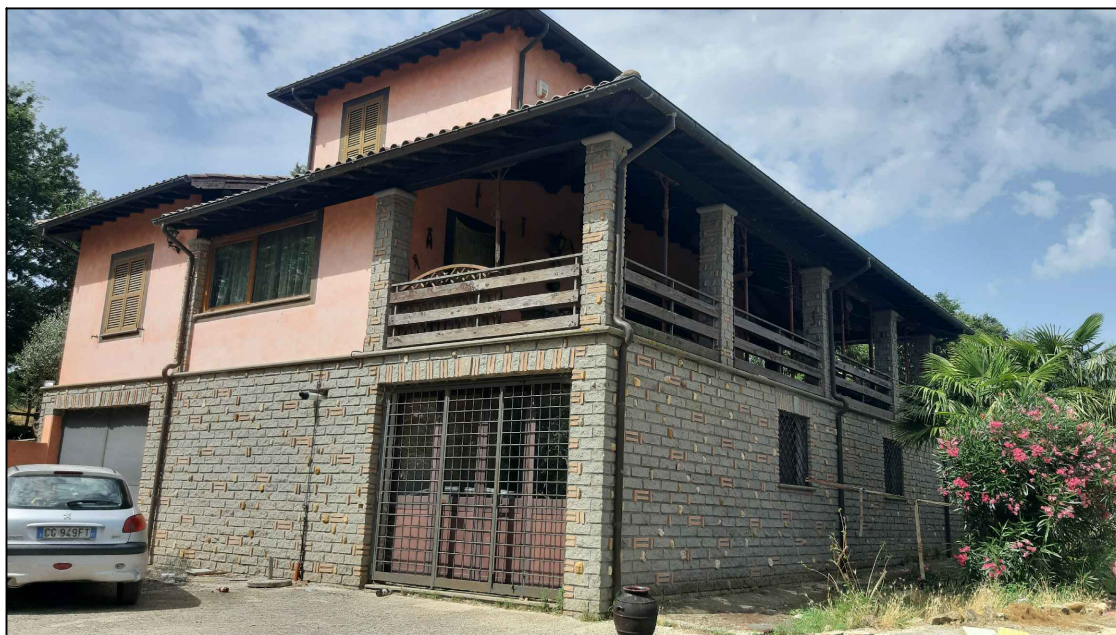
foto 3 - vista esterna dell'immobile dall'area pertinenziale.
