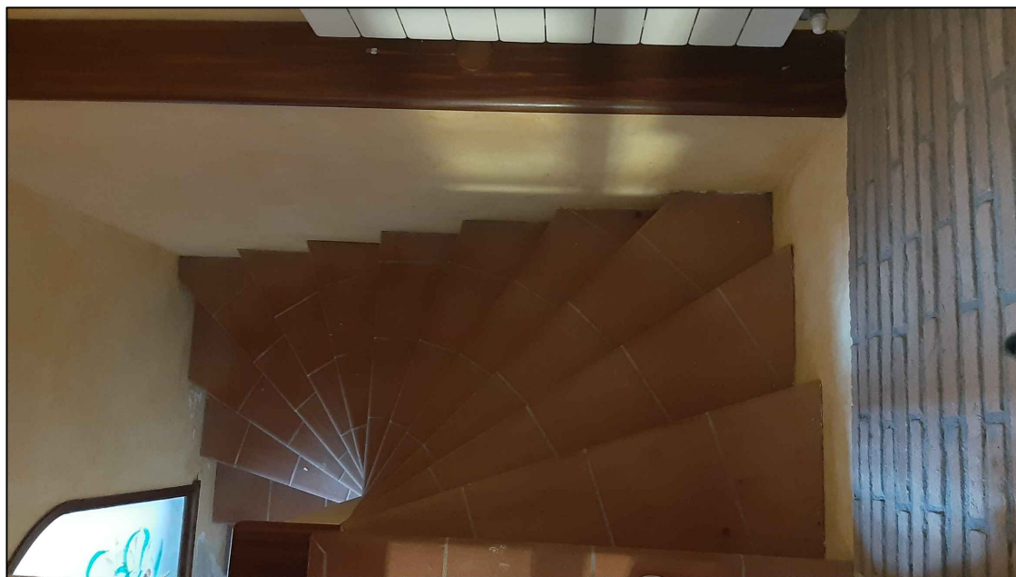
foto 21 - vista della scala di accesso al piano seminterrato.
