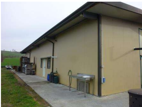
26a – Vista Nord-Ovest
