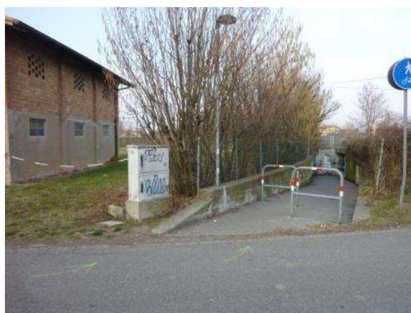
05a – Sbocco sottopasso Str. Prov.le 52
