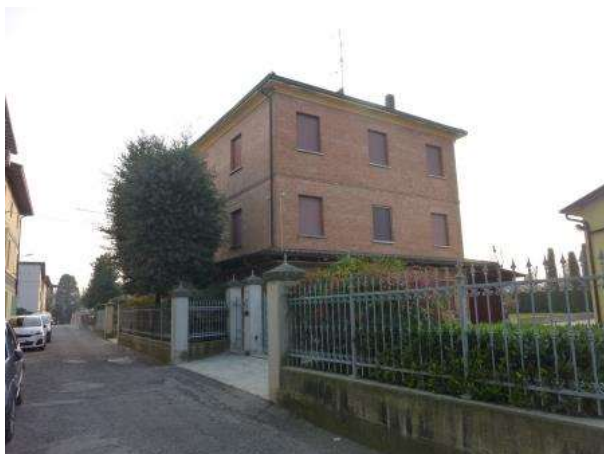
02a - Lato Nord-Est Sud-Ovest
