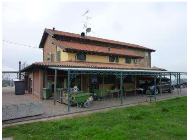
03a - Vista lato Sud-Est
