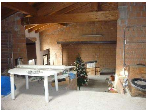
47b - Soffitta del C/2 sopra ex portico
