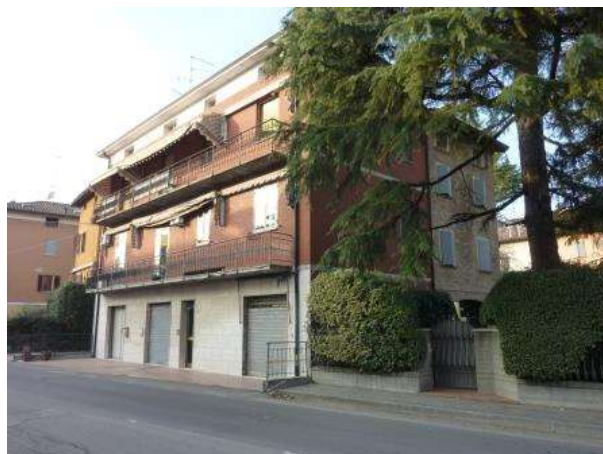
03a - Vista lato Sud-Est
