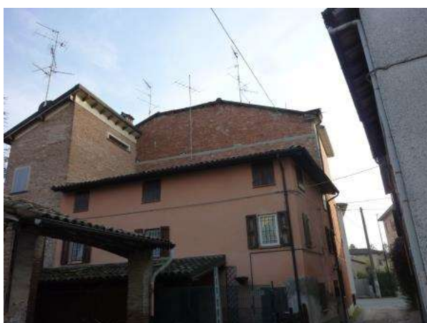
04a - Vista su lato Nord da stradello privato
