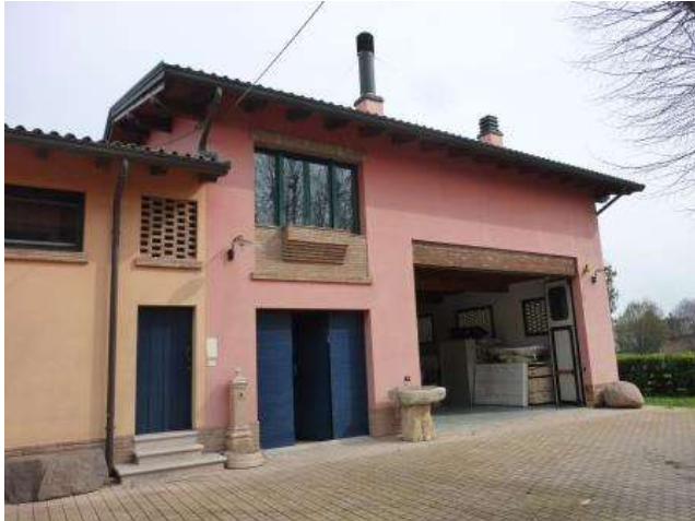
33b – Vista Sud Mapp. 199 Sub. 2
