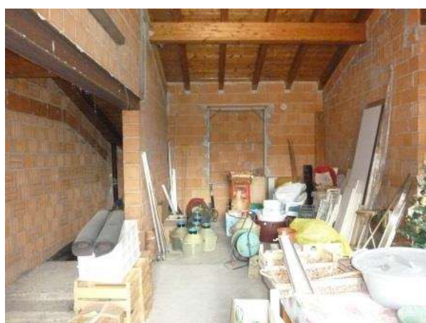
46b - Soffitta del C/2 sopra ex Stalla
