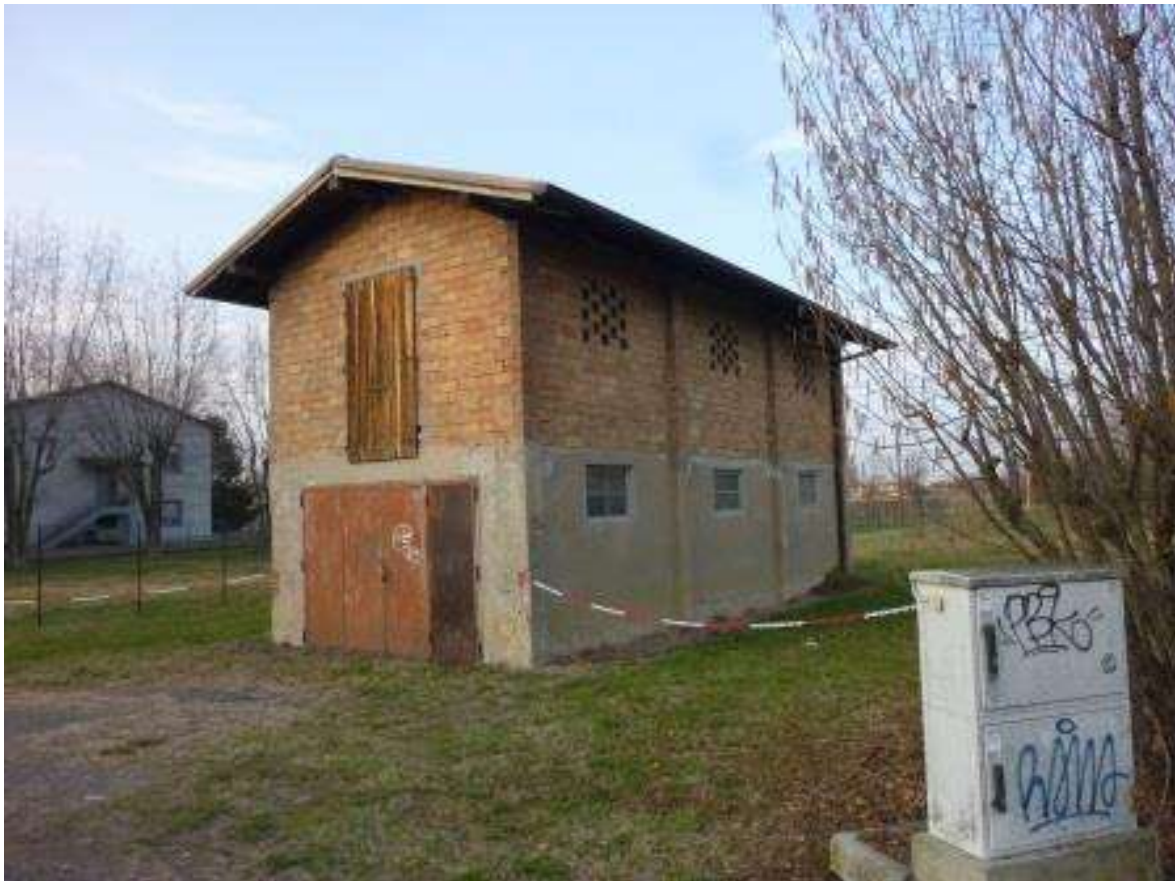
01a – Vista da Via Partitora – lato Sud-Est
