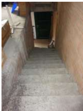
44b - Vista su scala di accesso al 1°P del C/2
