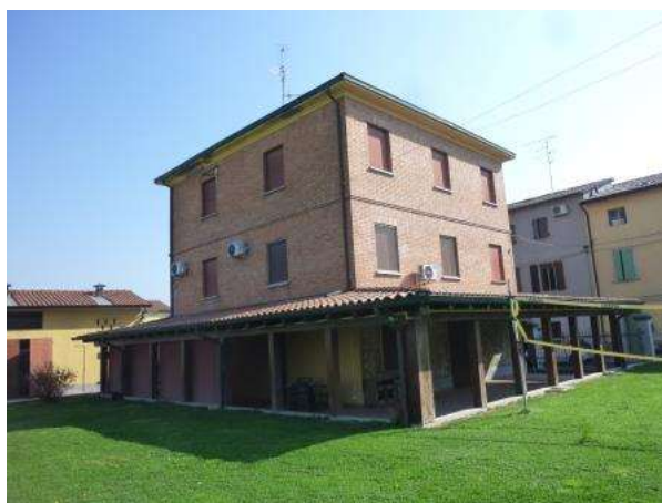
03a - Lato Sud-Ovest
