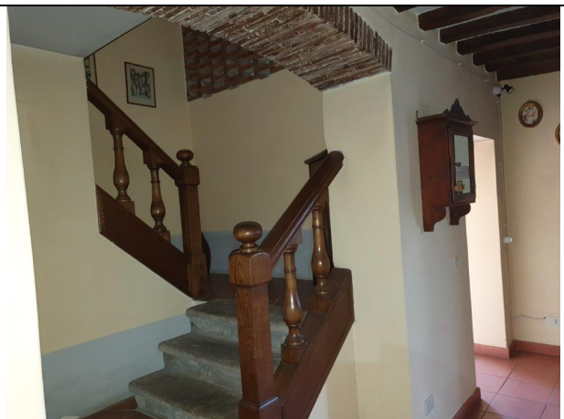
Foto 24 – P.T. Vano scala
