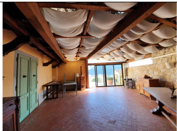
Foto 44 – Chiusura area esterna con vetrate e copertura
