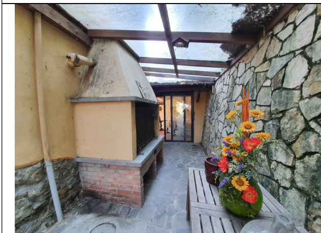
Foto 43 – P.T. Camino parete tergale esterna e chiusura area esterna con vetrate e copertura
