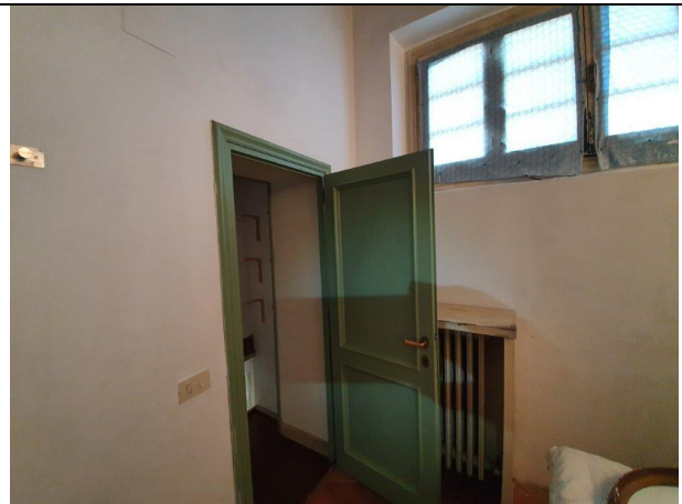
Foto 34 – P.2 Vano uso camera
