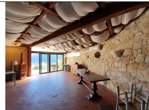
Foto 46 – Chiusura area esterna con vetrate e copertura
