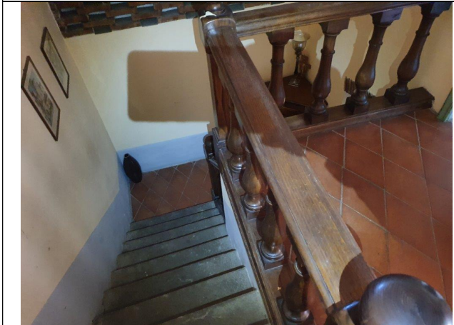
Foto 25 – P.I. Vano scala
