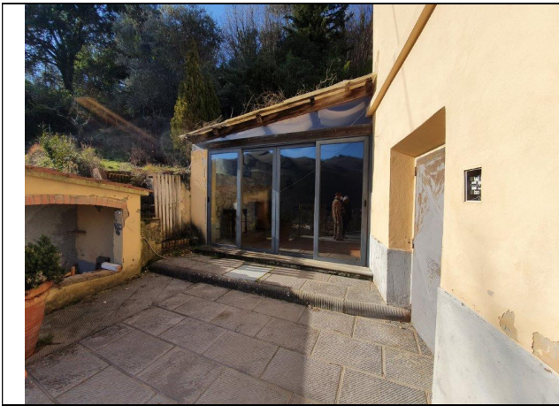
Foto 7 – Chiusura area esterna con vetrate
