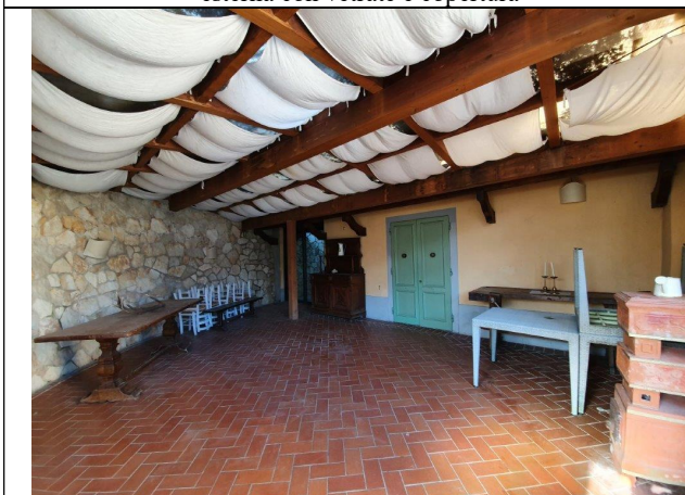
Foto 45 – Chiusura area esterna con vetrate e copertura
