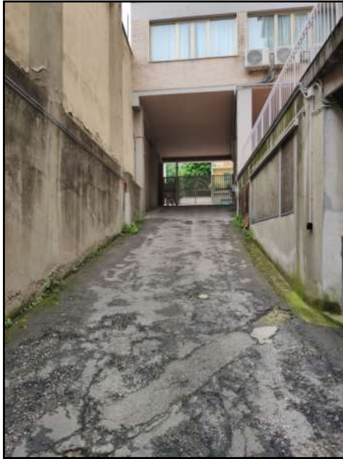
Foto 25 – Rampa carrabile a comune di accesso ai locali ad uso autorimessa del piano seminterrato
