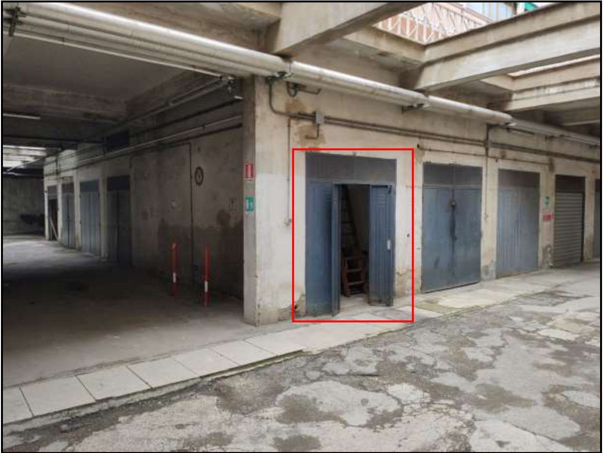
Foto 27 – Viabilità carrabile condominiale con vista locali ad uso autorimessa
