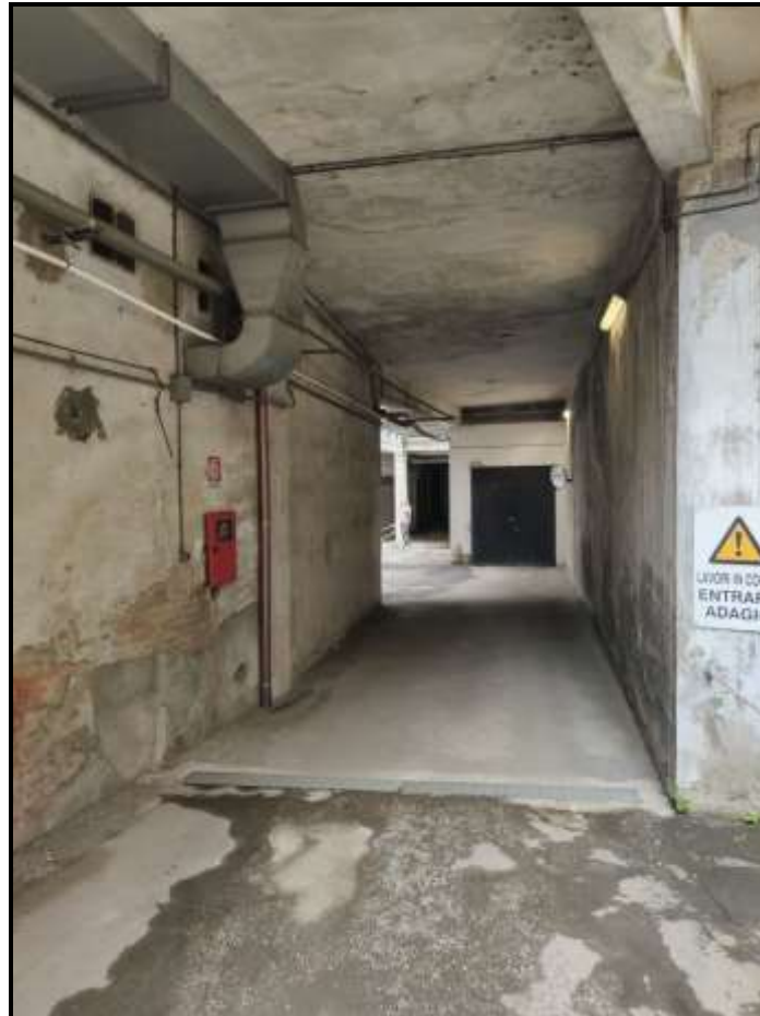
Foto 26 – Viabilità carrabile condominiale piano seminterrato
