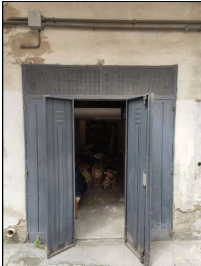
Foto 28 – Locale ad uso autorimessa
