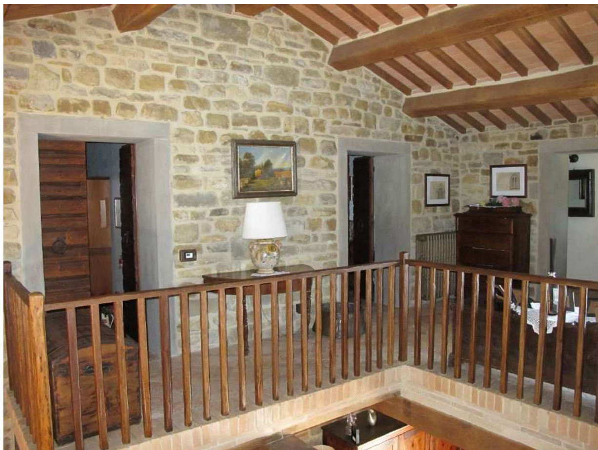
Ingresso comune (sub. 3) accesso ai sub. 6, 7 e 8 – vano n. 16 in planimetria
