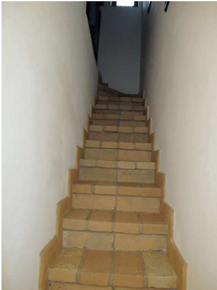
Vano scale PT-1 (p.lla 540)
