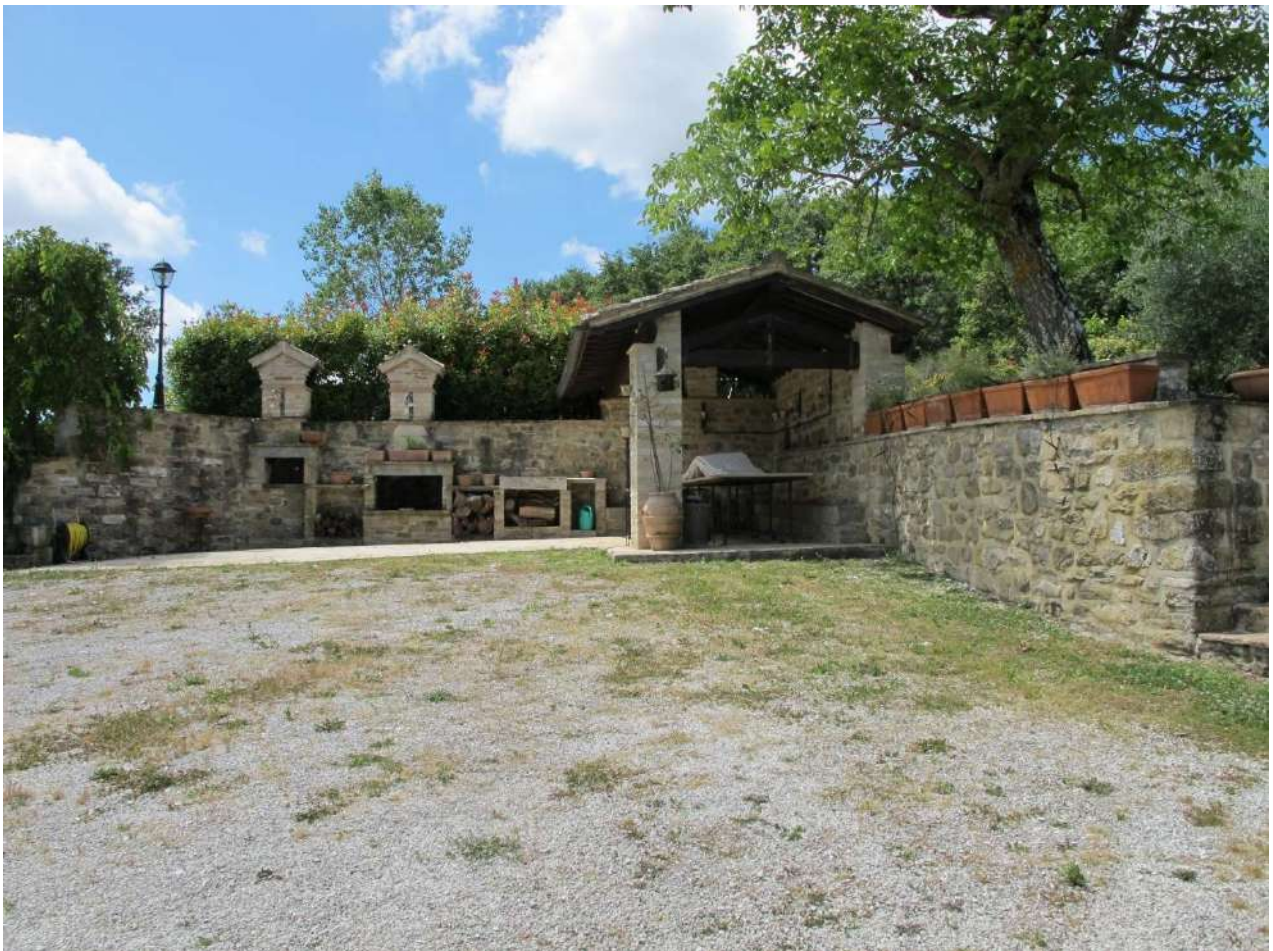
Esterni – dettaglio tettoia e forni (p.lla 36, fabbr. rurale)
