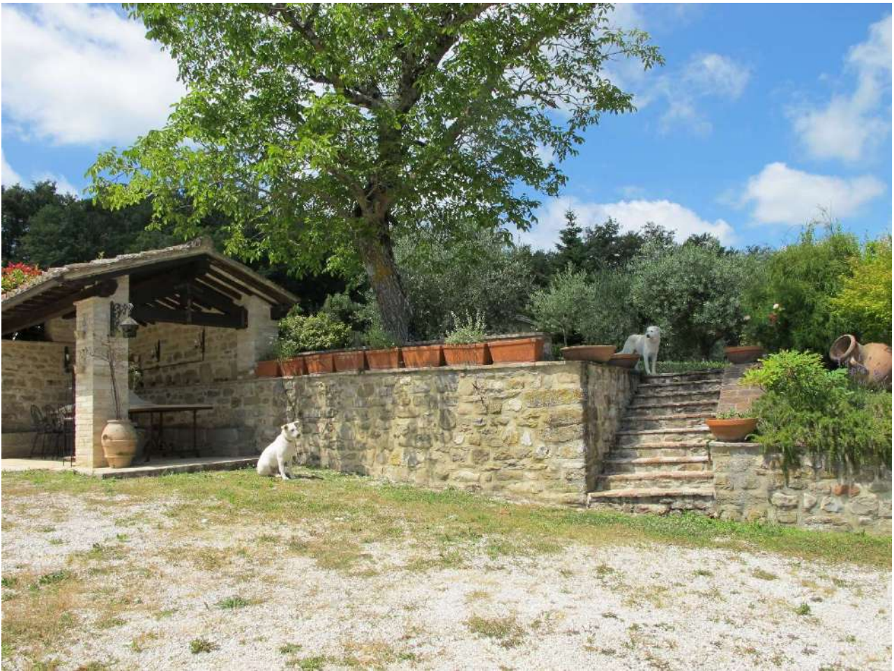
Esterni – dettaglio tettoia e forni
