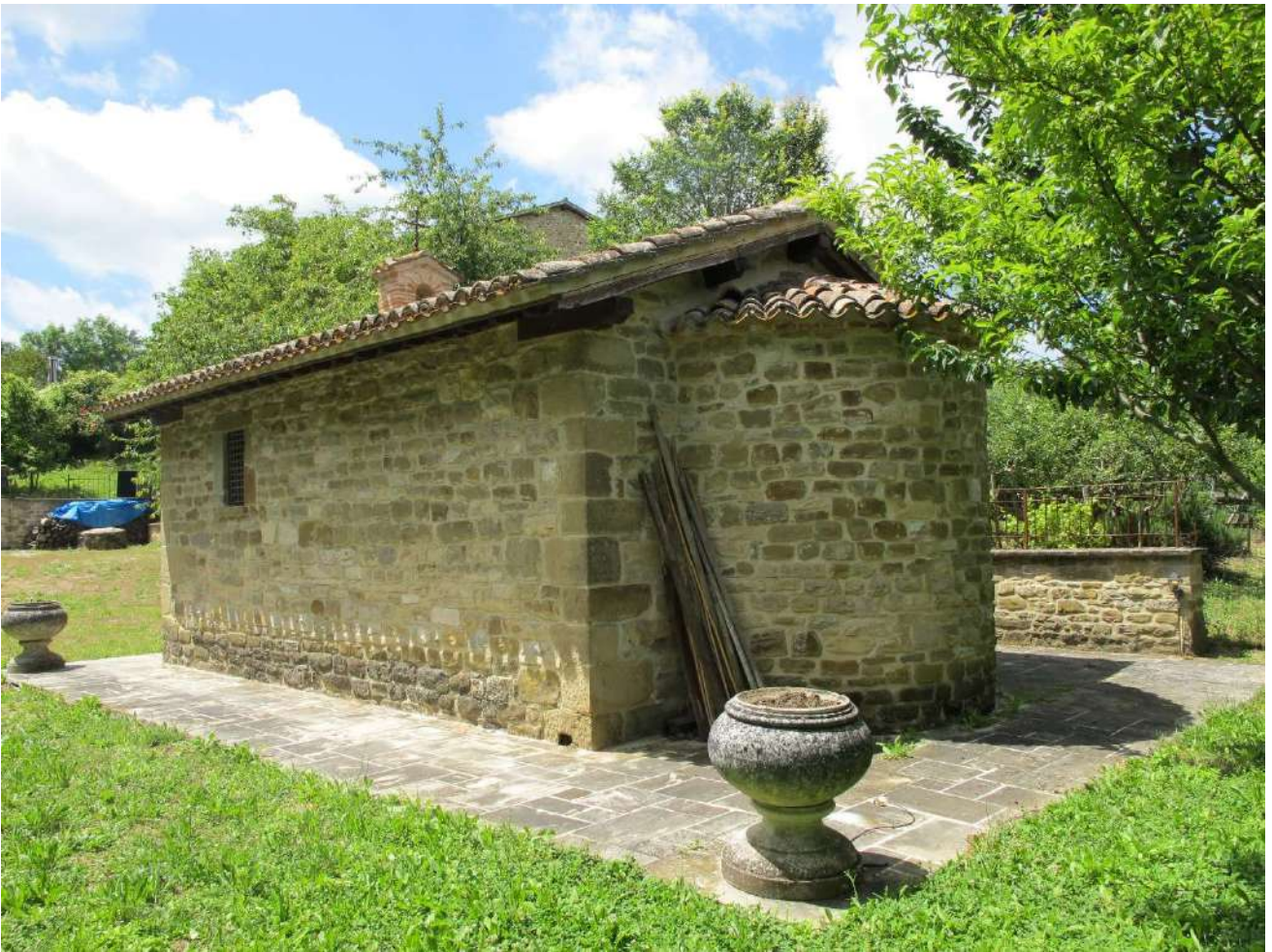
Esterno Cappella (p.lla 543)
