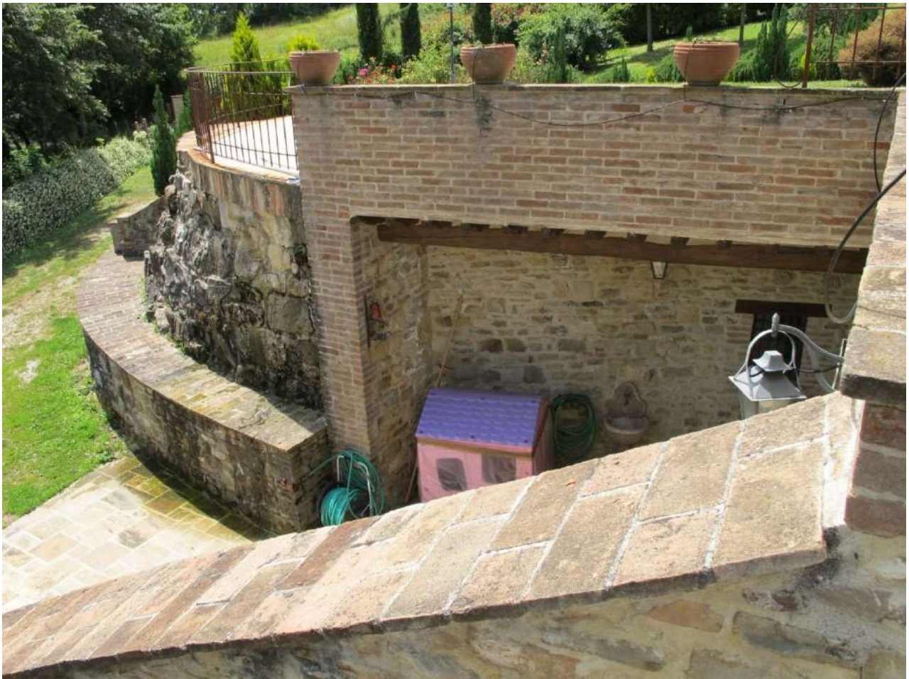
Esterni – dettaglio accesso ai locali seminterrati
