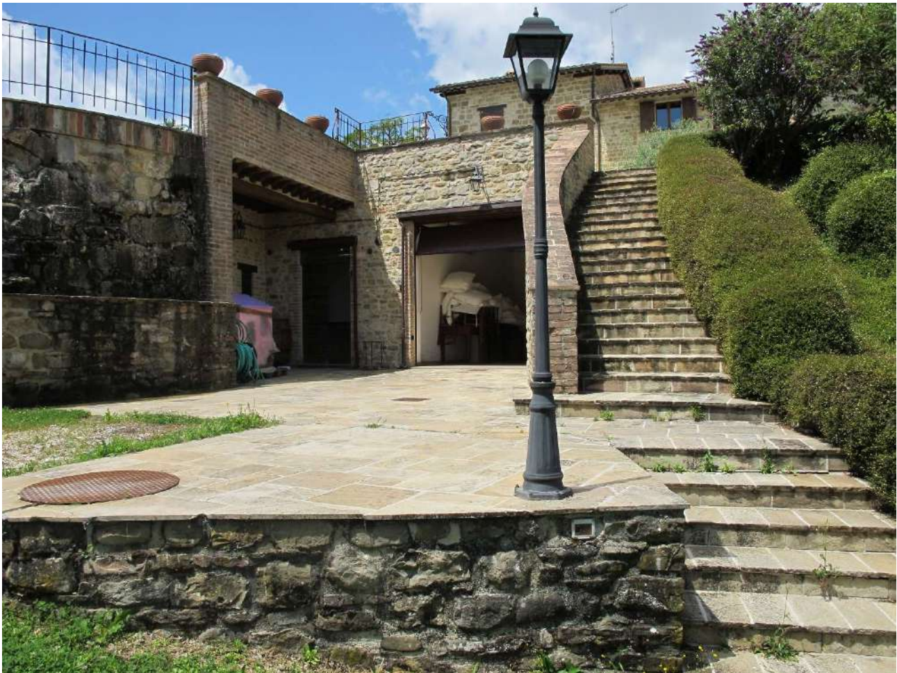
Esterni – dettaglio accesso ai locali seminterrati
