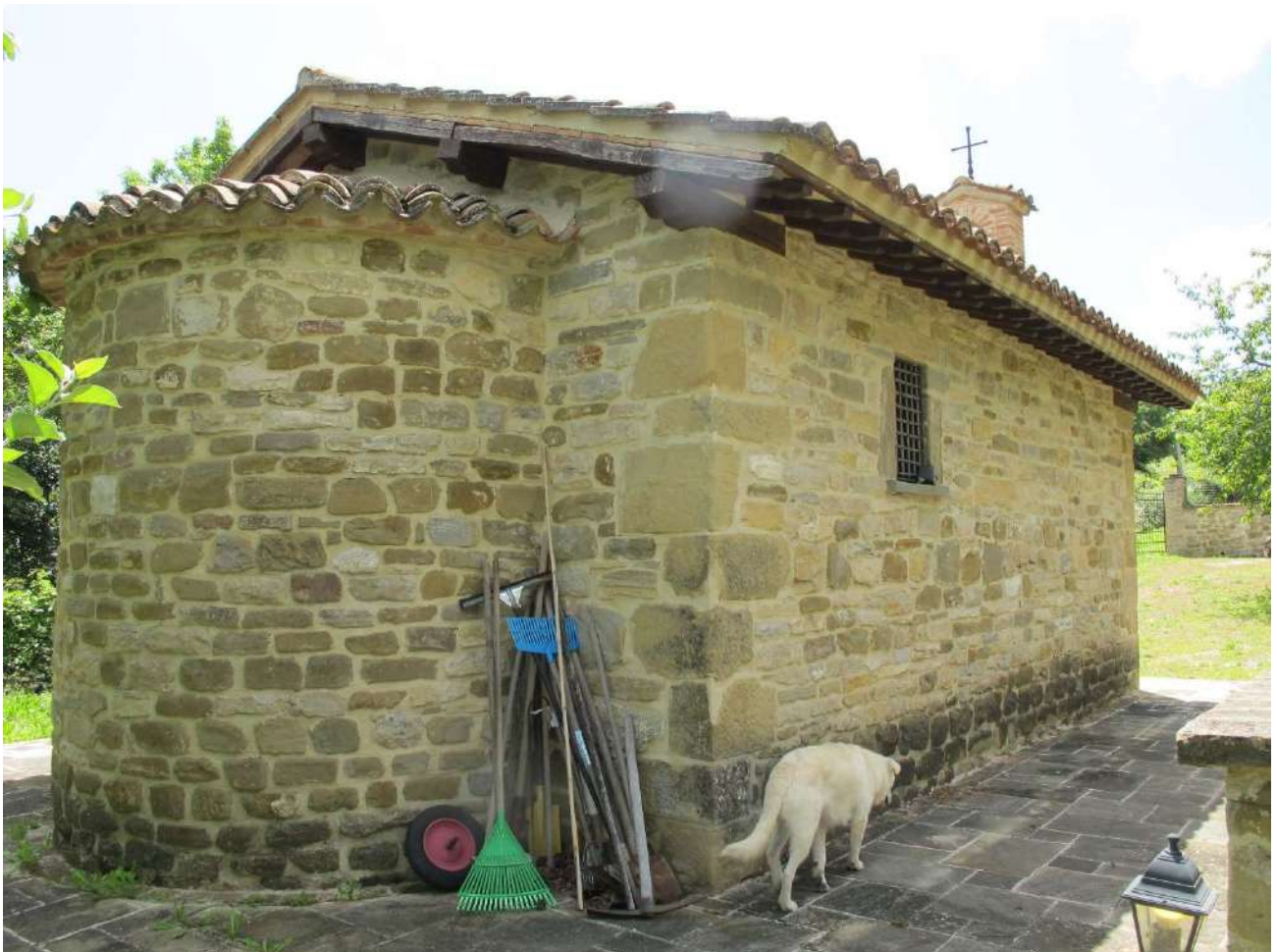
Esterno Cappella (p.lla 543)
