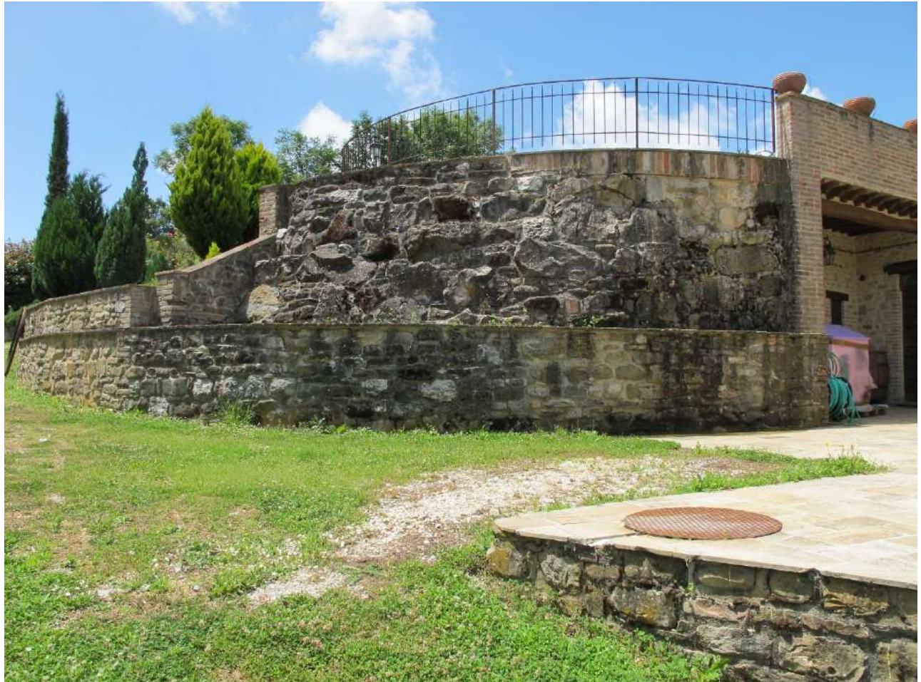
Esterni – dettaglio accesso ai locali seminterrati
