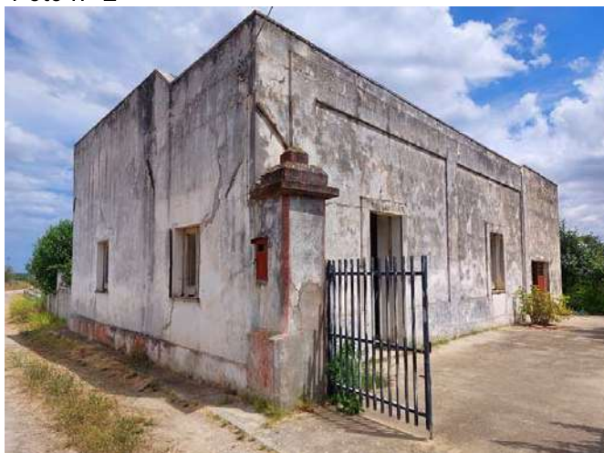
Ingresso a cortile e terreno
