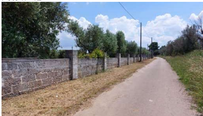
Recinzione su Strada Vicinale Fontana
