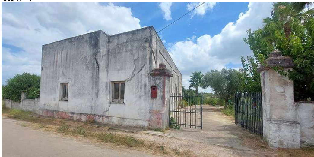
Prospetto esterno – Strada Vicinale Fontana
