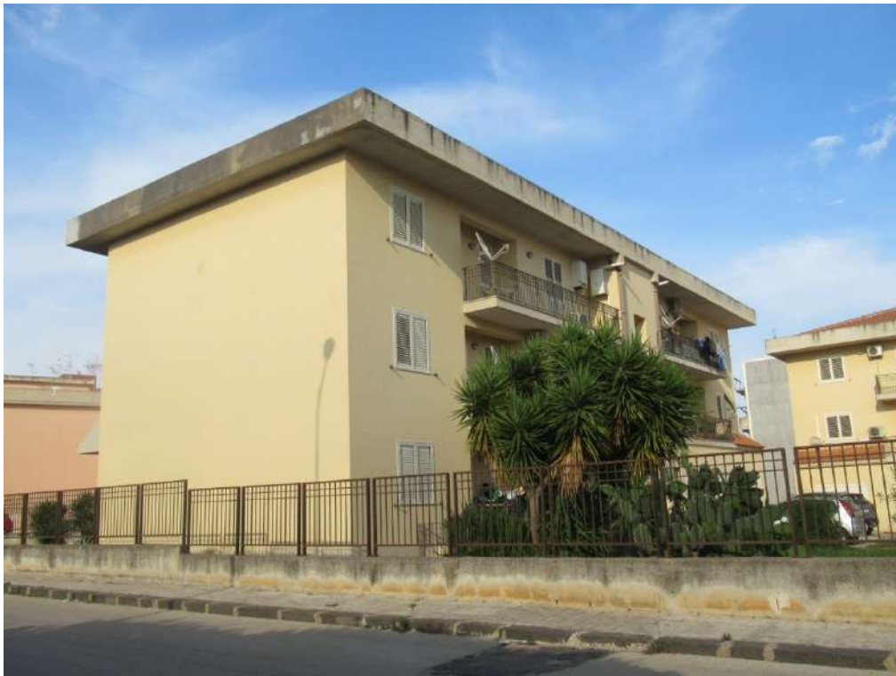
Foto 5_ Prospetto stabile laterale
