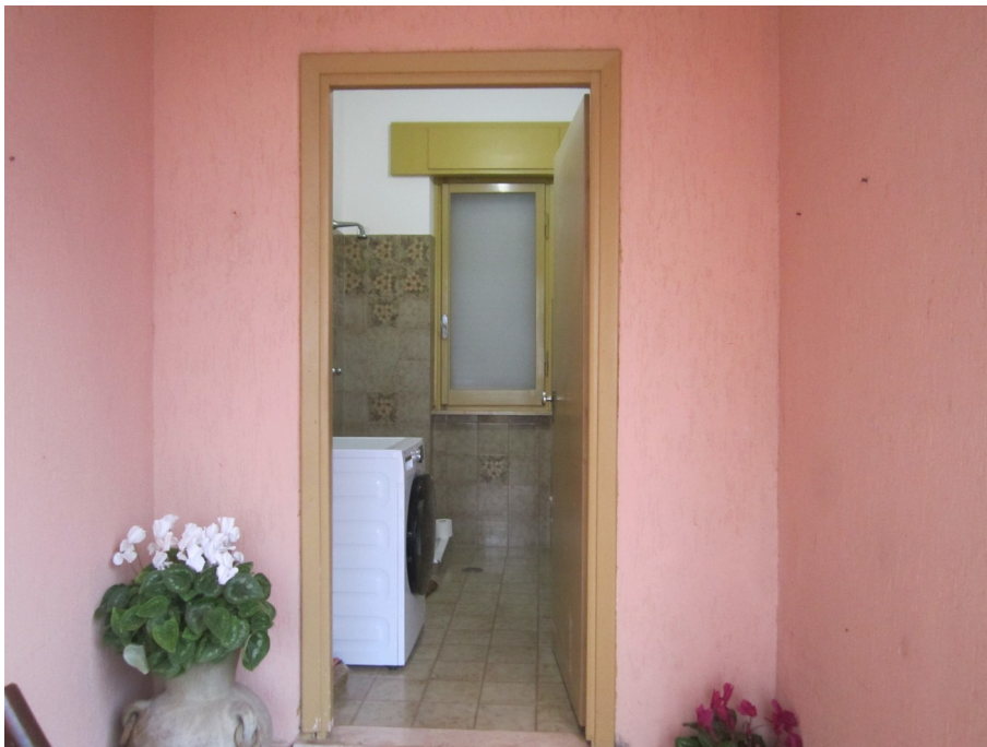
Immagine 16 – Viste esterne all'abitazione. Portico, accesso al bagno esterno.
