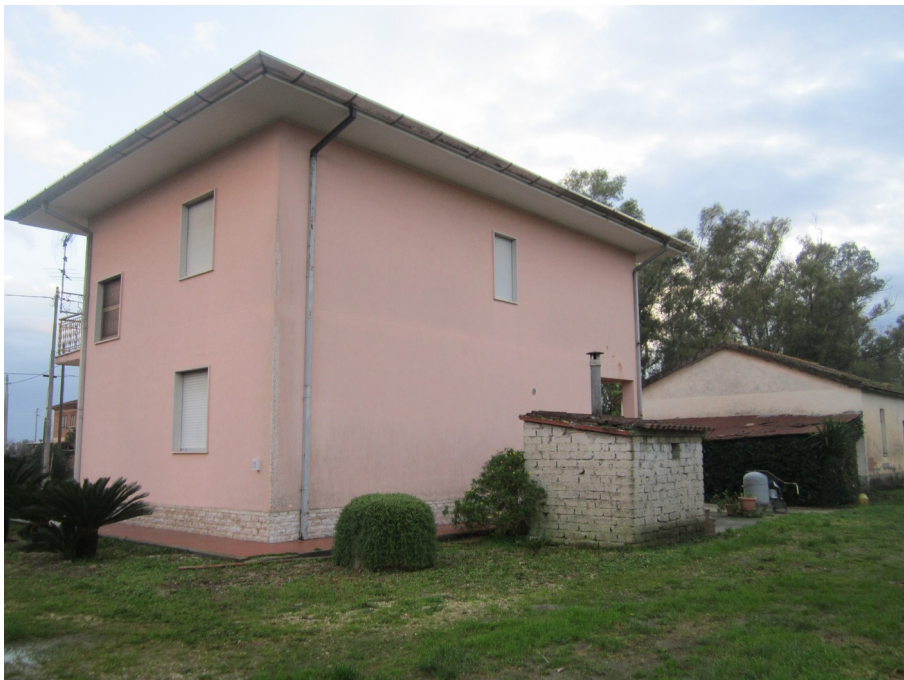
Immagine 2 _ Prospetti Nord Est + Nord Ovest con vista su locale caldaia.
