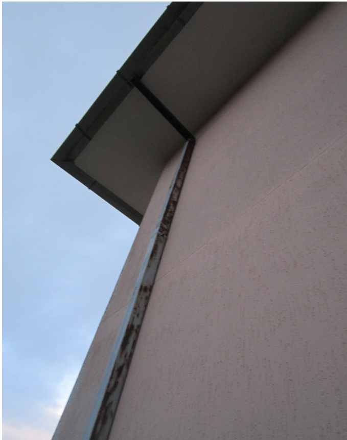
Immagine 18 – Viste esterne. Particolare cornicione, gronda e discendente.
