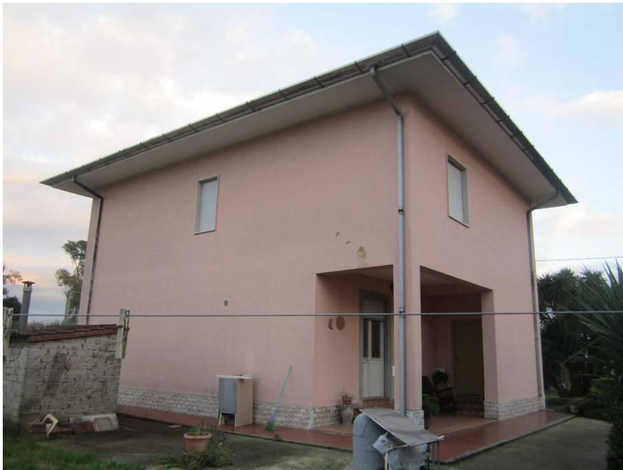
Immagine 3 _ Prospetti Nord Ovest + Sud Ovest con vista su locale caldaia
