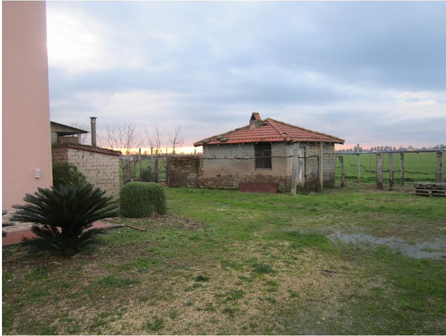
Immagine 19 _ Vista su annessi: Locale caldaia e pollaio/porcile.
