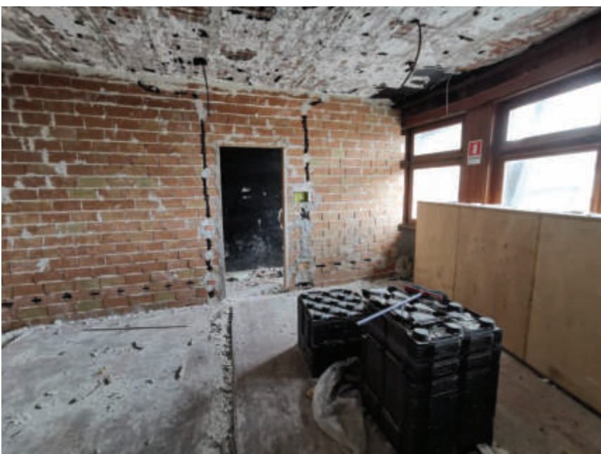
Foto 23 – Piano terra, Vista interna
