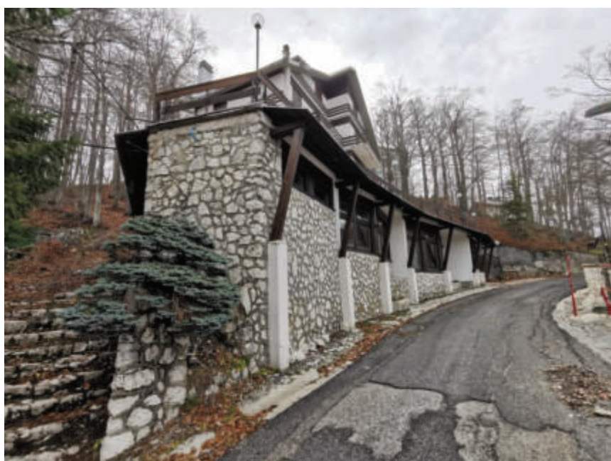
Foto 5 – Prospetto lato nord
