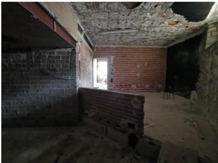
Foto 27 – Piano terra, Vista interna
