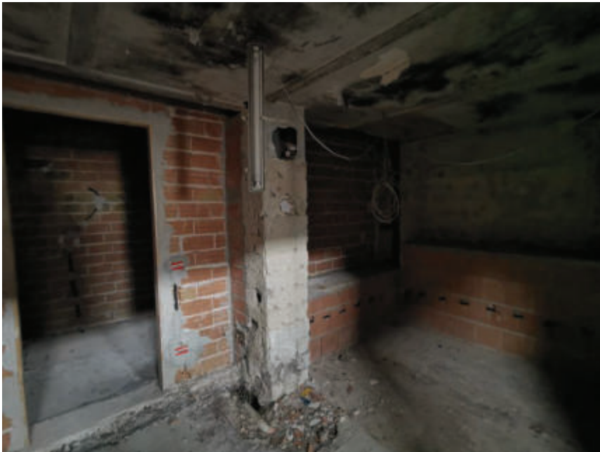
Foto 19 – Piano terra, Vista interna
