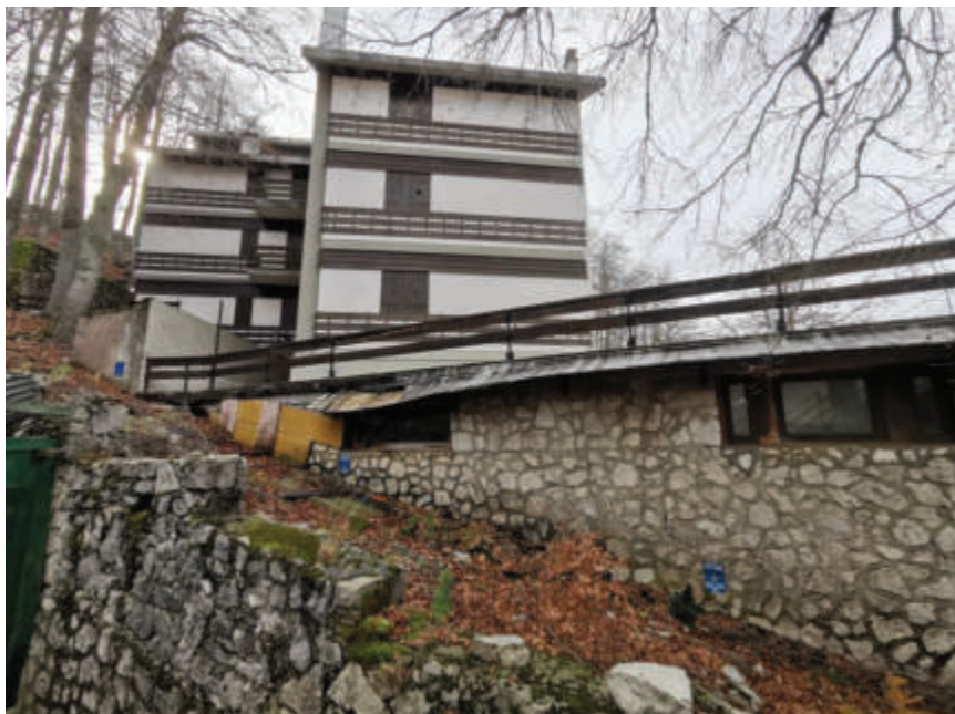
Foto 3 – Prospetto lato nord-est
