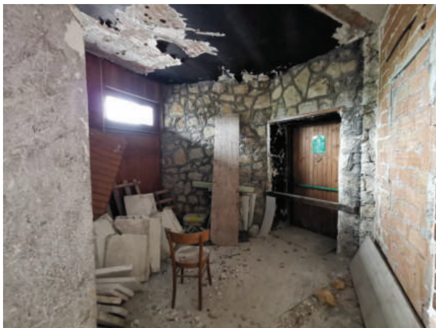
Foto 24– Piano terra, Vista interna
