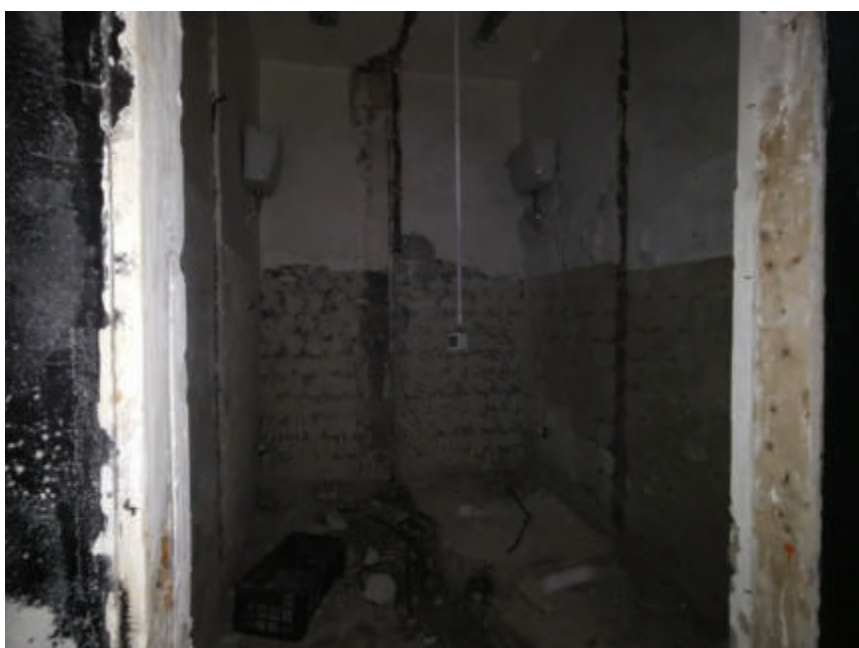
Foto 11 – Piano terra, Vista interna
