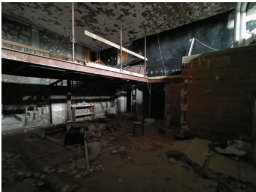
Foto 13 – Piano terra, Vista interna
