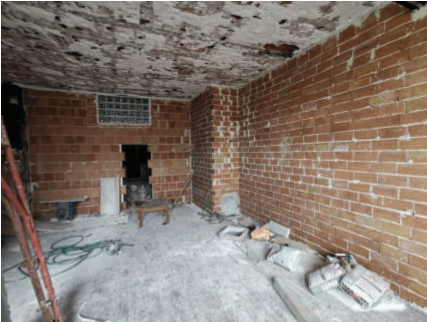
Foto 21 – Piano terra, Vista interna
