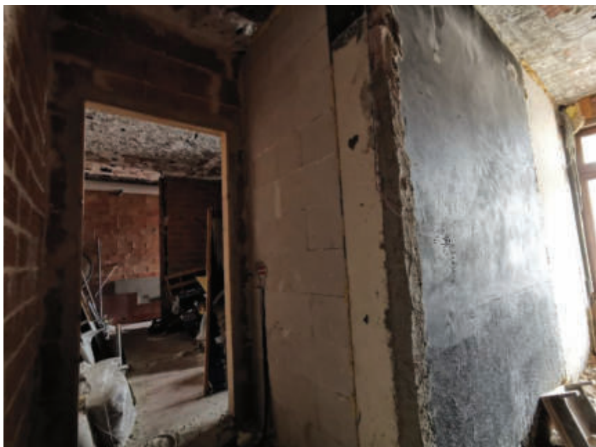
Foto 9 – Piano terra, Vista interna
