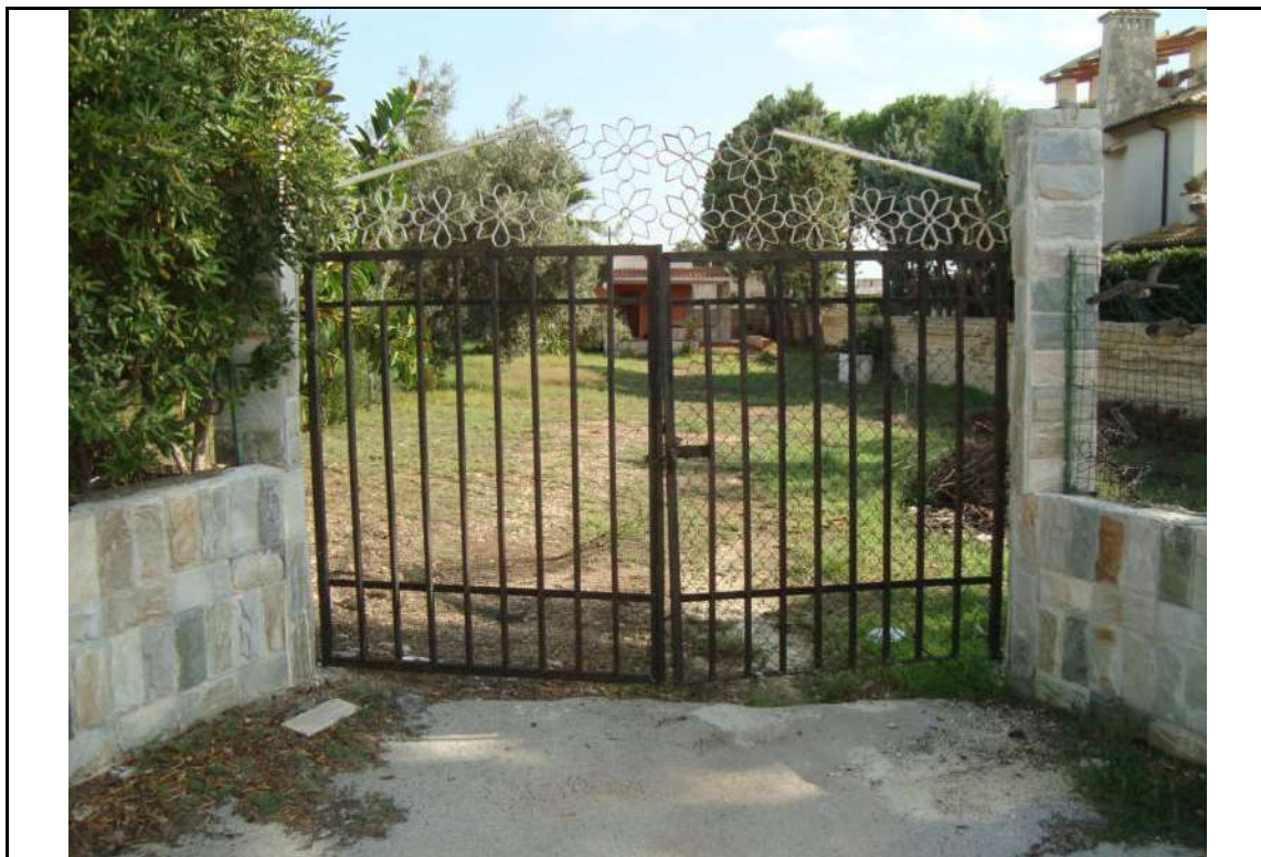
Foto n° 1. – Cannello di ingresso – via Lago Ampollino snc
