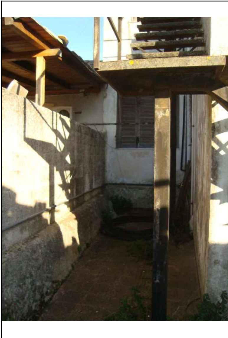
Foto n° 27. – Facciata – via per Canicattini n.18
