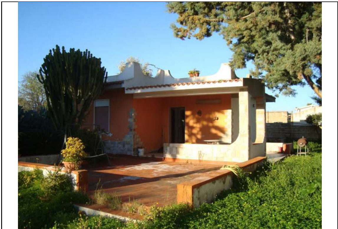
Foto n° 8. – Facciata – via Lago Ampollino snc
