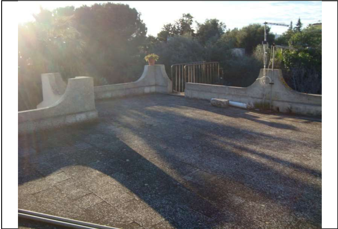
Foto n° 19. – Lastrico solare – via Lago Ampollino snc
