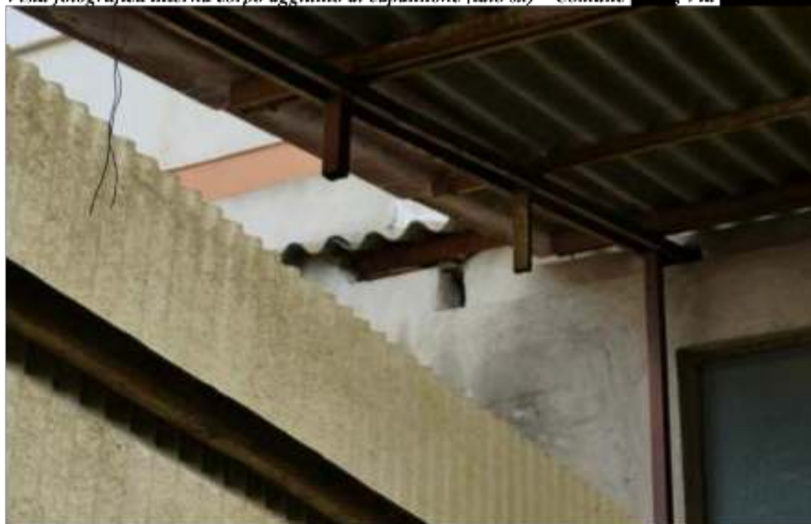
Part. fotografico corpo aggiunto al capannone (lato edificio [redacted])
