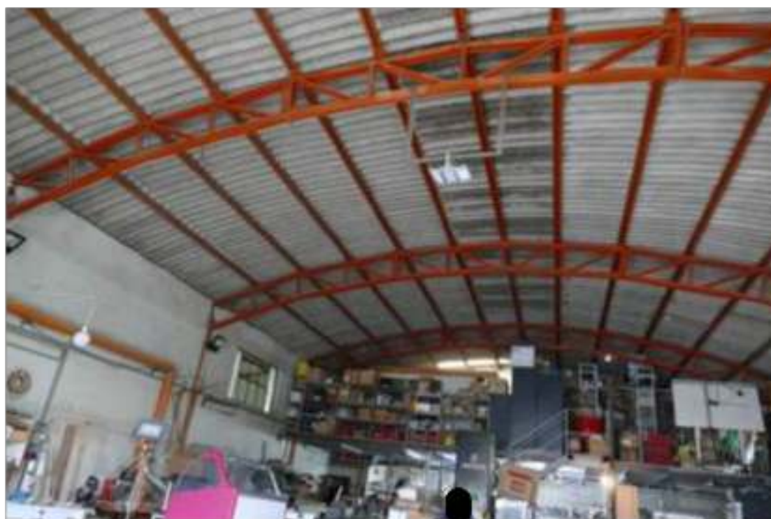
Particolare fotografico capannone industriale (strutture di copertura)
