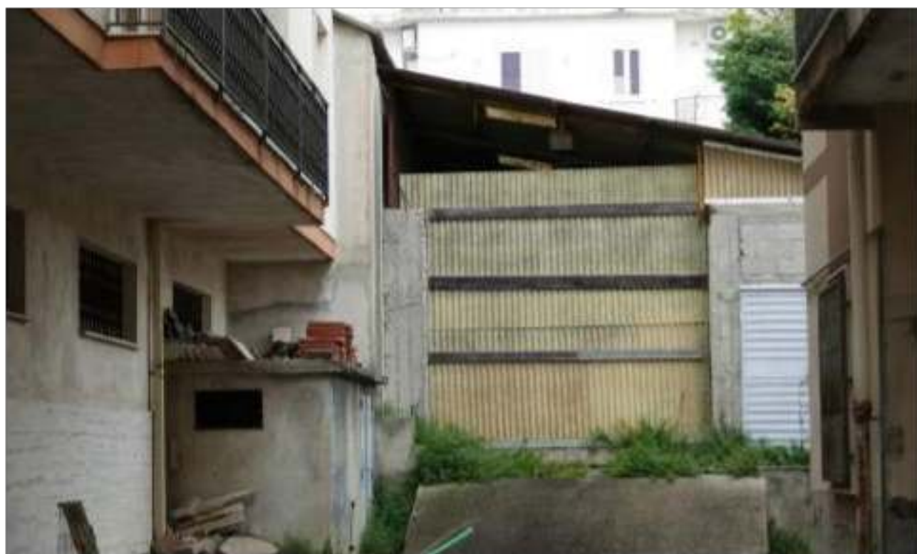
Part. fotografico corpo aggiunto al capannone (lato edificio [redacted])
