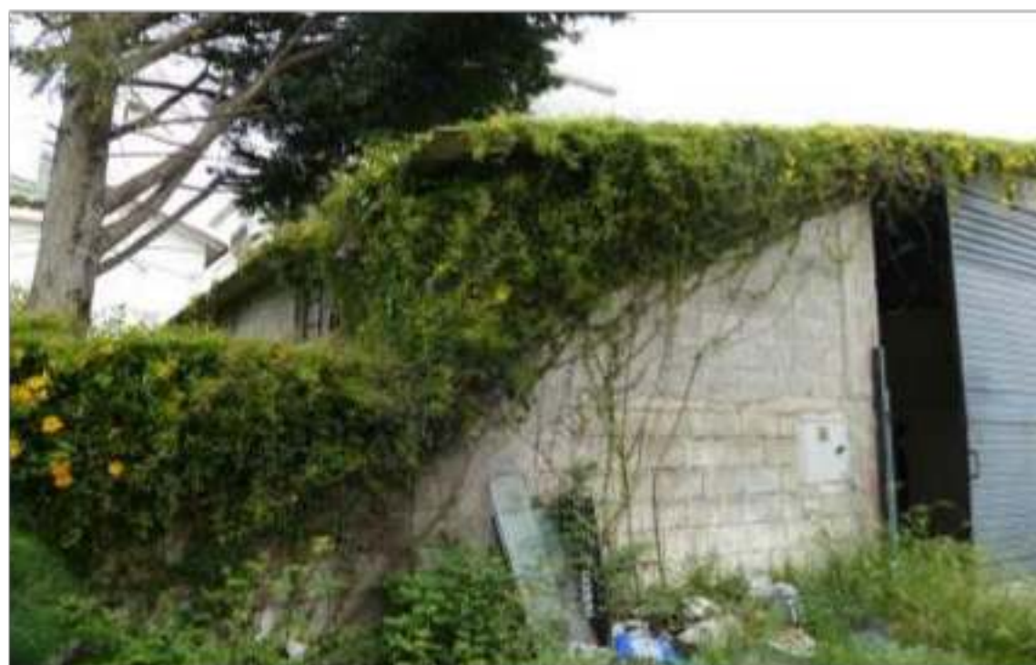
Vista fotografica corpo aggiunto al capannone (lato sx) – Comune [redacted], Via [redacted]
