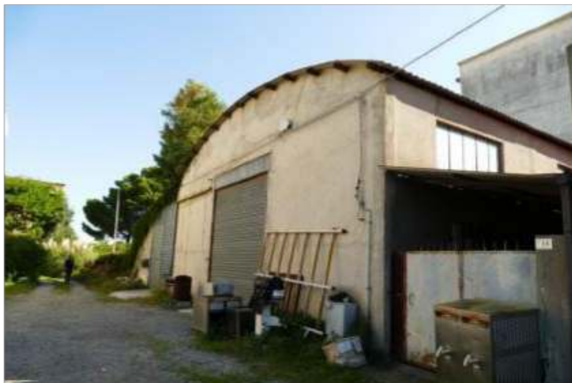
Particolare fotografico capannone industriale (settore falegnameria)
