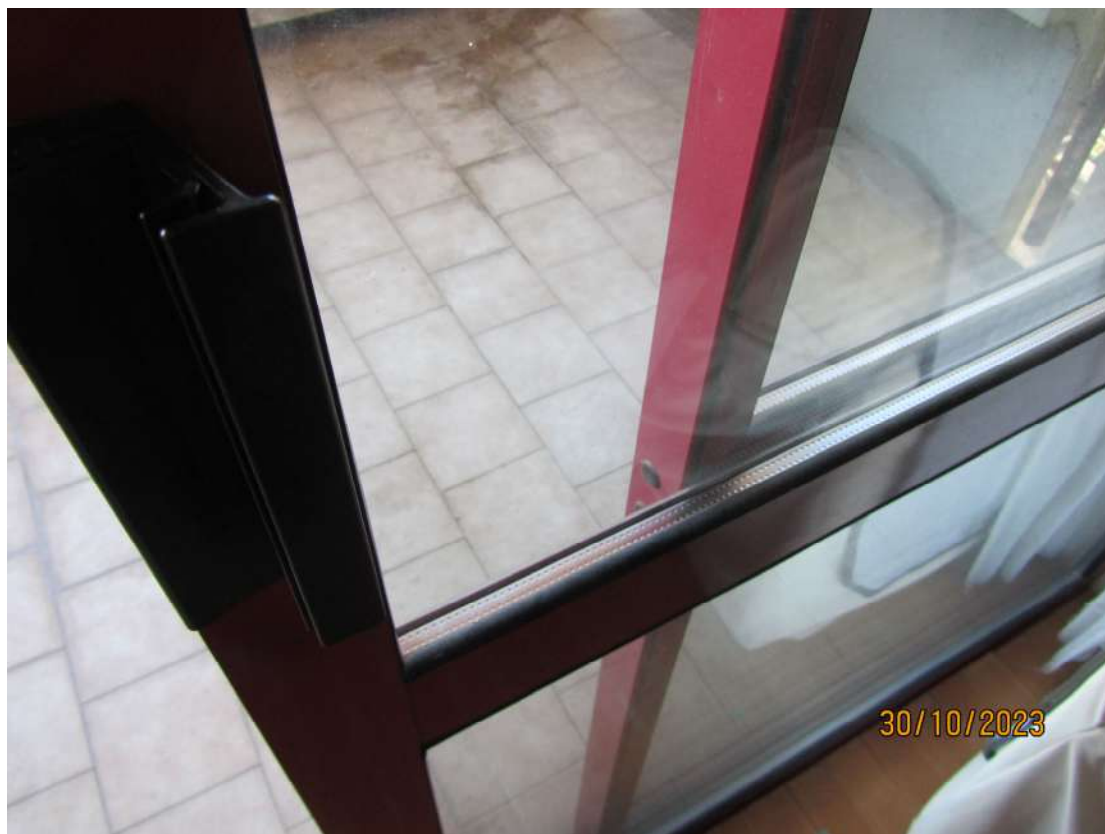
FOTO 16 - PARTICOLARE INFISSI SCORREVOLI.
