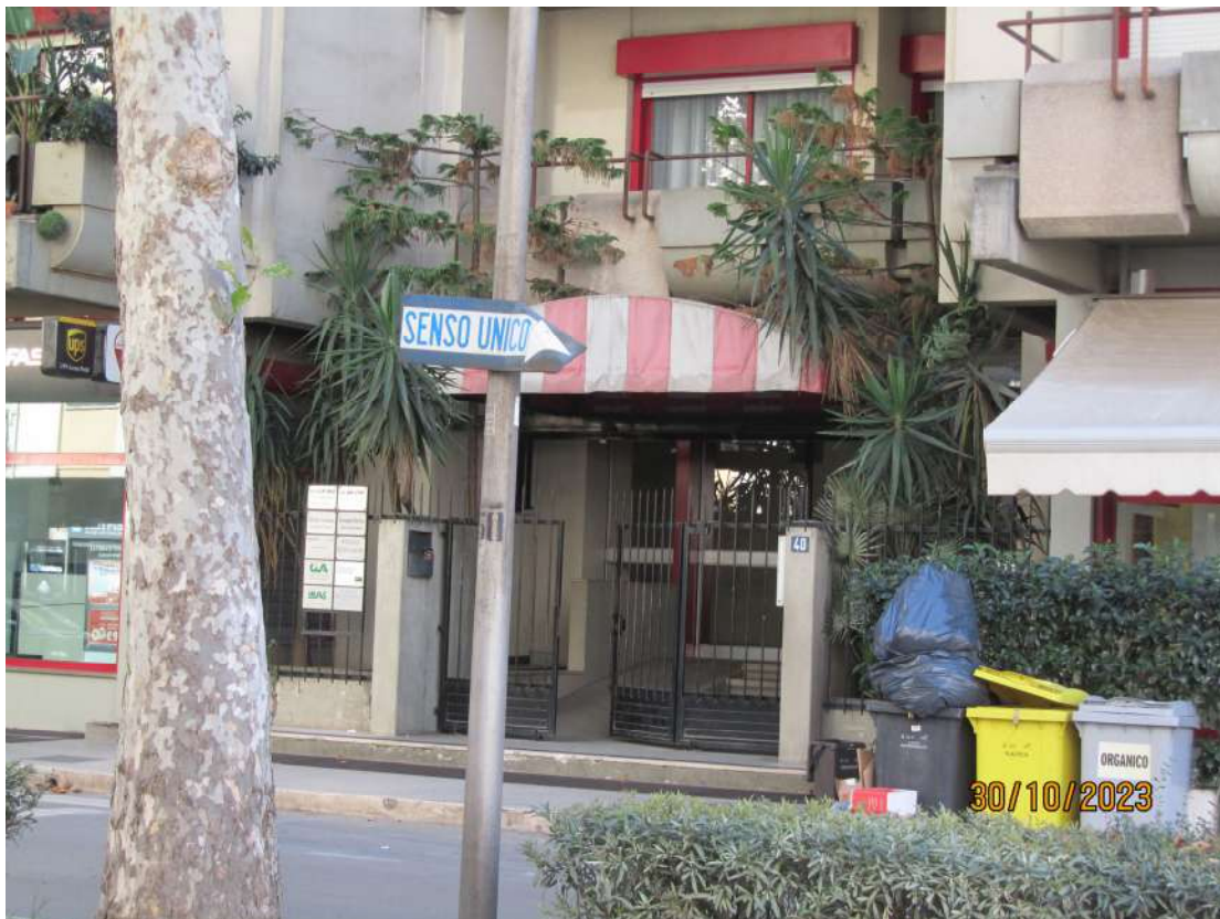
FOTO 2 - INGRESSO CONDOMINIALE VIA F.LLI ROSSELLI N.40.
