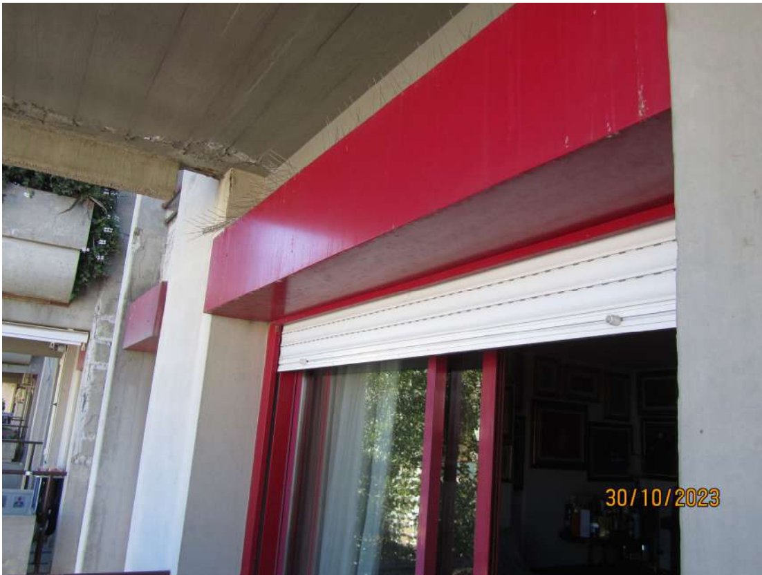
FOTO 17 - PARTICOLARE CASSONETTI ESTERNI E TAPPARELLE IN PVC.
