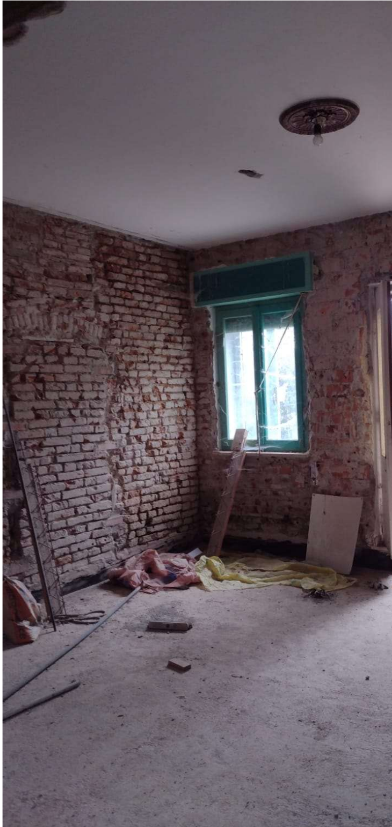
foto 2 – interni abitazione al grezzo p. T
