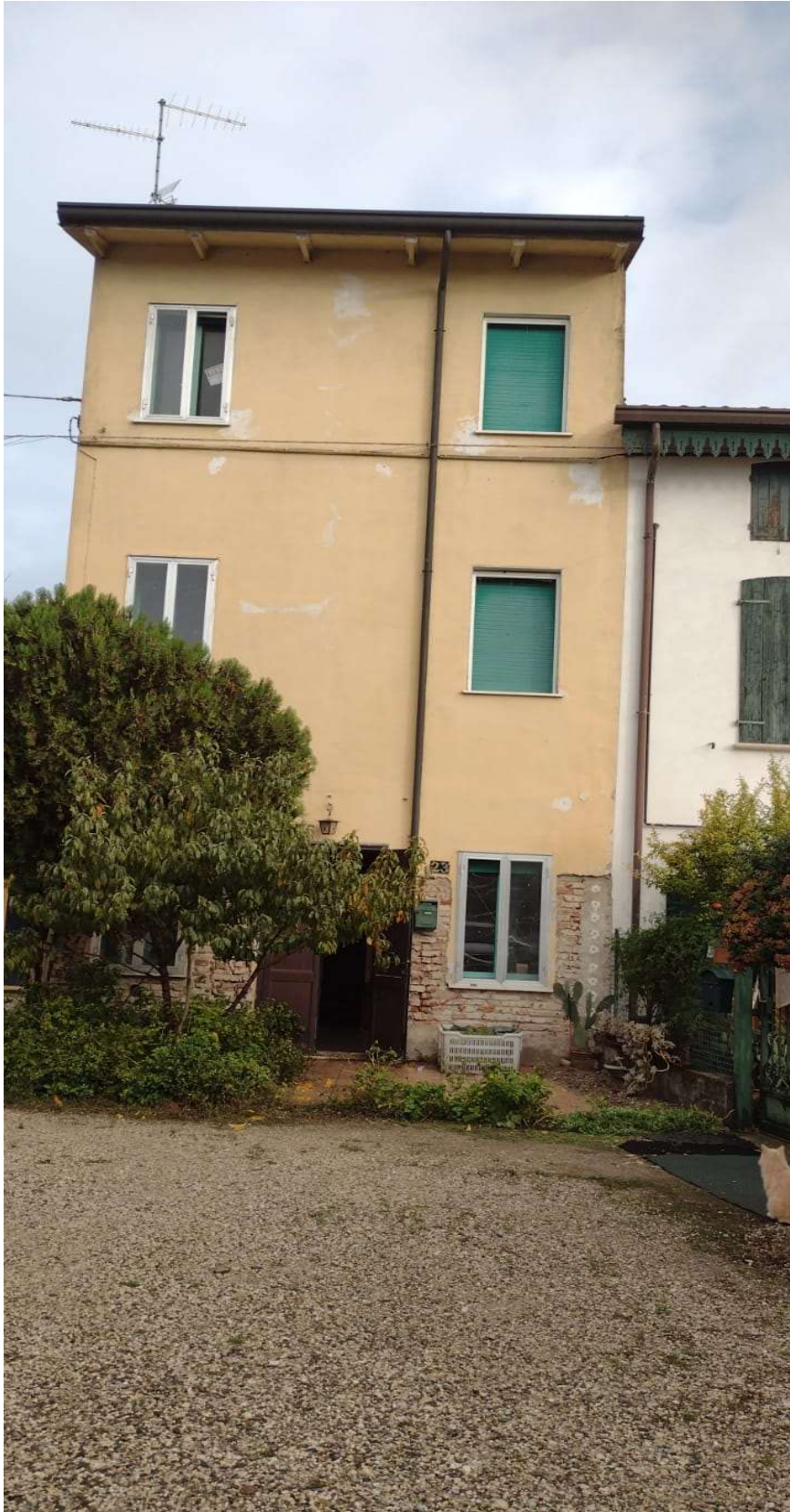
foto 1 – esterni su area comune (part. 437)
