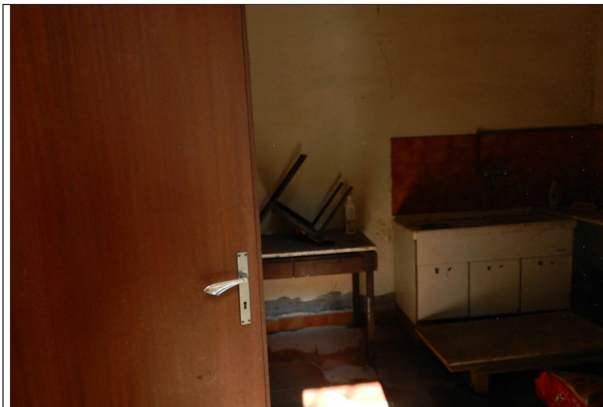
foto n° 7: Vista del vano ripostiglio facente parte dell'immobile n° 1
