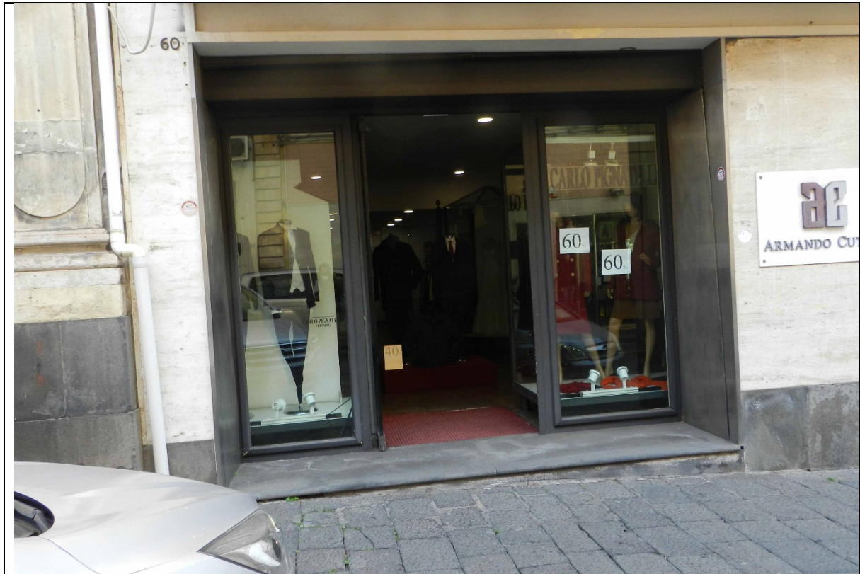
foto n° 9: Vista del negozio in Corso Italia n° 60 comprendente l'immobile n° 2
