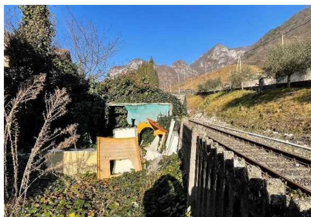
Vista del box garage in lamiera
