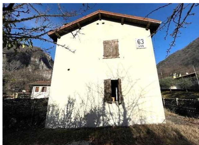
Vista del fabbricato da Sud - est
