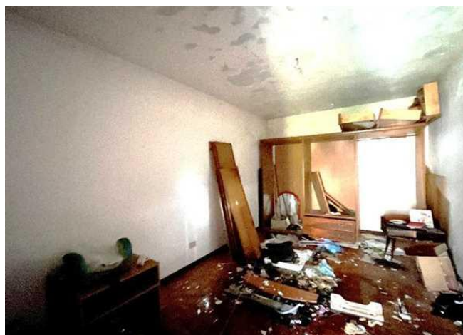
Vista della camera posta a sud
