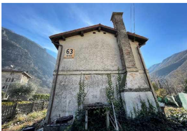
Vista del fabbricato da nord - Ovest
