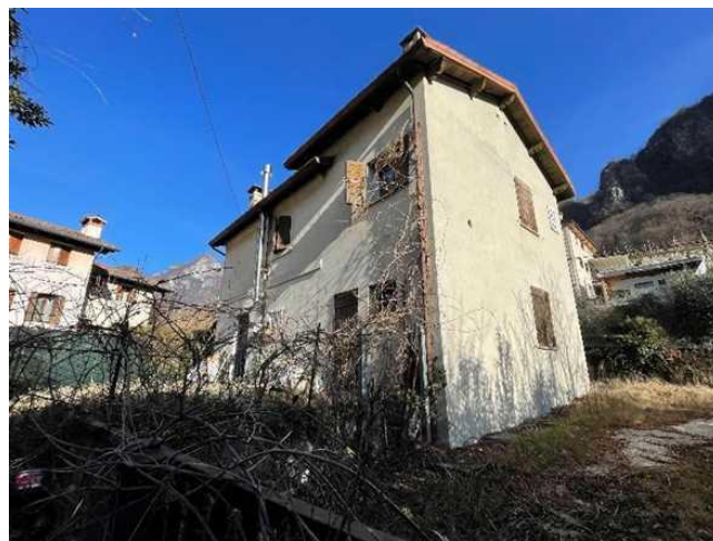
Vista del fabbricato Sud
