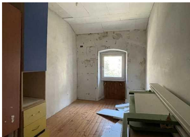
vista della camera posta a nord
