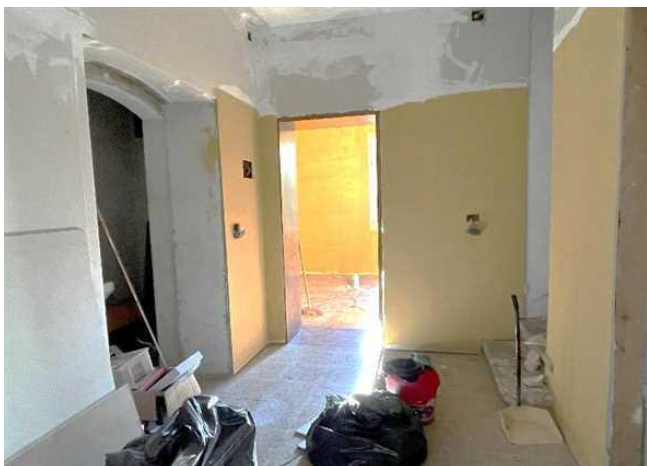
Vista dell'ex ingresso uso disimpegno
