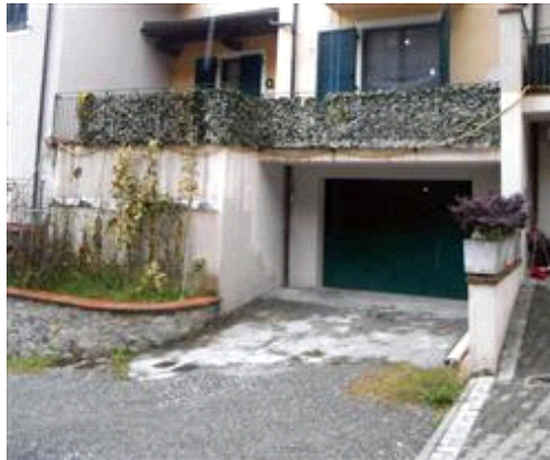
veduta del portone di ingresso all'unità immobiliare 914 sub. 8 oggetto di stima e della resede pertinenziale
