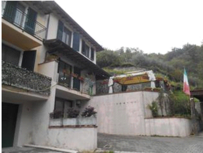
veduta dell'unità immobiliare 914 sub. 9 ripresa dal lato opposto (sud est) rispetto all'ingresso principale
