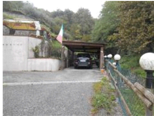
veduta della tettoia che occupa la parte a monte del vialetto 914 sub. 26, per la quale non sono stati reperiti titoli edilizi
