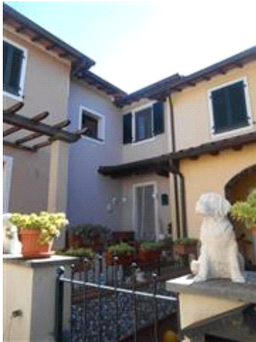
al centro in secondo piano, dove il fabbricato fa angolo, si trova il portone principale di accesso all'unità immobiliare 914 sub. 9
