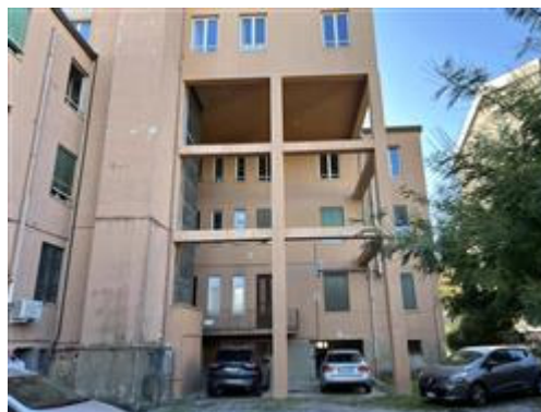
Prospetto secondario con vista dell'area esterna di pertinenza
