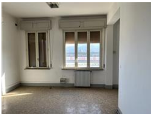
Locali piano terzo
