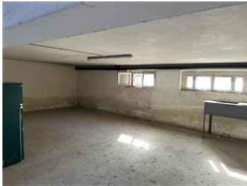
Locali piano seminterrato
