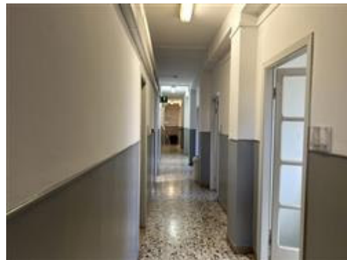
Locali piano secondo
