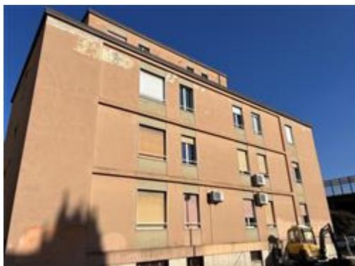
Prospetto su Via Achille Grandi
