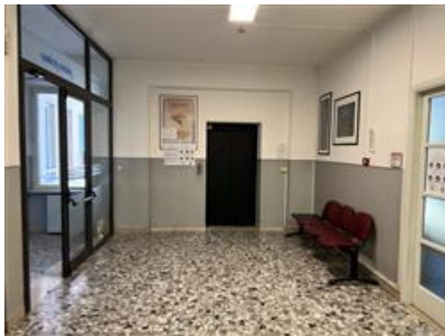
Locali piano primo
