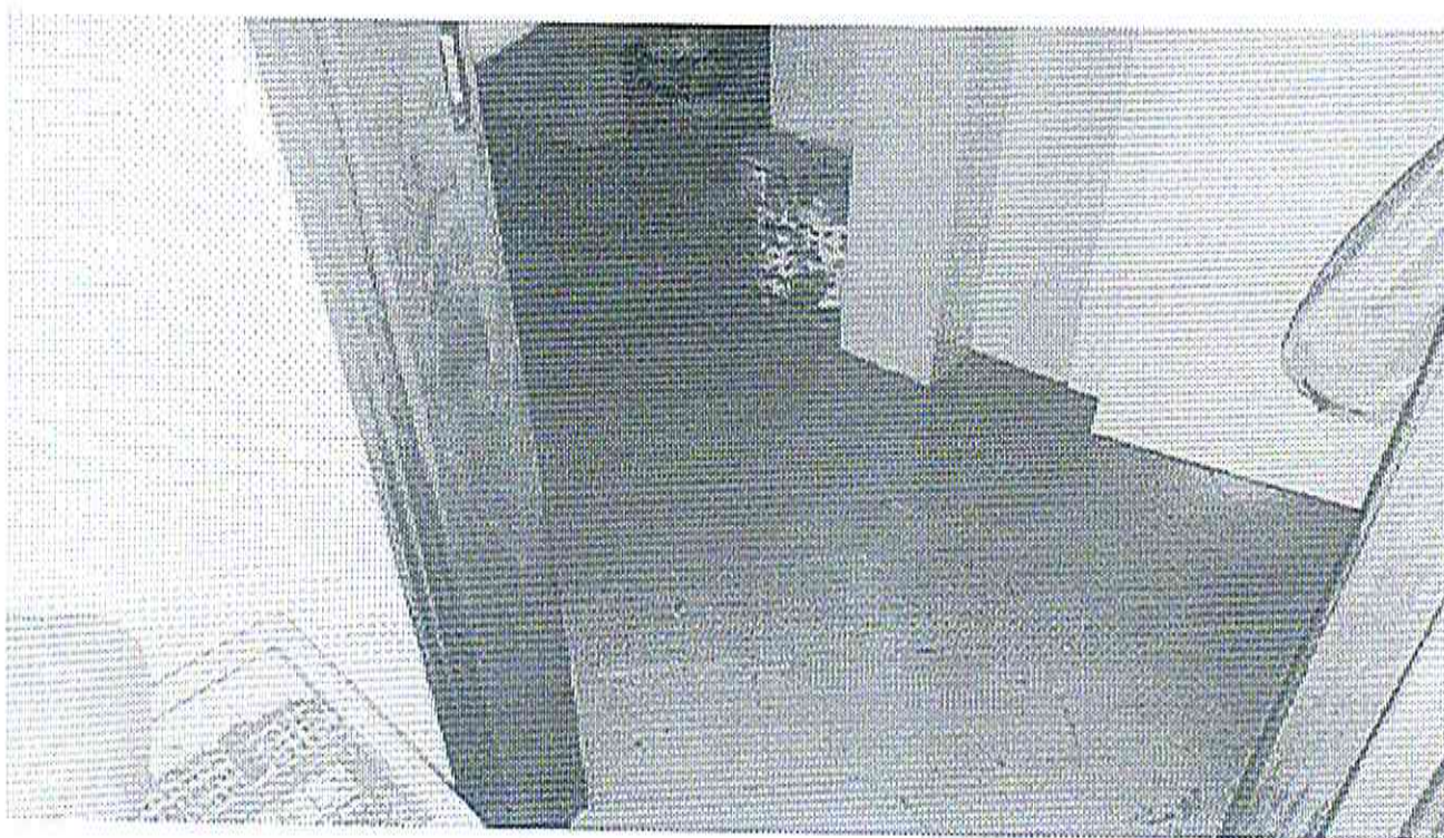
Particolare disimpegno p.t. edificio pertinenziale
