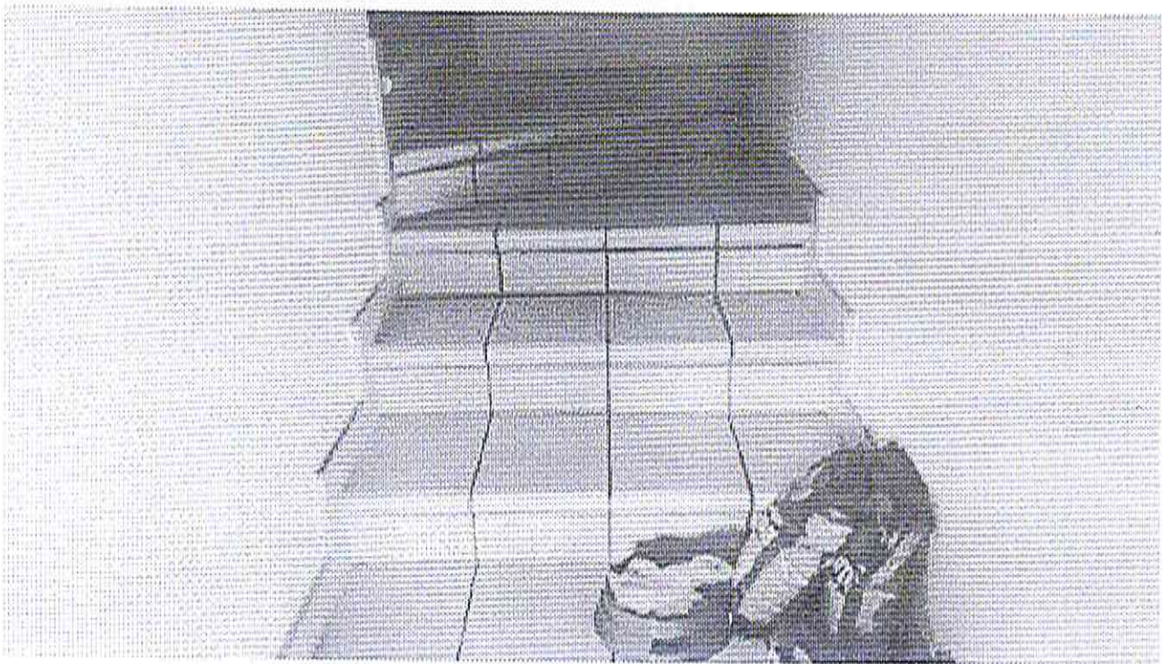
Particolare scala di accesso al piano primo edificio pertinenziale
