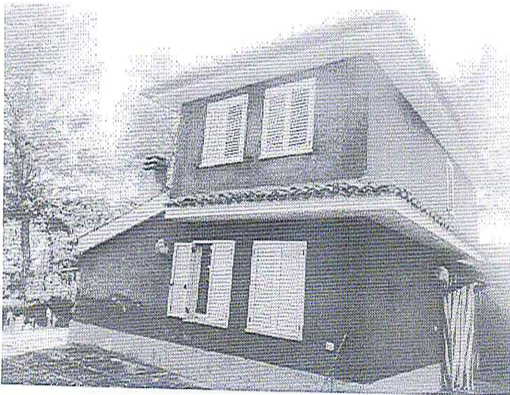
Particolare prospetto laterale edificio pertinenziale.
