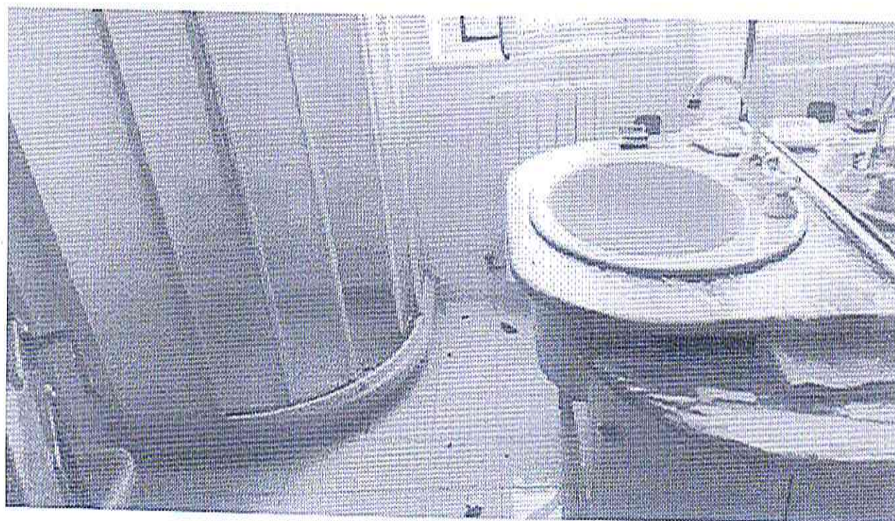
Particolare bagno piano terra edificio pertinenziale
