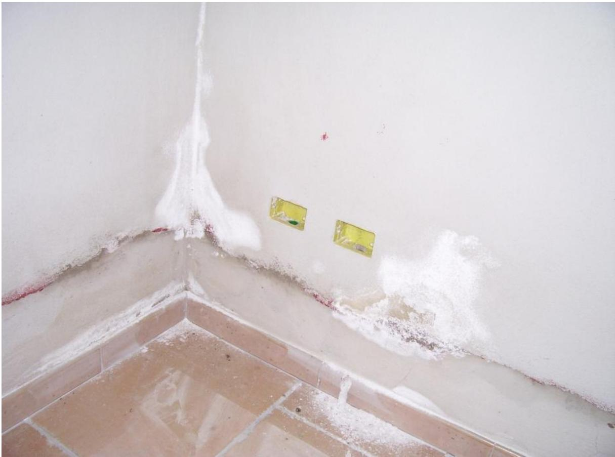
Foto 36. Infiltrazioni di umidità nei seminterrati
