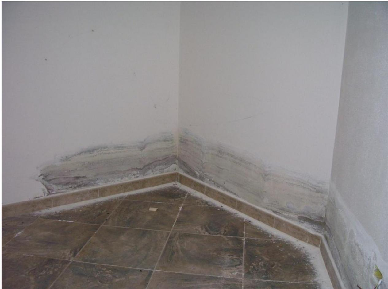
Foto 37. Infiltrazioni di umidità nei seminterrati
