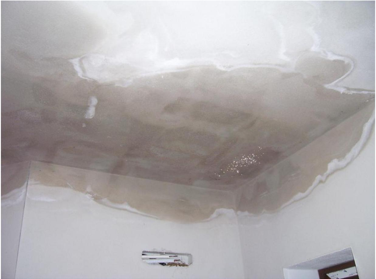
Foto 33. Infiltrazioni di umidità nei solai
