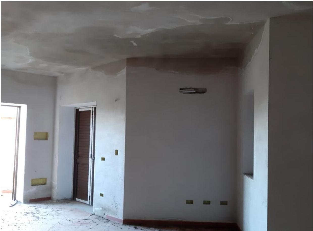
Foto 34. Infiltrazioni di umidità nei solai
