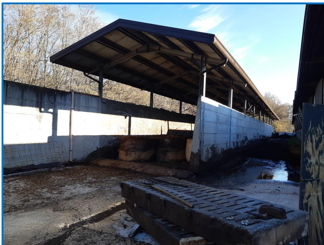
n° 36 – Mn 1006 – Fabbricato n. 6 – concimaia – esterno ovest
