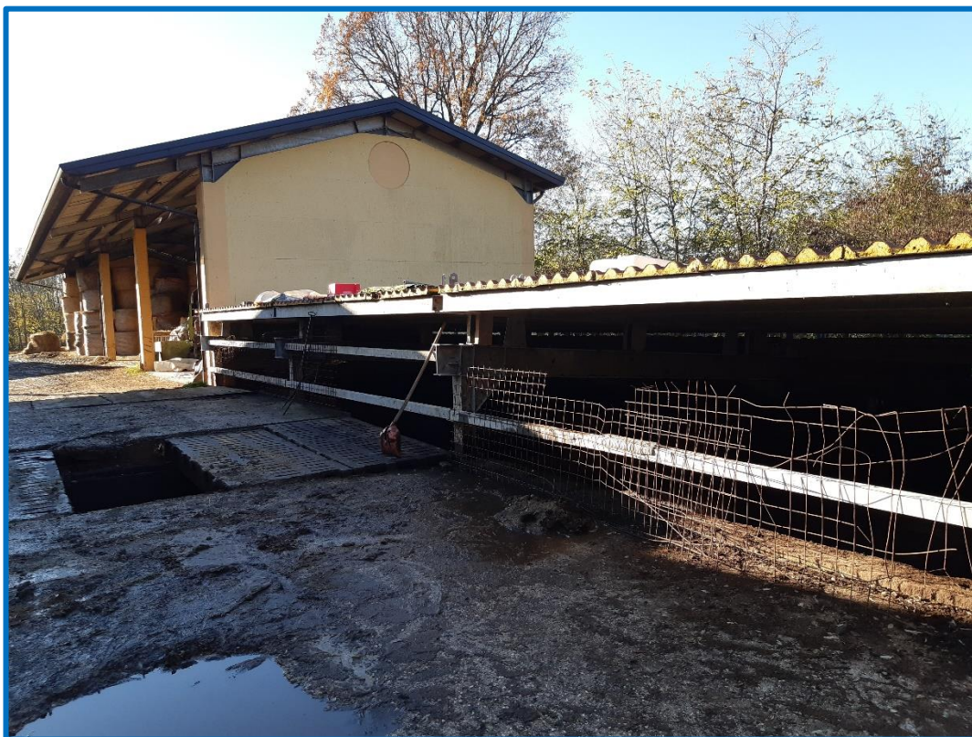
n° 35 – Mn 1006 – Fabbricato n. 5 – fienile – esterno nord e vasca liquami (7)
