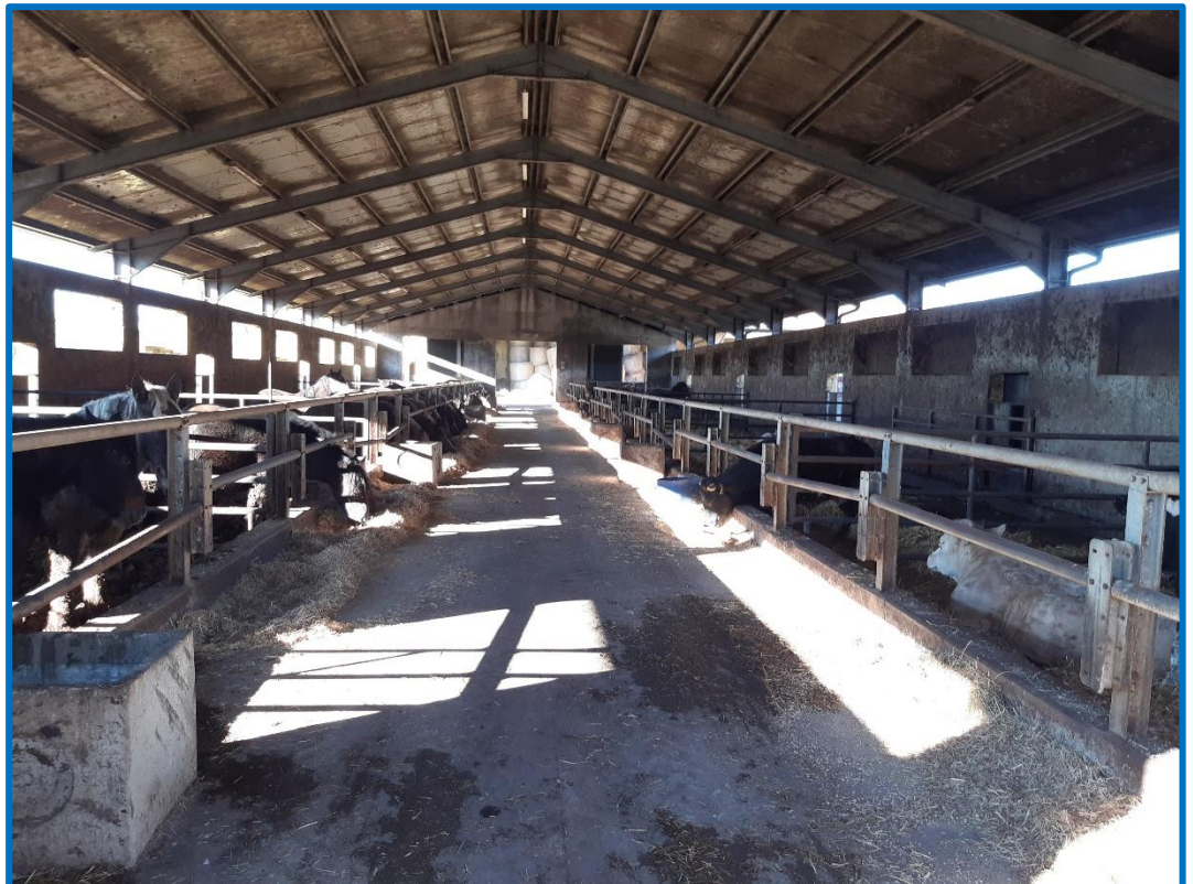
n° 32 – Mn 1006 – Fabbricato n. 4 – stalla – interno
