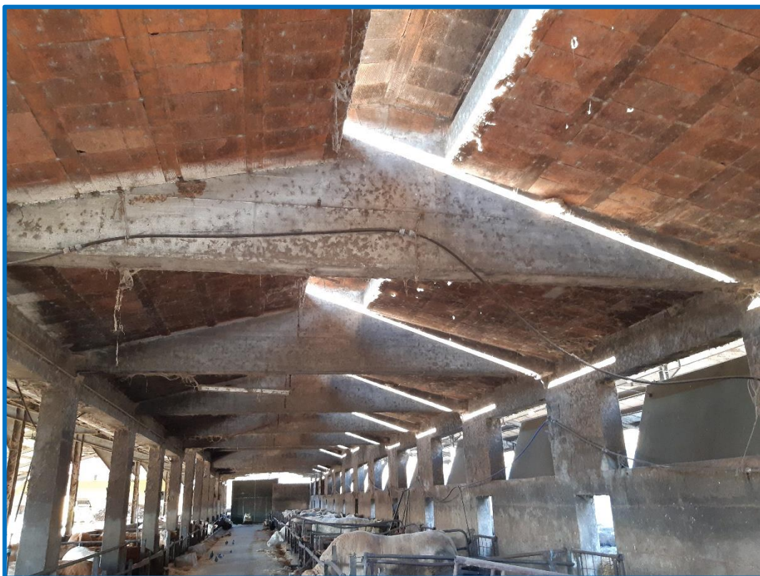
n° 29 – Mn 1006 – Fabbricato n. 3 – stalla – particolare copertura zona seconda edificazione
