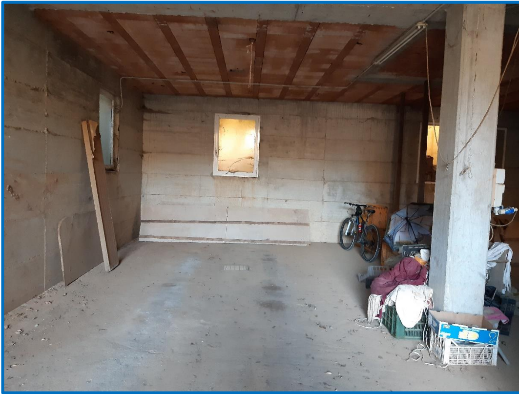
n° 5 Particella Mn 938 – interno piano interrato
