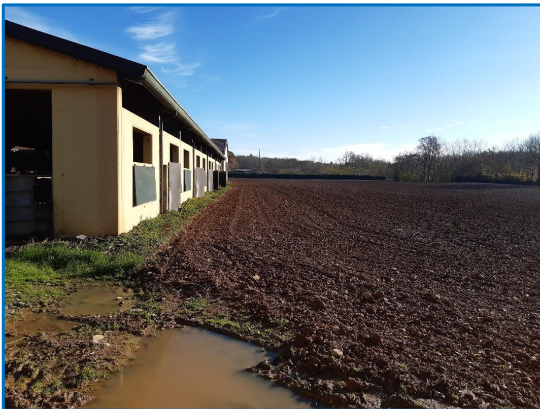
n° 37 – Mn 1006 – Fabbricato n. 4 – esterno sud e particella n. 1007 (terreno agricolo)t
