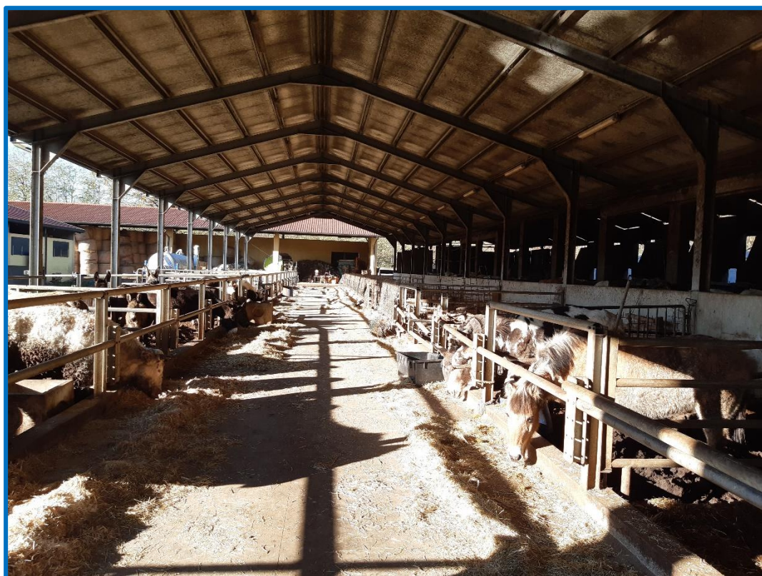
n° 30 – Mn 1006 – Fabbricato n. 3 – stalla – interno zona seconda edificazione
