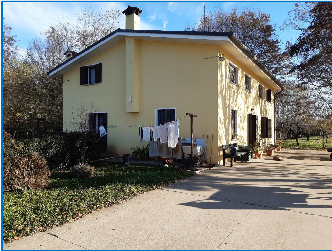
n° 3 - Particella Mn 938 – esterno fabbricato
