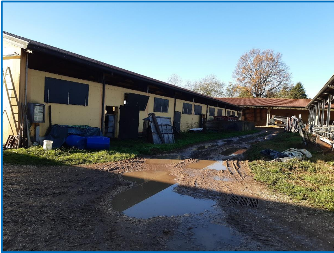
n° 31 – Mn 1006 – Fabbricato n. 4 – stalla – esterno nord
