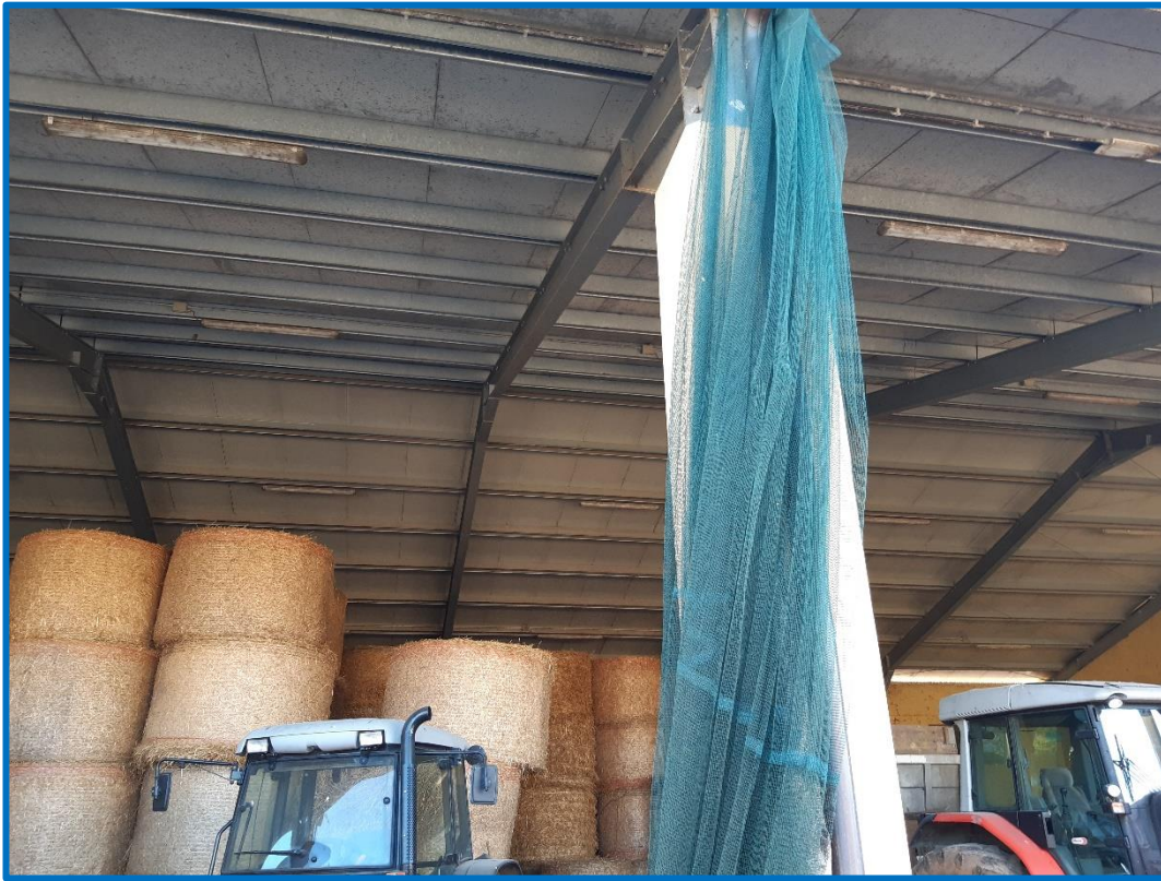
n° 25 – Mn 1006 – Fabbricato n. 2 – particolare copertura ricovero attrezzi
