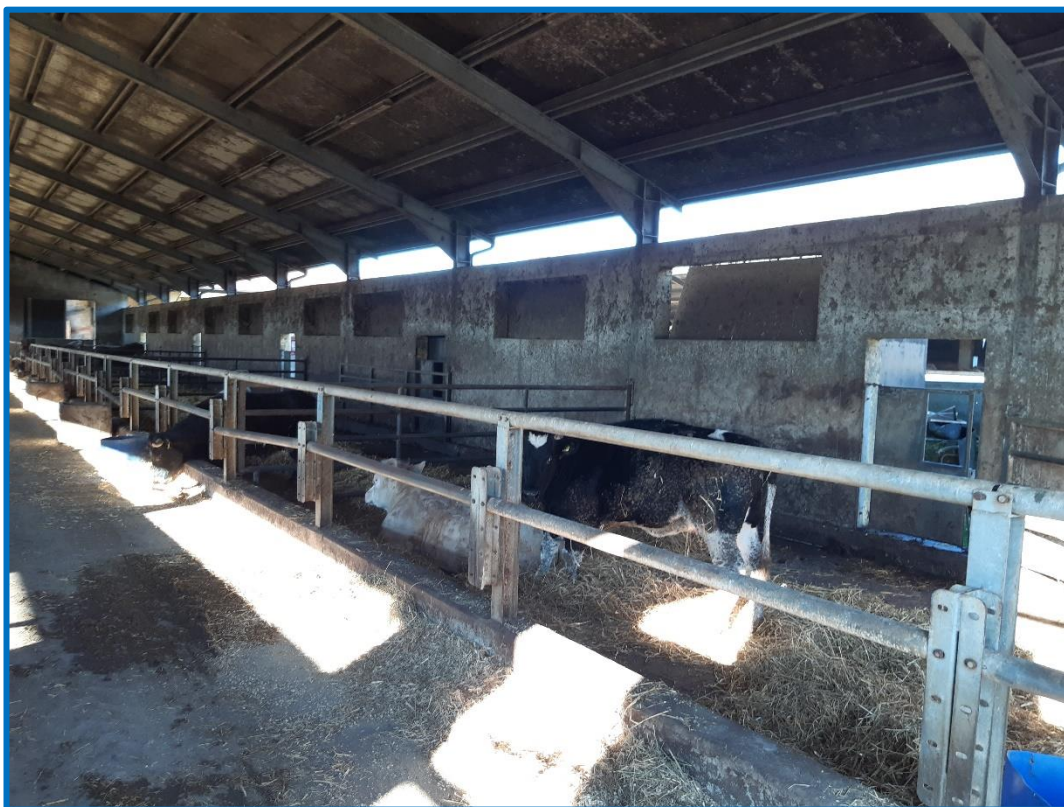
n° 33 – Mn 1006 – Fabbricato n. 4 – stalla – interno
