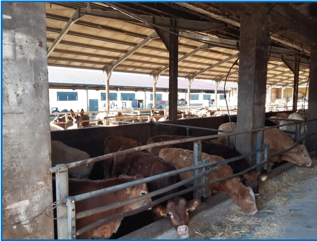
n° 27 – Mn 1006 – Fabbricato n. 3 – stalla – interno zona prima edificazione
