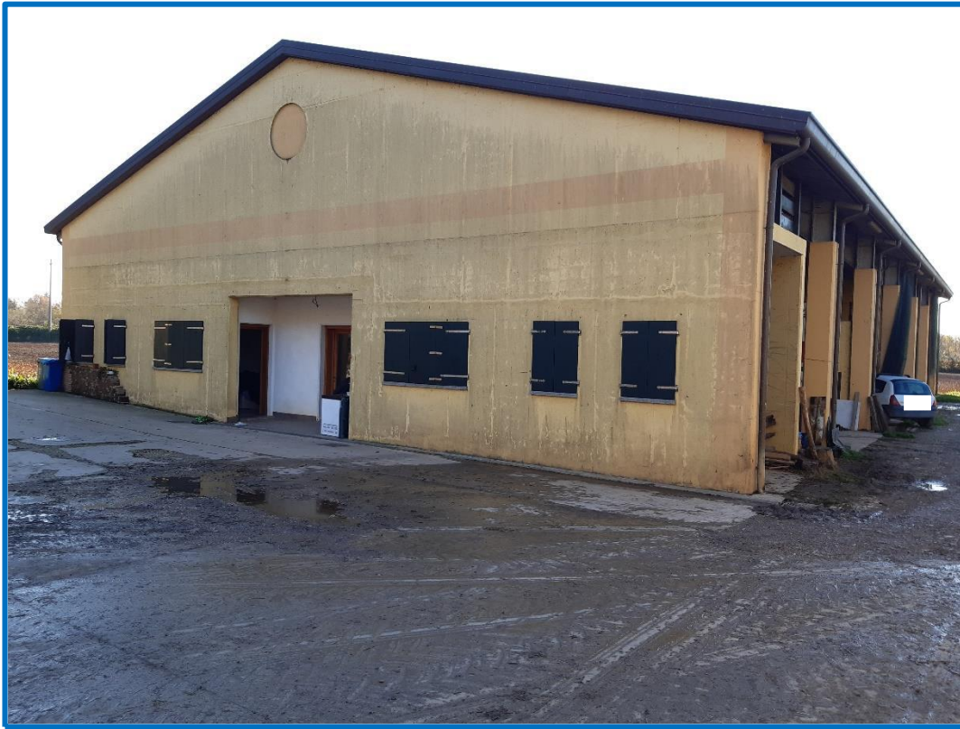
n° 19 – Mn 1006 – Fabbricato n. 2 – esterno nord
