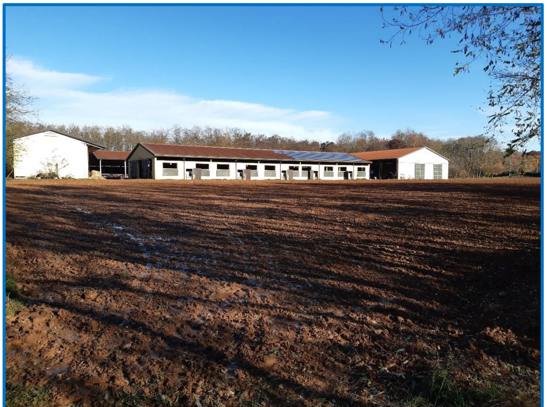
n° 40 – Mn 1007 – Terreno agricolo visto da sud
