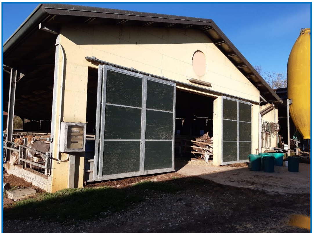
n° 26 – Mn 1006 – Fabbricato n. 3 – stalla - esterno est
