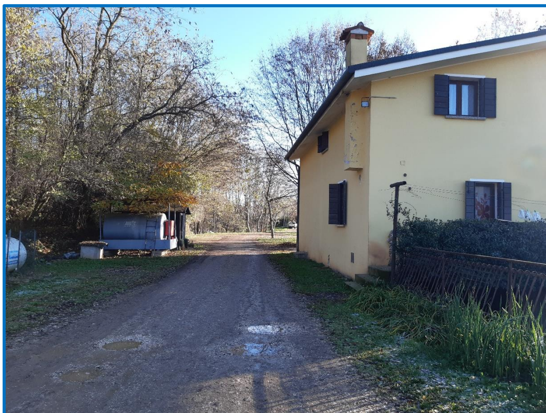
n° 2- Particella Mn 938 – esterno fabbricato
