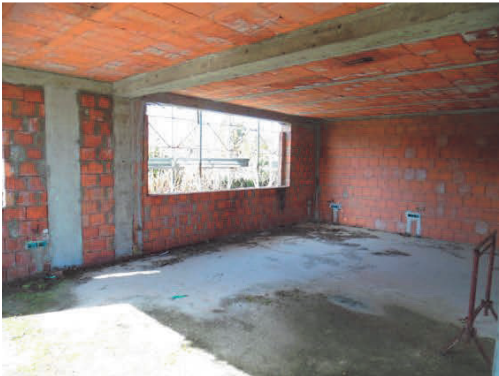
Fotografia E.18 - Vista del piano terreno rialzato
