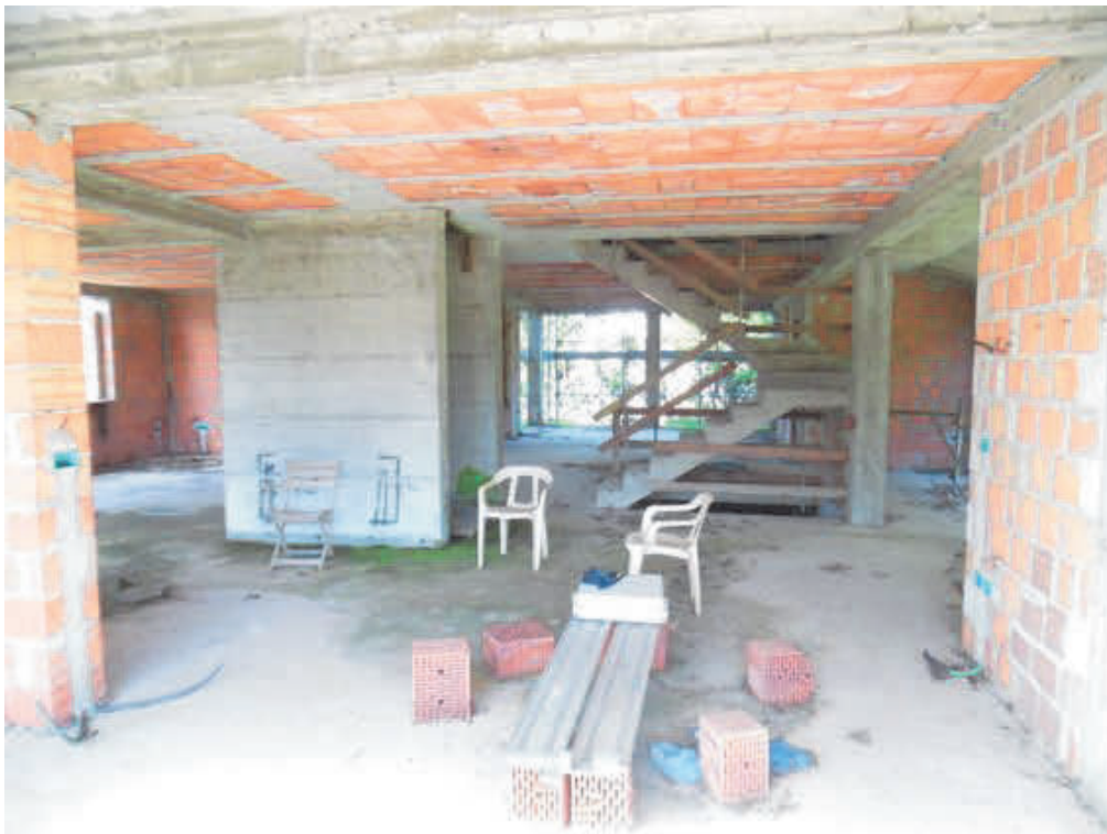
Fotografia E.16 - Vista del piano terreno rialzato
