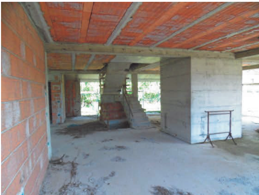
Fotografia E.20 - Vista del piano terreno rialzato (si noti il gruppo scala ed il vano ascensore con struttura in calcestruzzo armato)
