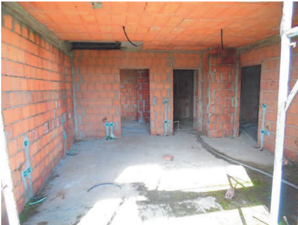
Fotografia E.24 - Vista del piano primo (camera dove è situato il foro di passaggio per l'accesso al piano sottotetto)
