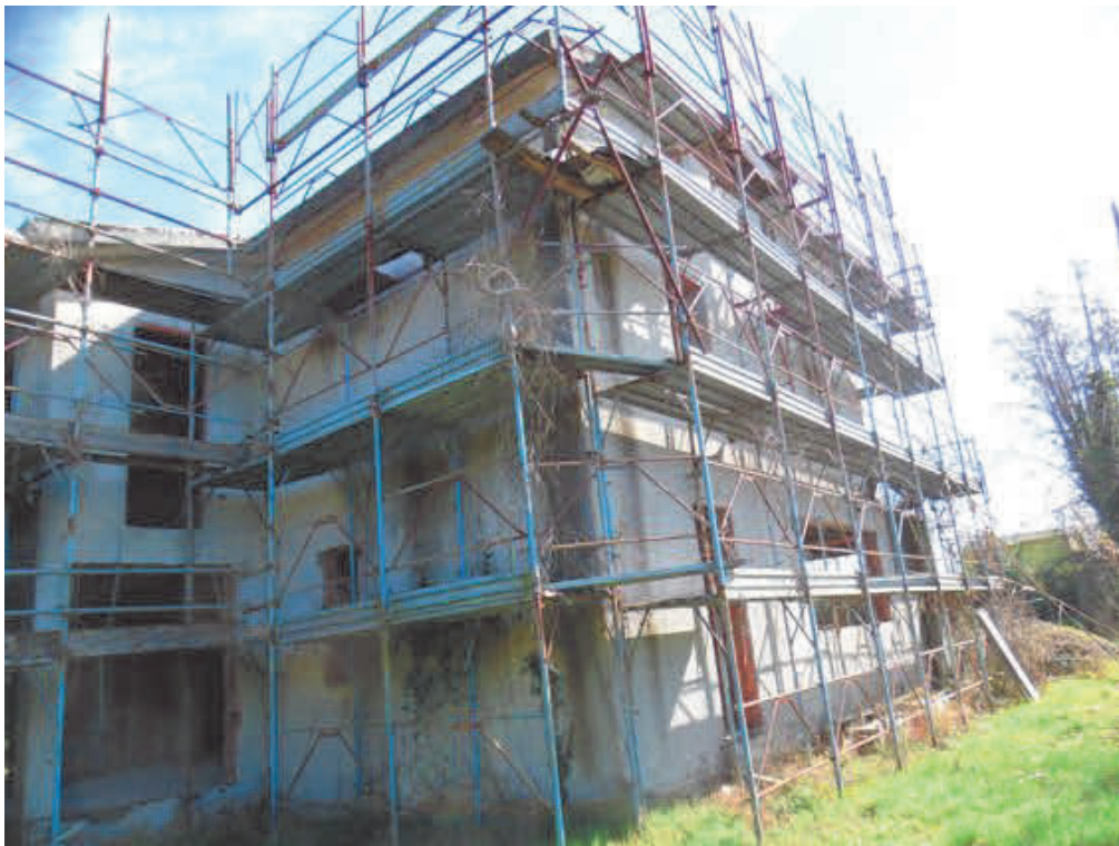
Fotografia E.8 - Vista del fronte laterale destro
