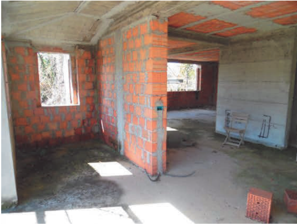
Fotografia E.17 - Vista del piano terreno rialzato
