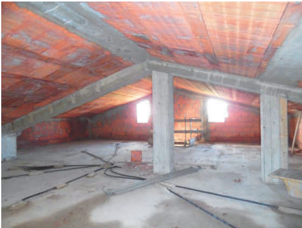
Fotografia E.26 - Vista della soffitta (piano sottotetto)
