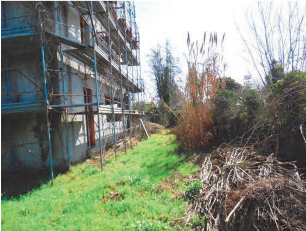
Fotografia E.9 - Vista del fronte tergale e dello spazio intercorrente verso il confine del lotto
