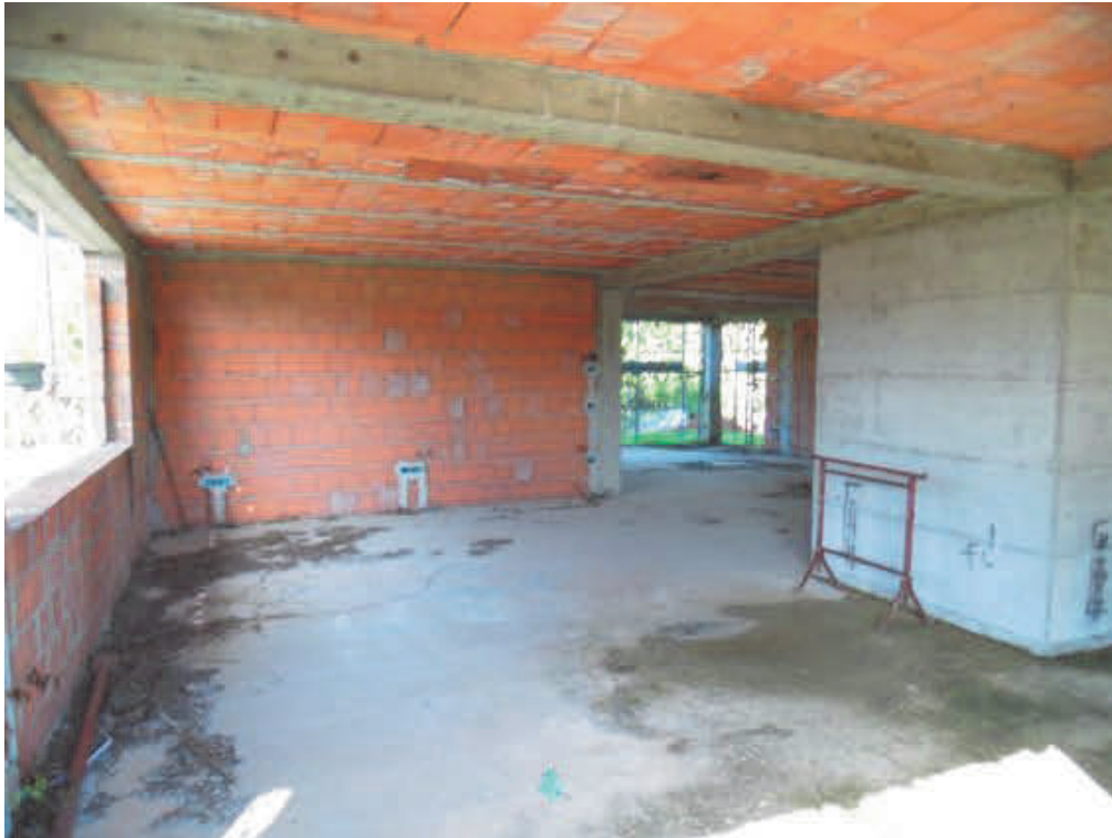
Fotografia E.19 - Vista del piano terreno rialzato
