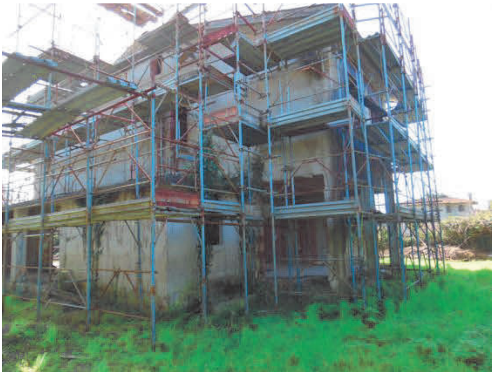
Fotografia E.6 - Vista del fronte laterale sinistro e tergale
