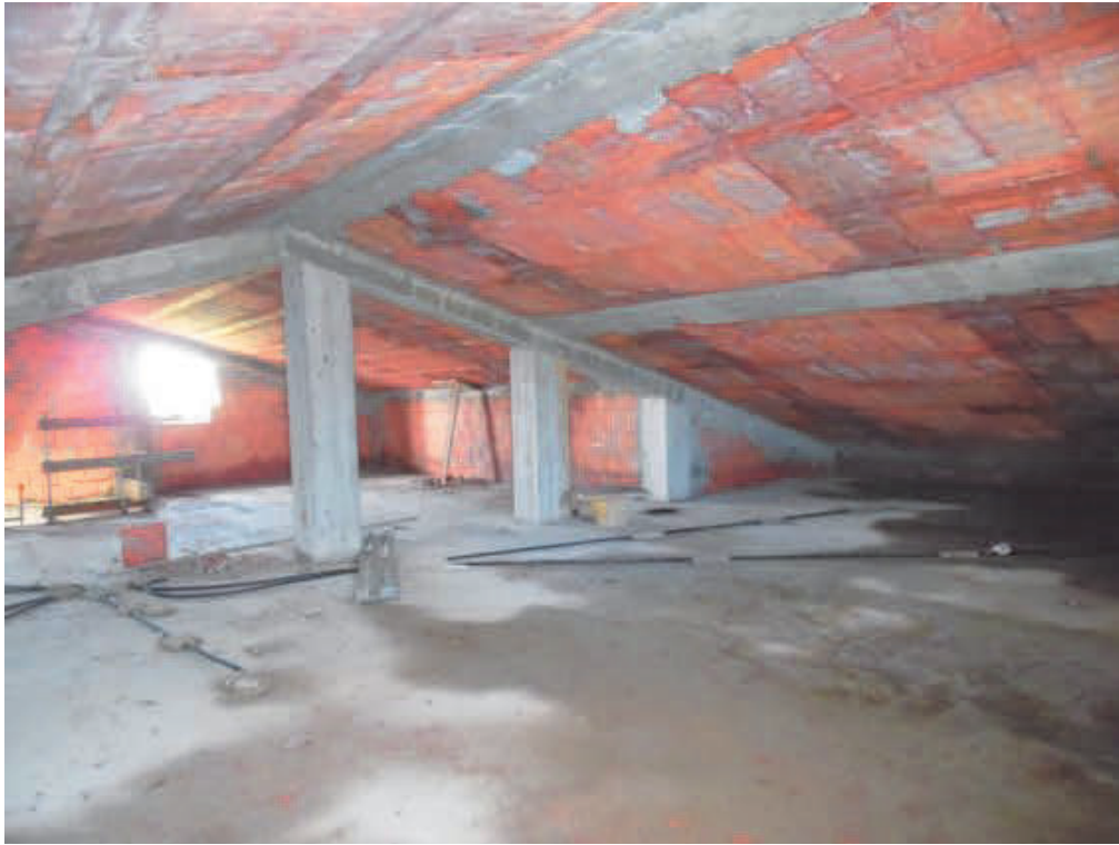
Fotografia E.29 - Vista della soffitta (piano sottotetto)
