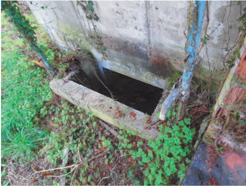
Fotografia E.11 - Vista di una presa di luce e aria del piano seminterrato
