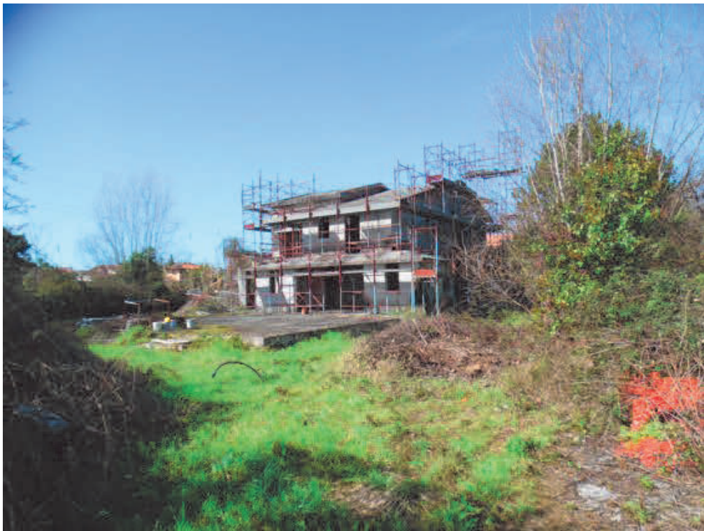
Fotografia E.4 - Vista del fabbricato dal punto di ingresso nel lotto
