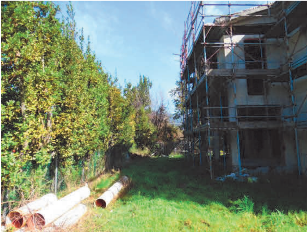
Fotografia E.7 - Vista del fronte laterale sinistro verso il punto di accesso al lotto
