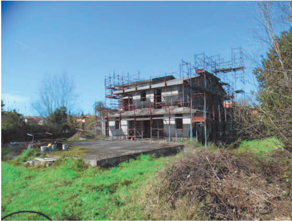
Fotografia E.5 - Vista del fronte principale con la copertura del piano seminterrato
