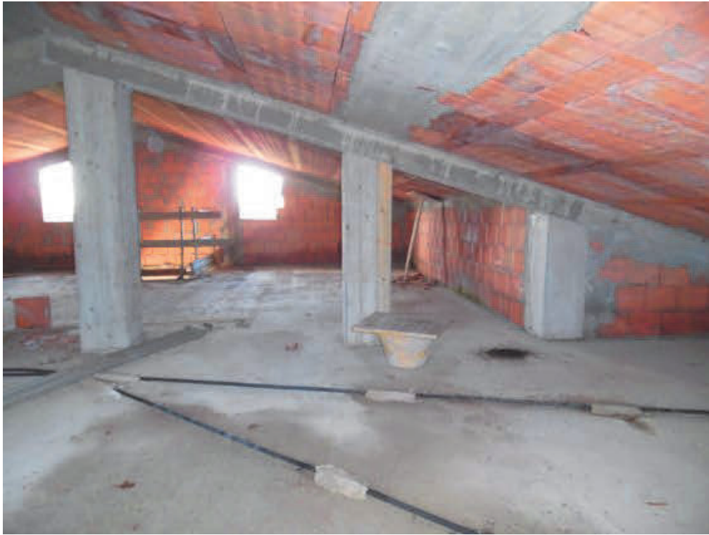
Fotografia E.27 - Vista della soffitta (piano sottotetto)
