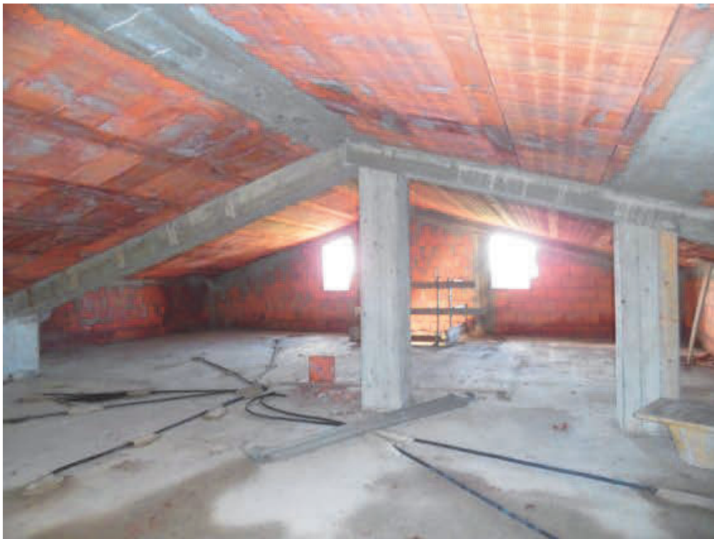
Fotografia E.28 - Vista della soffitta (piano sottotetto)
