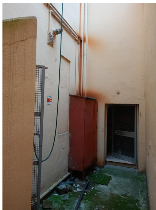
Vista porta di accesso dal vano scale
