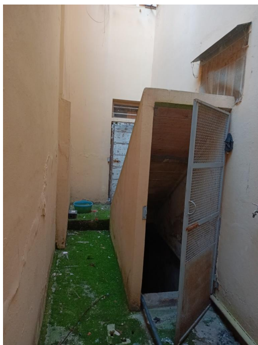
Cortile interno comune e accesso interrato
