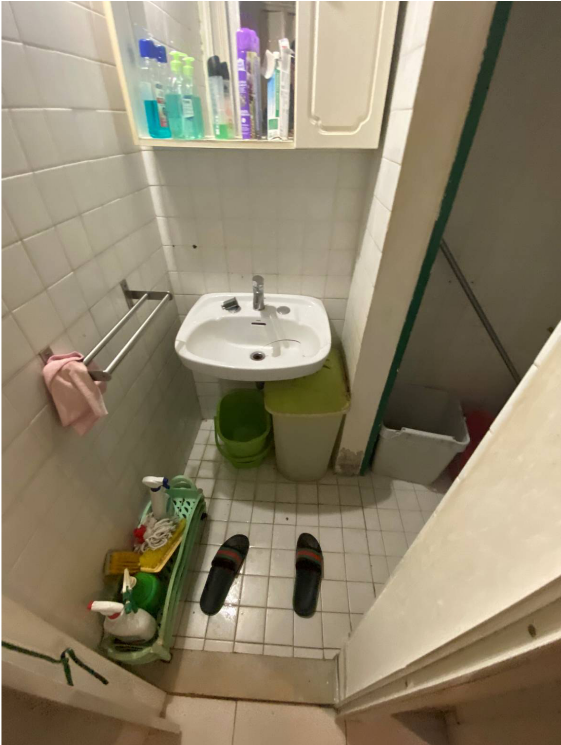
Fot. 8 – Vista dell'antibagno con il lavabo.
