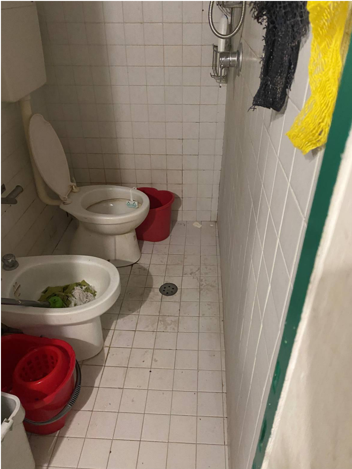
Fot .9 – Vista del servizio igienico.
