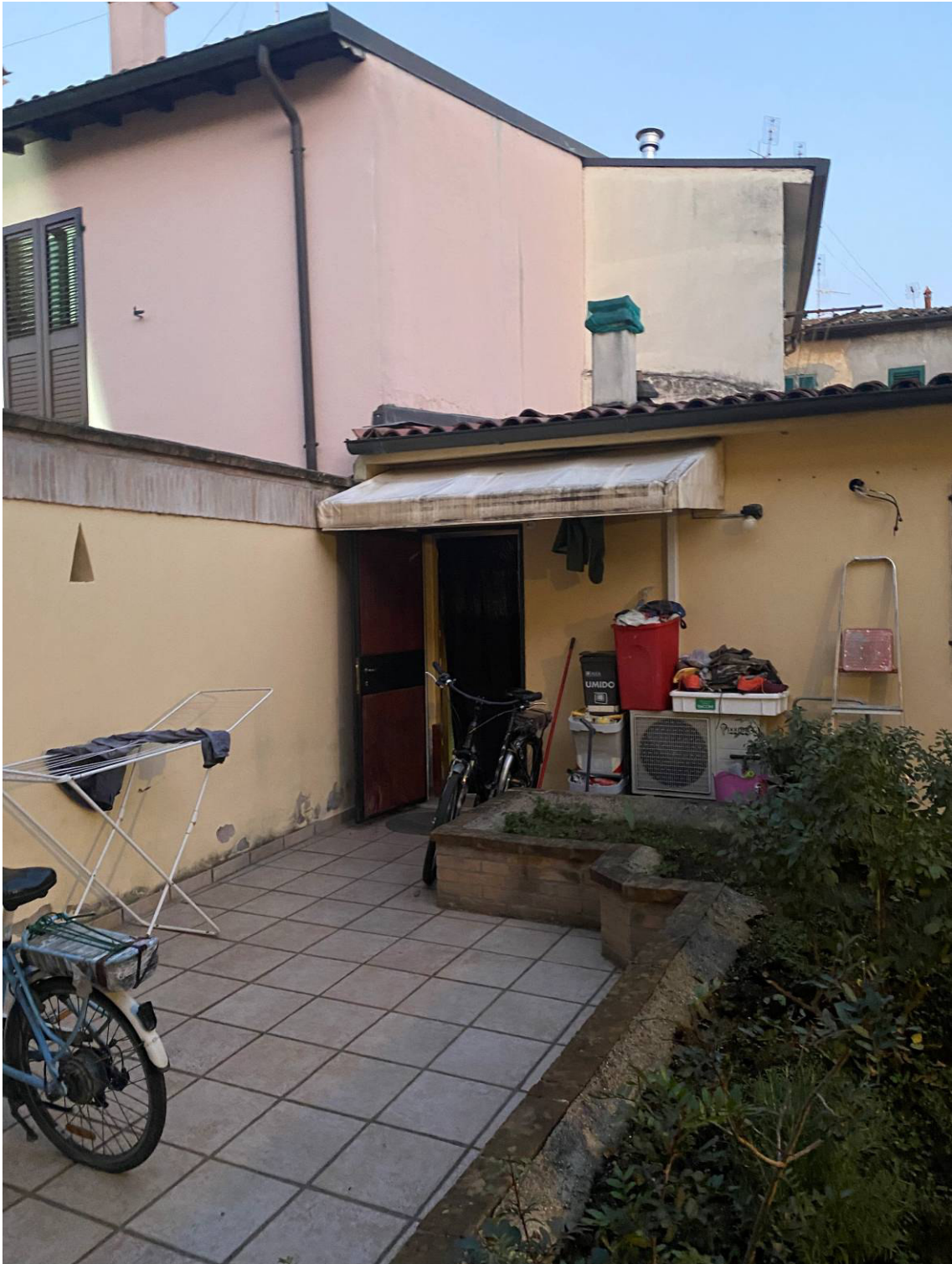
Fot. 3 - Vista della corte comune da cui si accede all'unità immobiliare.
