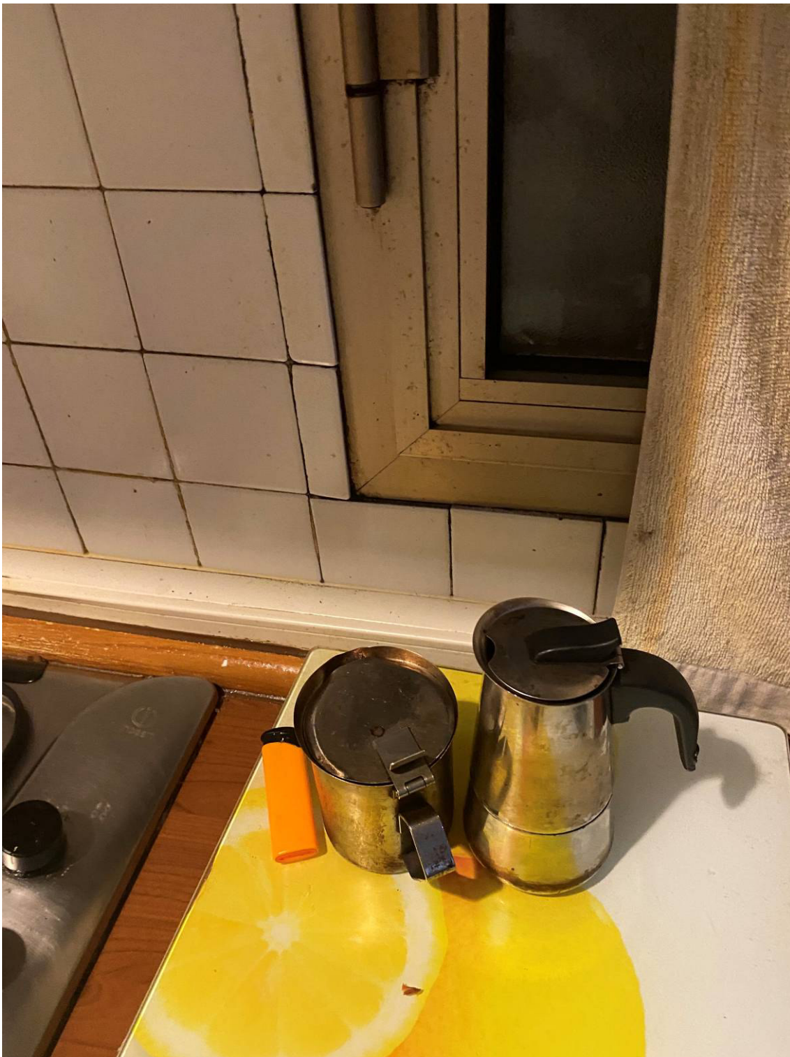
Fot. 13 – Particolare della finestra della zona cottura, con telaio in alluminio “Anticorodal”.
