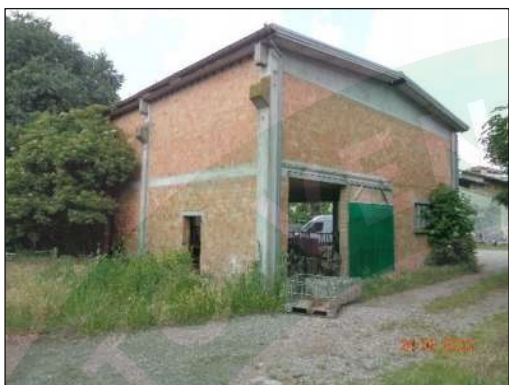
Foto 20 – Prospetto sud- ovest
