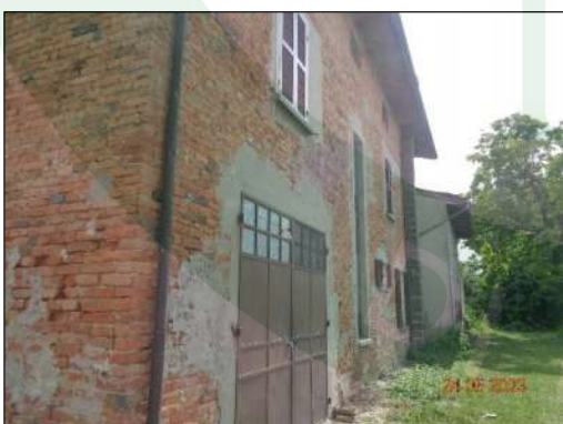
Foto 16 – Autorimessa – Accesso carrabile
