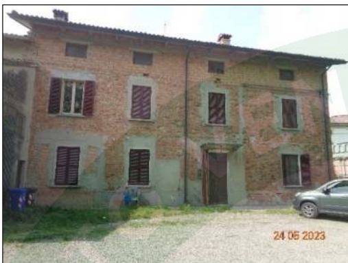
Foto 2 – Prospetto sud – porzione abitativa
