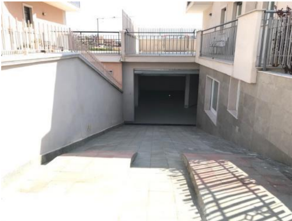
Accesso carraio al garage seminterrato
