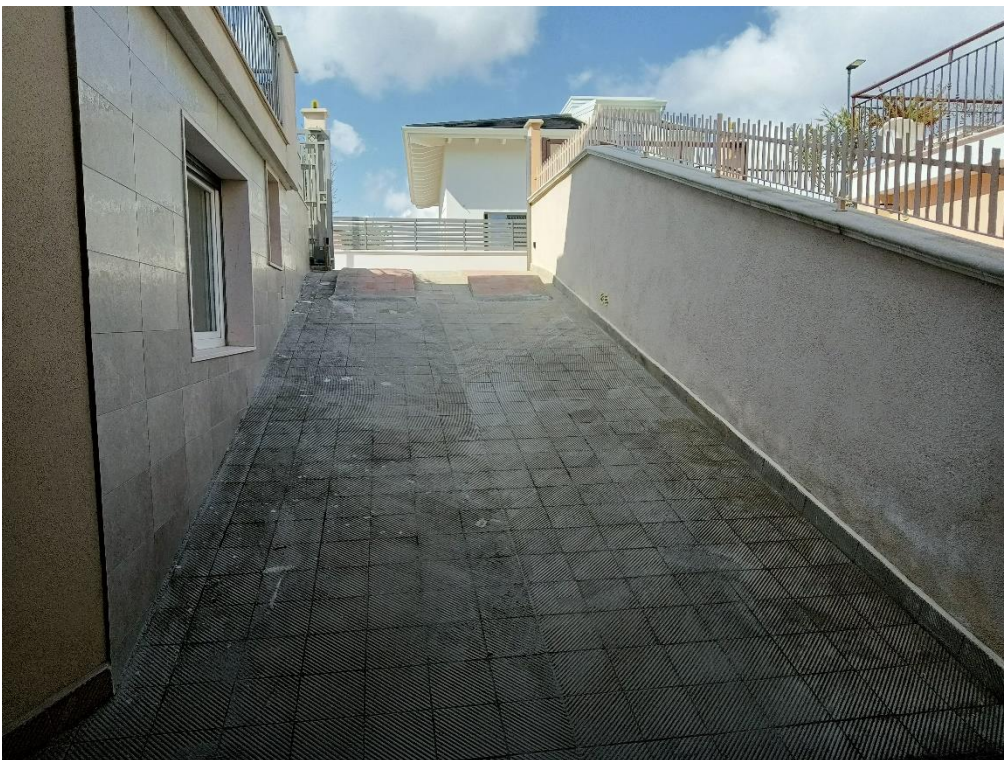
Particolare della rampa
