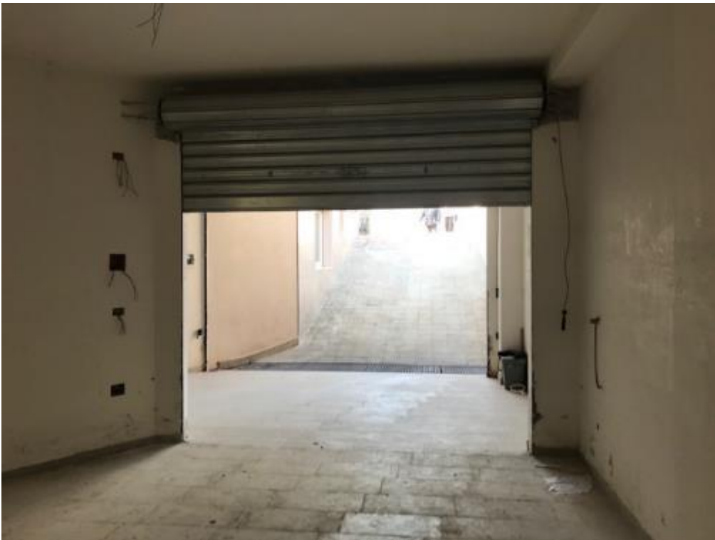
Particolari dell'interno del box auto
