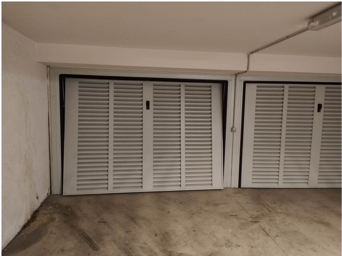
FOTO 14 Auto rimessa piano interrato
