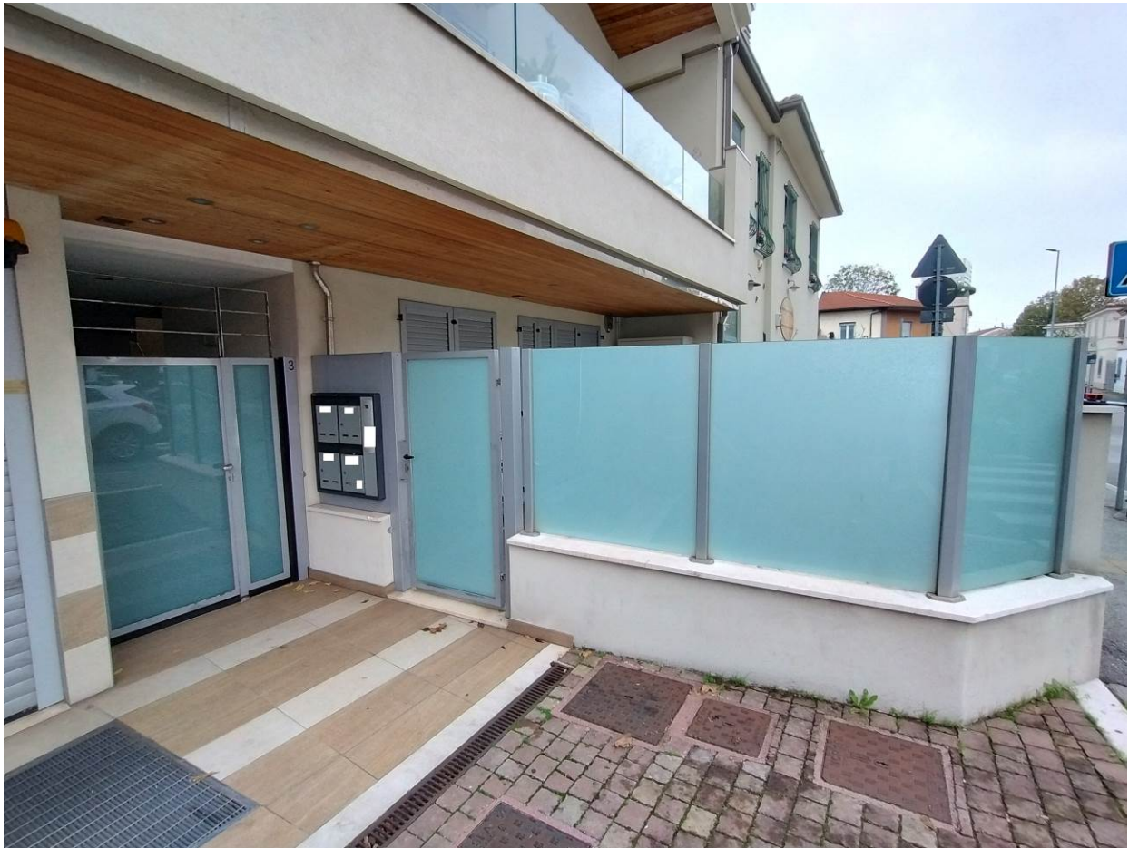
FOTO 3 Vista ingresso condominiale ed accesso a corte esclusiva
