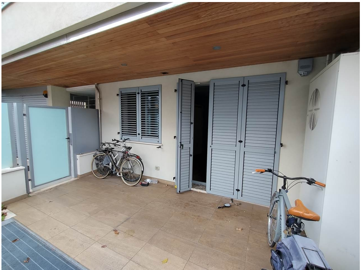
FOTO 12 Corte esclusiva lato via della Fiera
