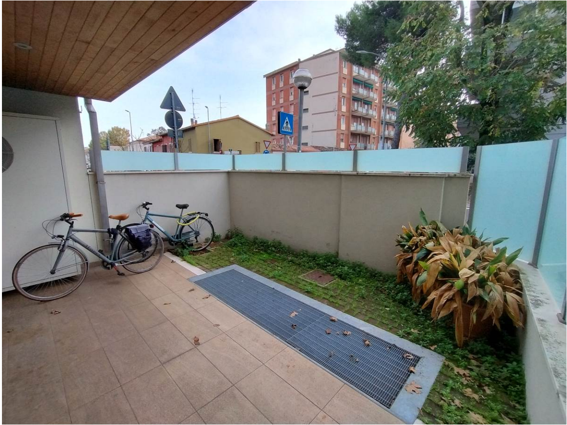
FOTO 13 Corte esclusiva lato via della Fiera
