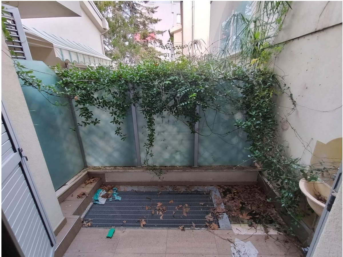
FOTO 11 Corte esclusiva lato retro
