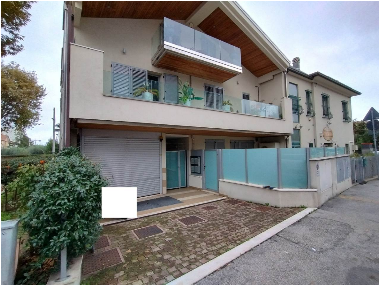
FOTO 1 Vista fabbricato da via della Fiera
