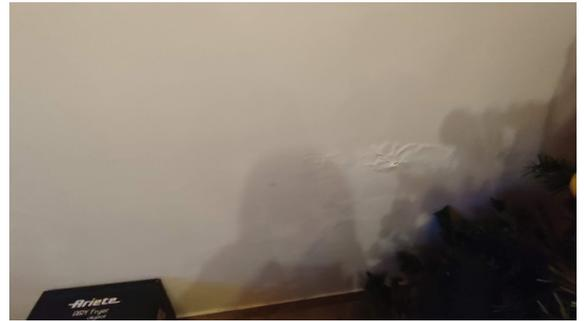
Fig. 9 presenza di umidità da risalita soprattutto nella parete a sud poiché prossima e prospiciente ad altro edificio
