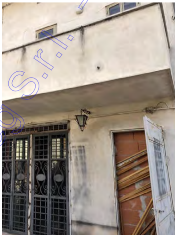
Fotografia A.13 - Particolare porta murata
