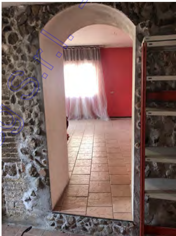
Fotografia A.19 - Particolare apertura varco PT
