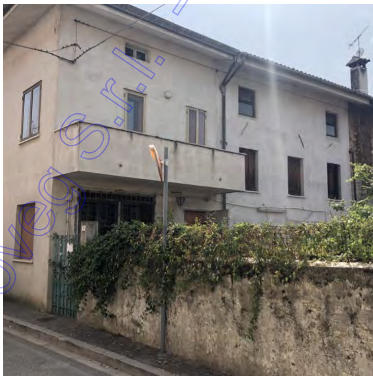
Fotografia A.8 - Prospetto Ovest
