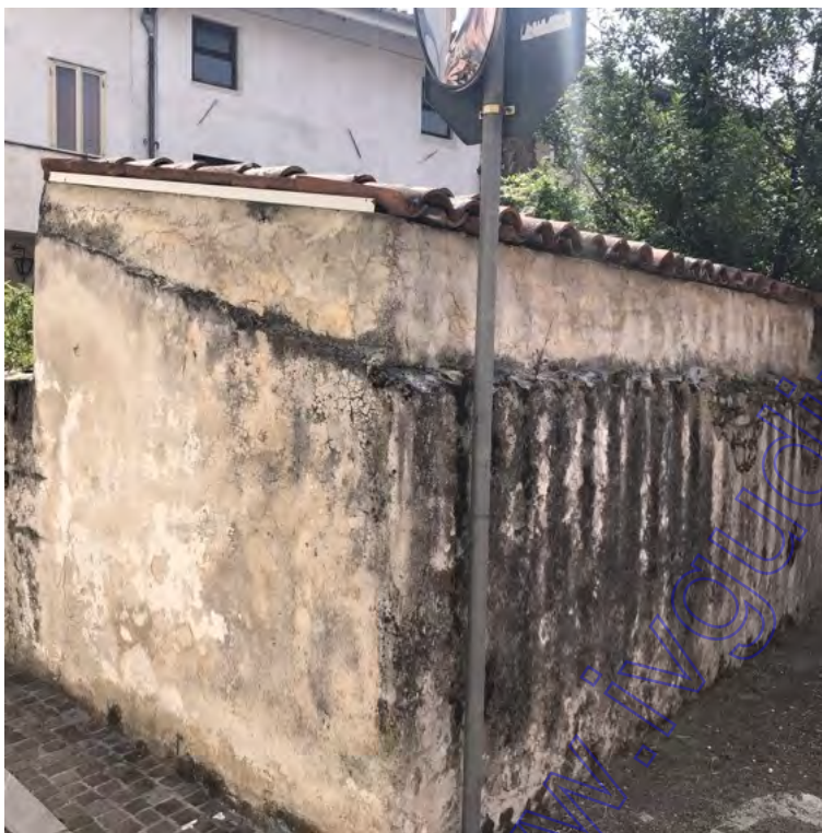
Fotografia A.11 - Ripostiglio esterno, veduta dalla strada
