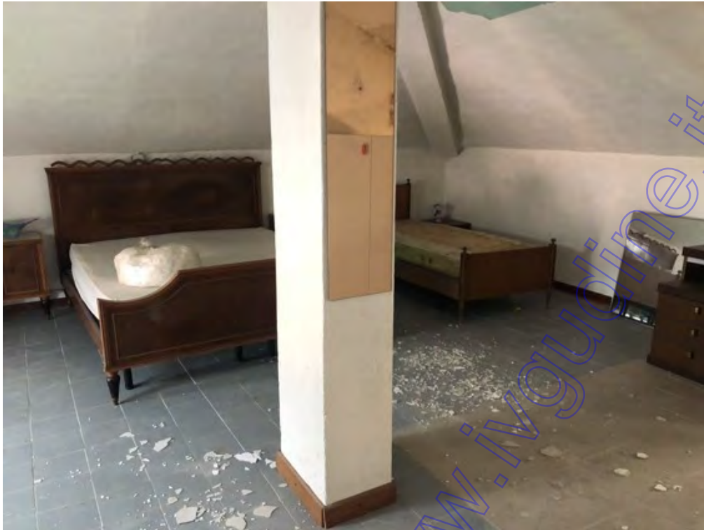
Fotografia A.30 - Particolare soffitta - seconda stanza
