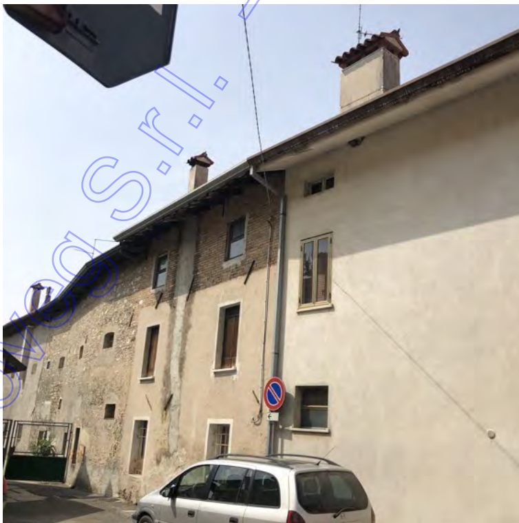
Fotografia A.4 - Prospetto est
