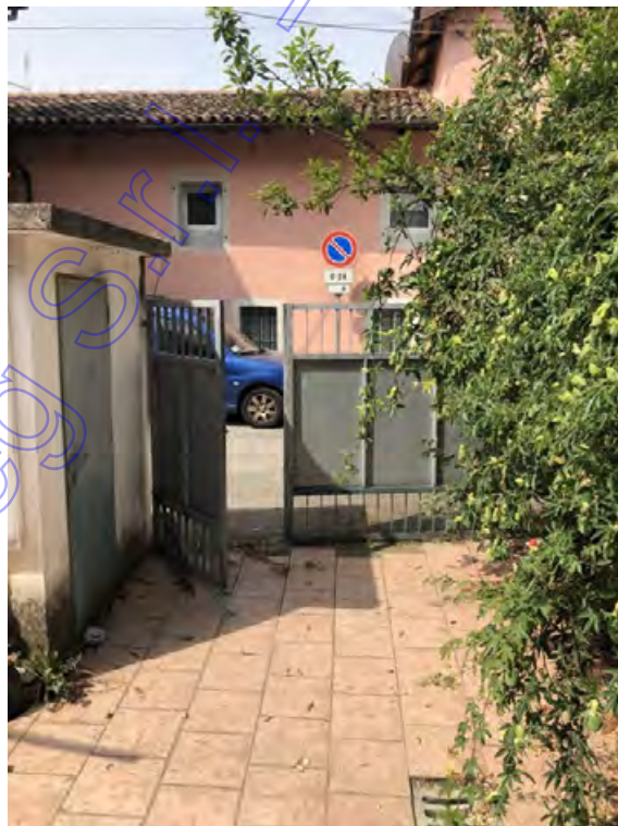
Fotografia A.10 - Ingresso carraio Ovest e ripostiglio
