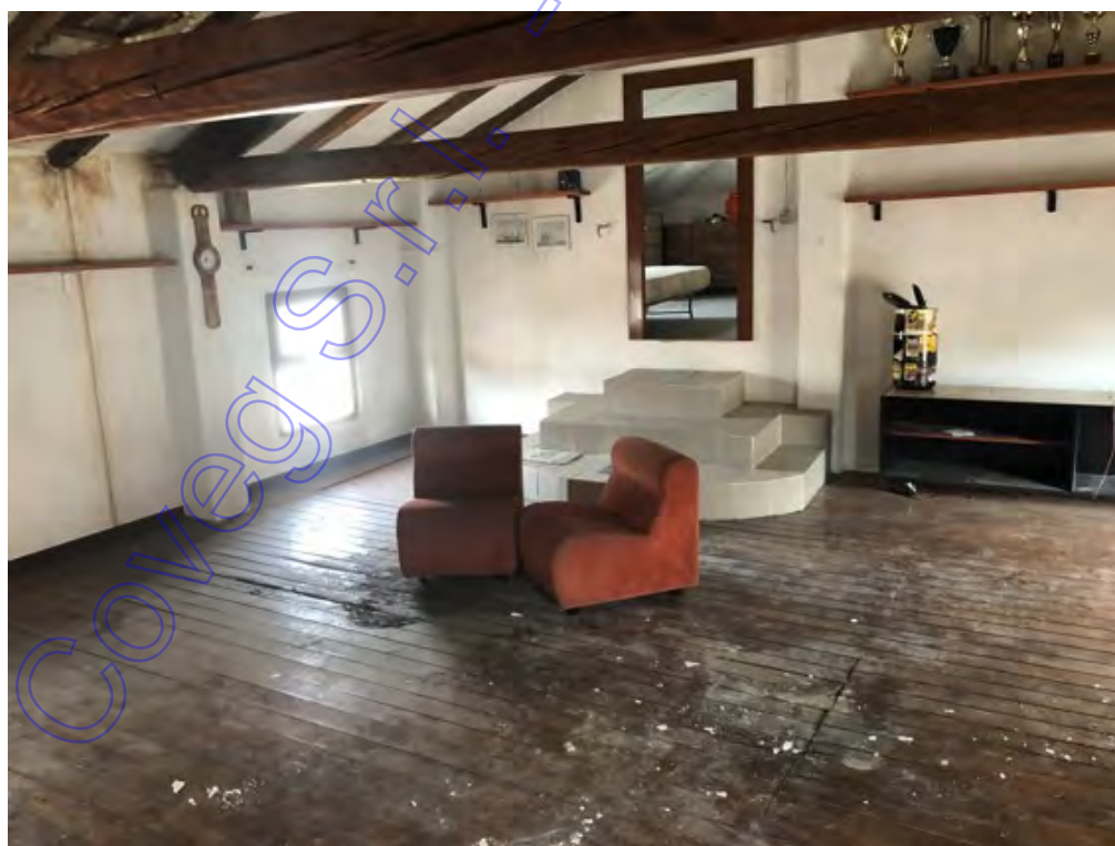
Fotografia A.29 - Particolare soffitta - prima stanza
