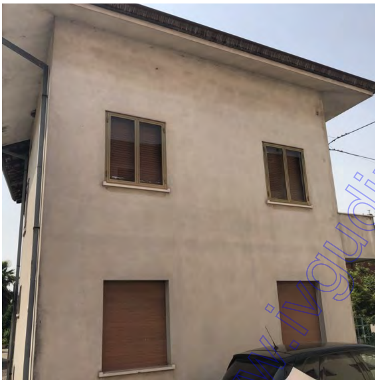
Fotografia A.5 - Prospetto Nord
