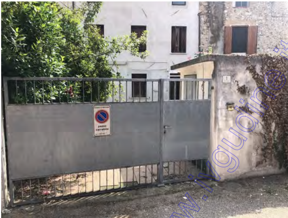
Fotografia A.9 - Ingresso carraio Ovest
