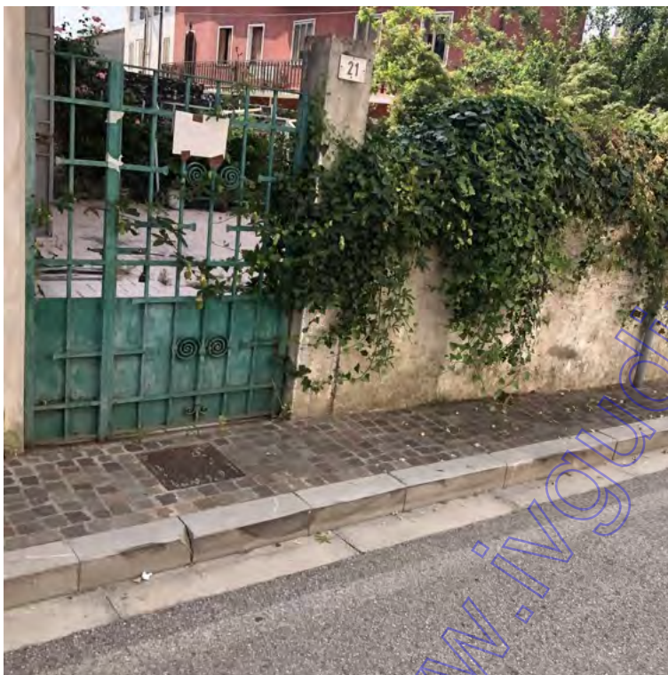
Fotografia A.1 - Ingresso pedonale Nord
