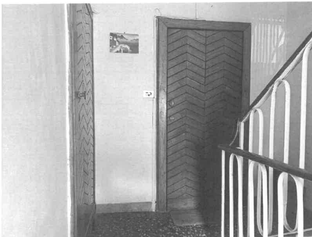
Figura 5 porta di ingresso alloggio
