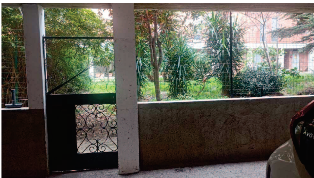
Foto n. 6. Ingresso pedonale per accedere all'area verde retrostante il fabbricato e per raggiungere i locali contatori.
