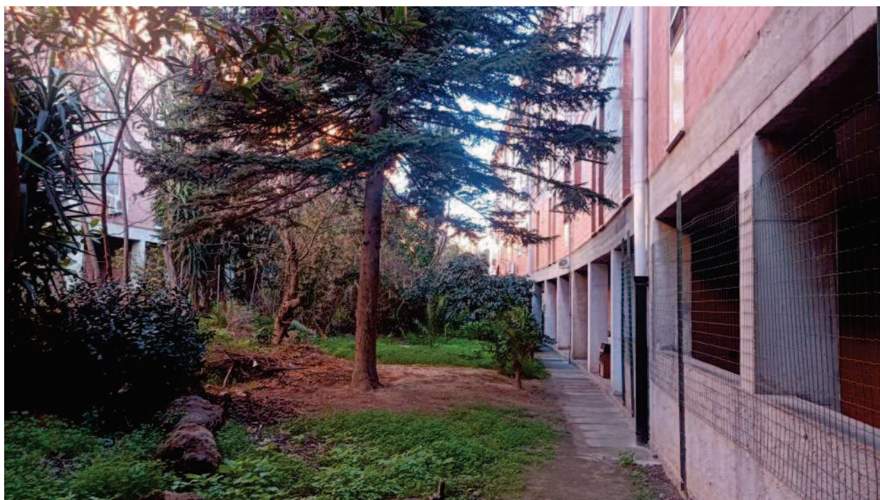
Foto n. 8. Sulla destra si può osservare il percorso pedonale da seguire per raggiungere i locali contatori Enel e idrico dell'immobile, siti nel piano pilotis del fabbricato confinante. Sulla sinistra si può osservare il fabbricato retrostante, con cui viene condivisa l'area verde, in quanto attualmente é recintata e accessibile solo dai fabbricati.
