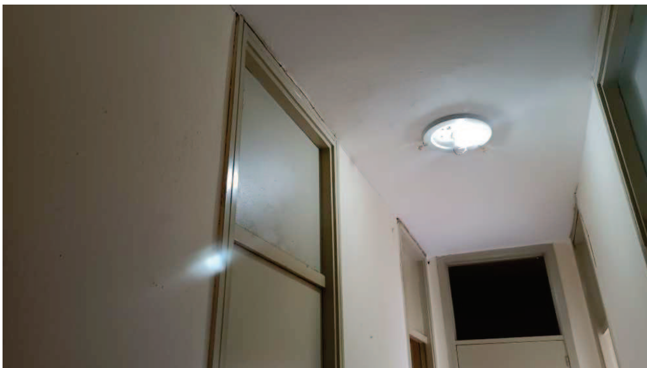
Foto n. 24. Vista del disimpegno.
