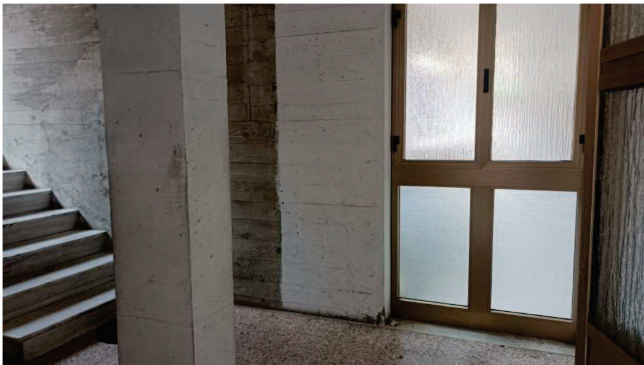
Foto n. 15. Vano scala visto dall'ingresso. L'infisso prospetta sulla zona ingresso carrabile.
