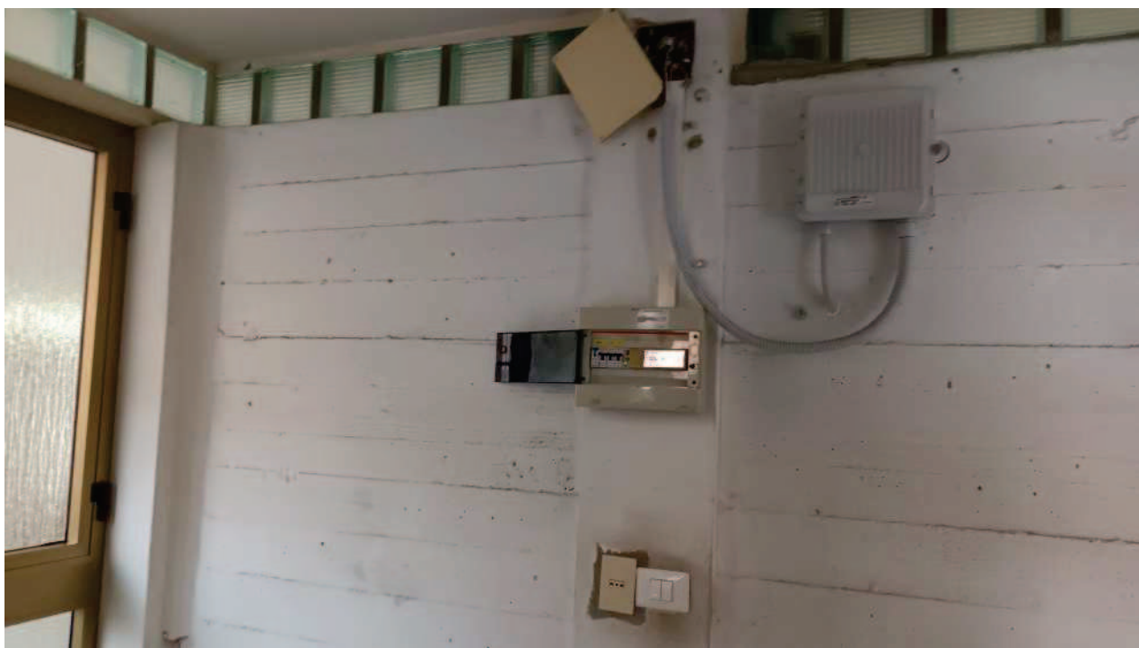
Foto n. 14. Vista di impianti presenti nell'ingresso del vano scala.
