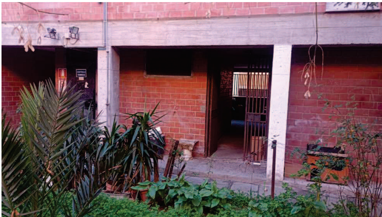
Foto n. 9. Vista dell'ingresso della zona locali contatori, siti nel fabbricato confinante.
