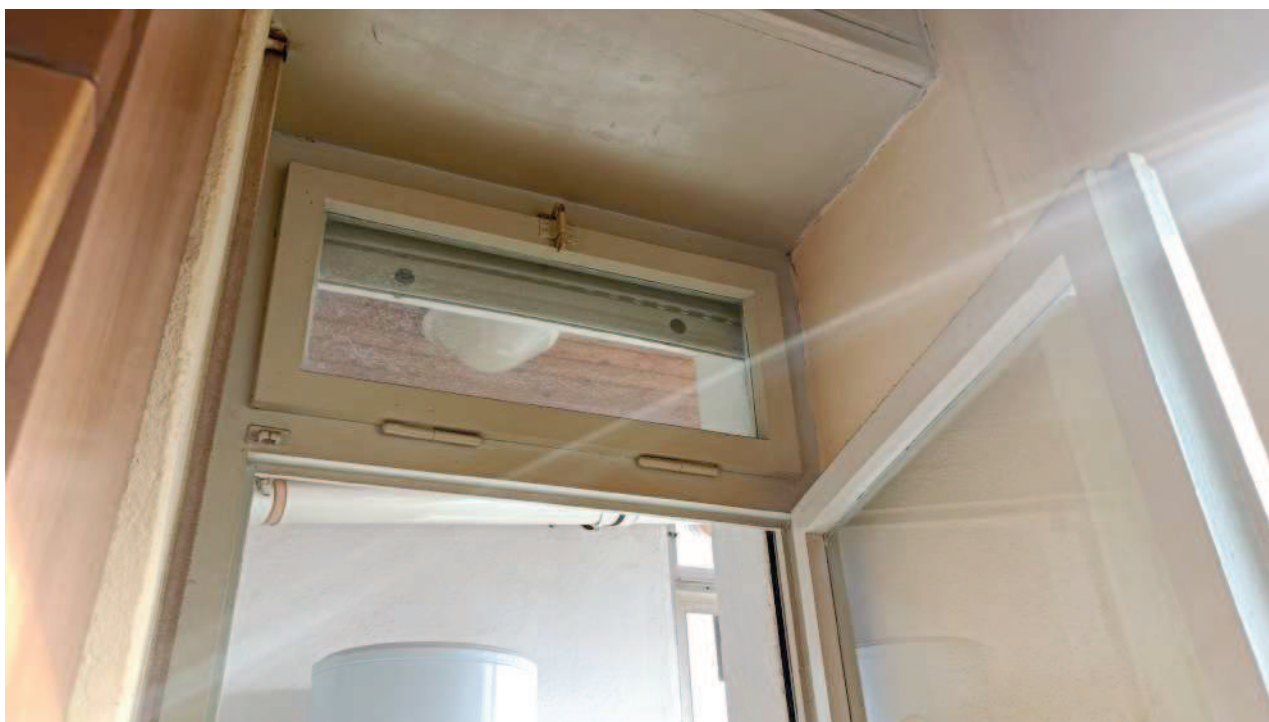
Foto n. 12. Particolare dell'infisso tra la cucina e la veranda retrostante la lavanderia.
