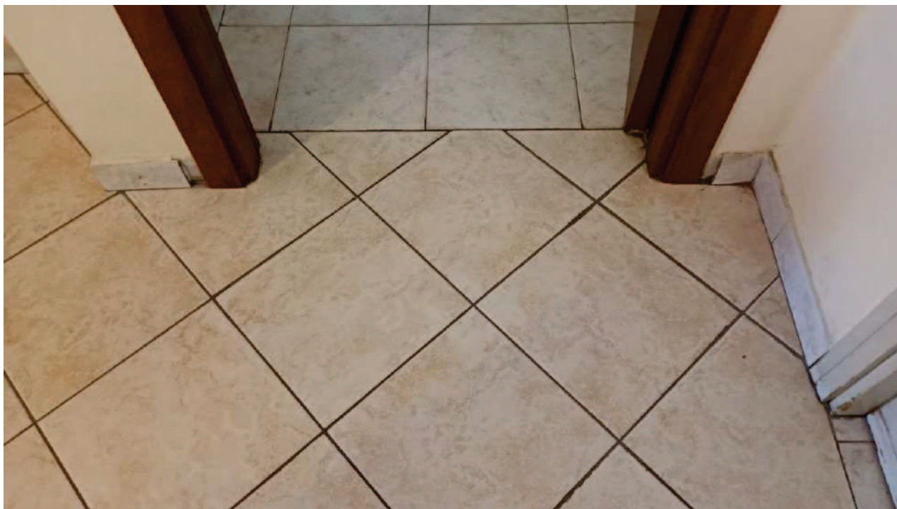
Foto n. 25. Particolare della pavimentazione del soggiorno e del disimpegno. Ai lati della porta del disimpegno il battiscopa risulta non completo.
