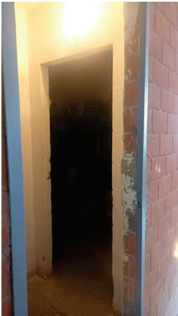
Foto n. 1. Vista della cantina dal Piano Pilotis.
