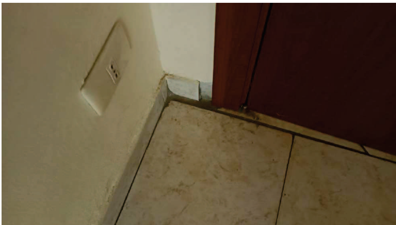
Foto n. 26. Particolare battiscopa visto dal disimpegno.
