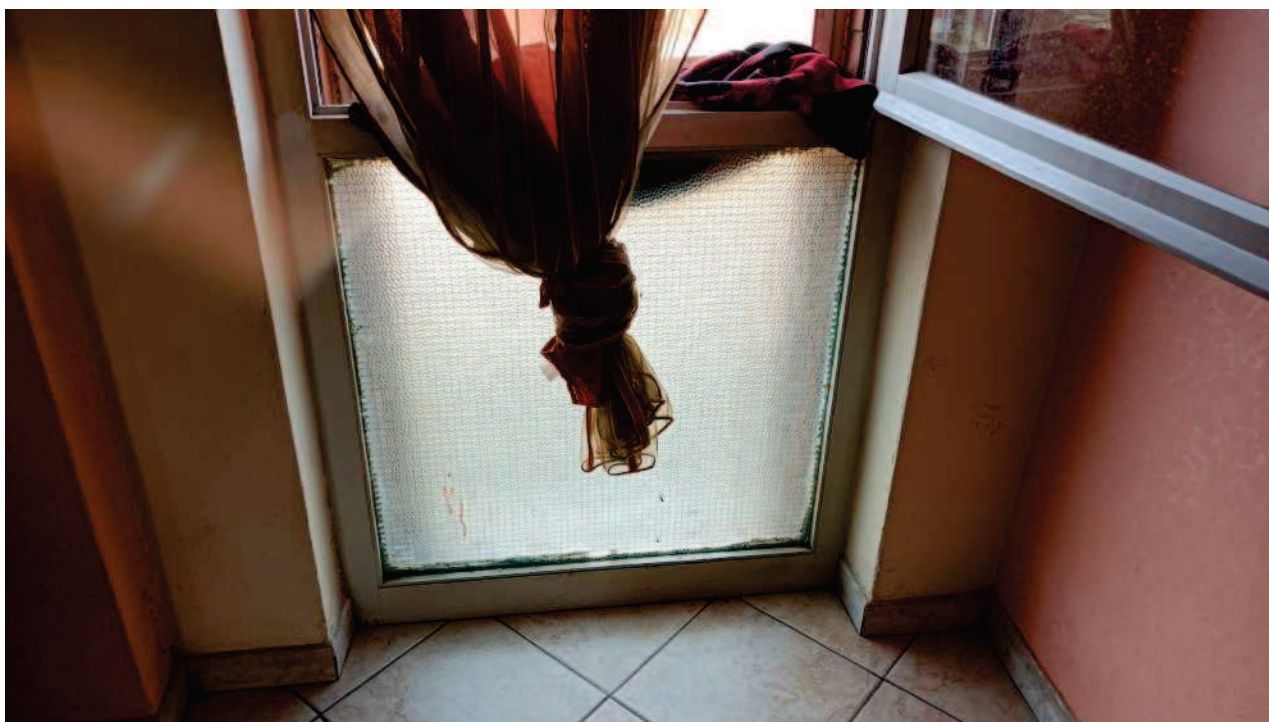
Foto n. 4. Particolare dell'infisso del soggiorno.
