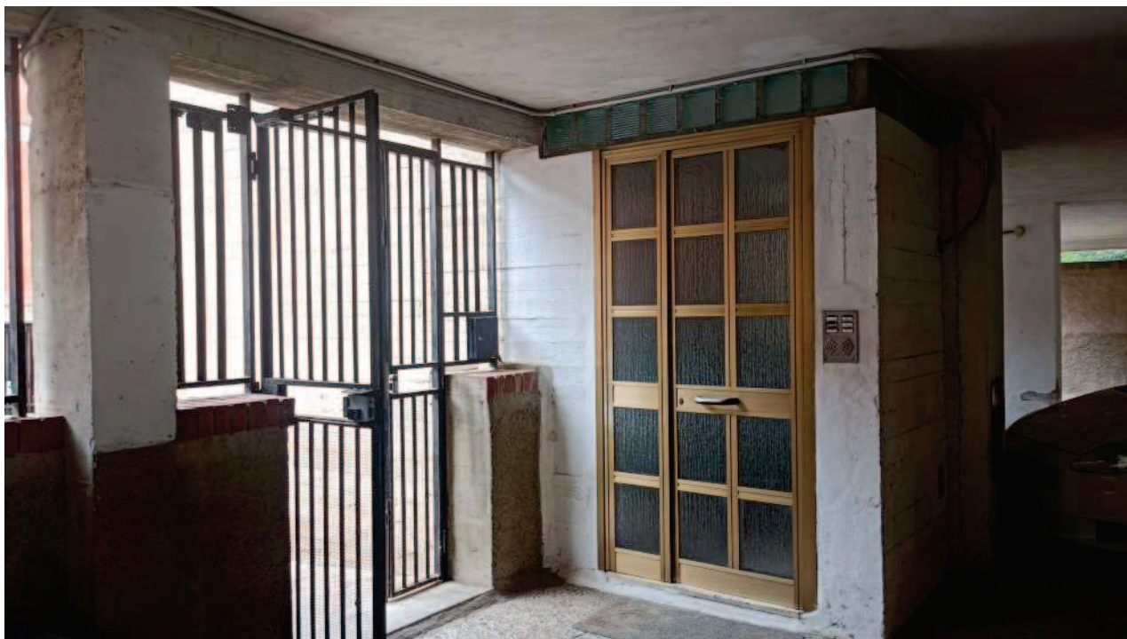
Foto n. 1. Vista ingresso al civico 5 e del vano scala.
