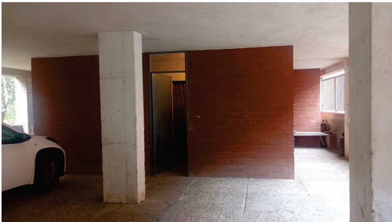
Foto n. 3. Vista del blocco cantine. La cantina pignorata si trova sulla destra.
