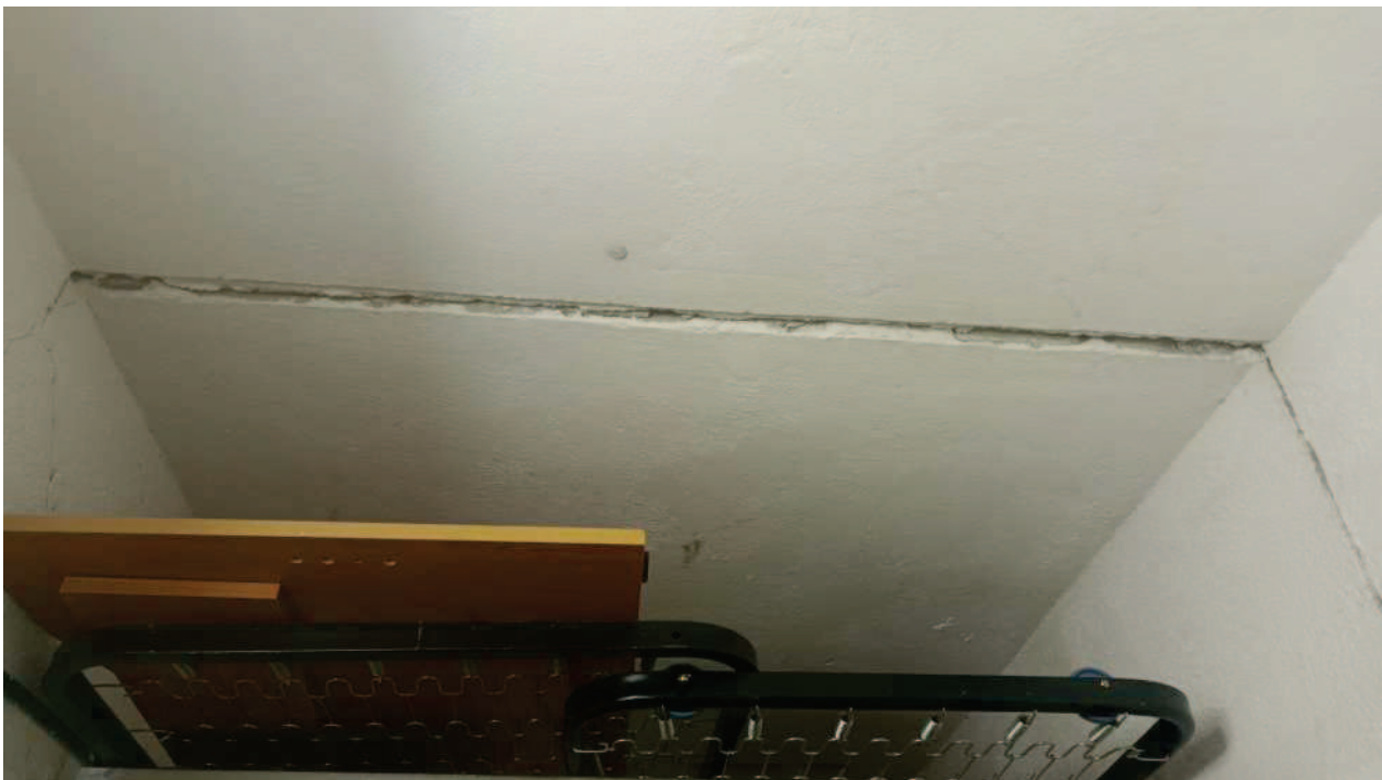
Foto n. 5. Vista della zona sottostante il soffitto della cantina.
