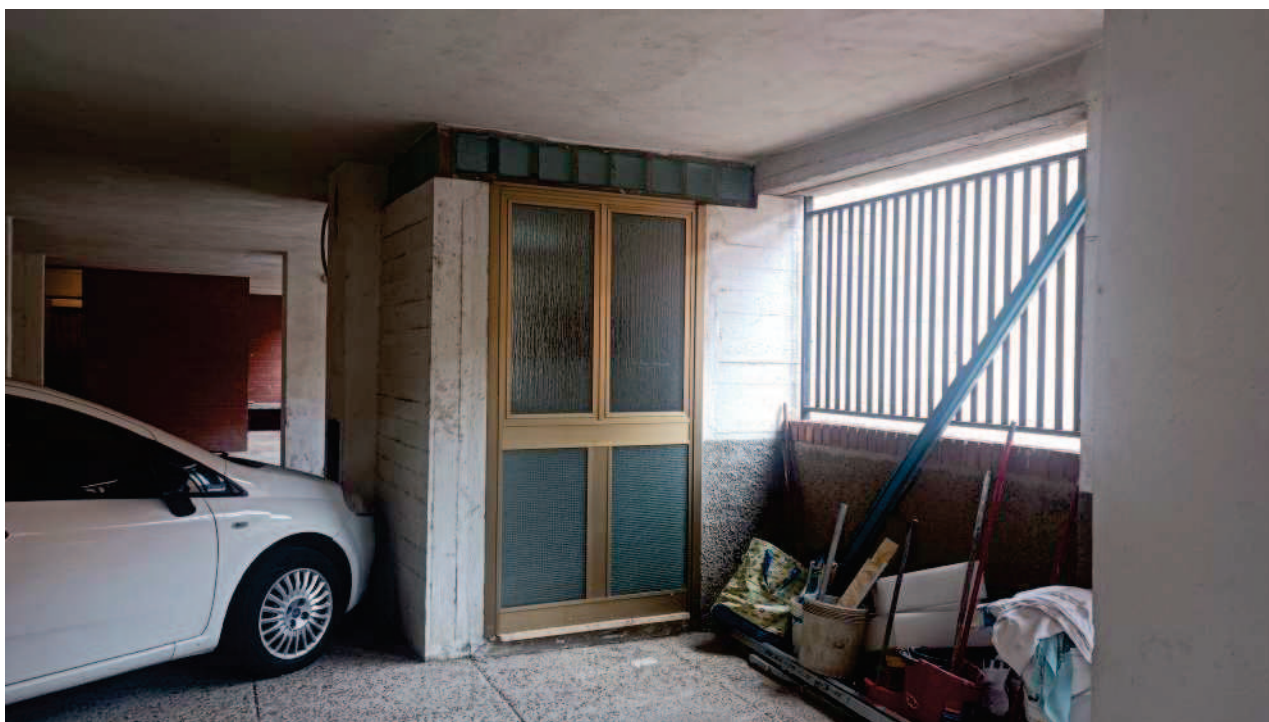
Foto n. 2. Vista del vano scala dalla zona dell'ingresso carrabile.
