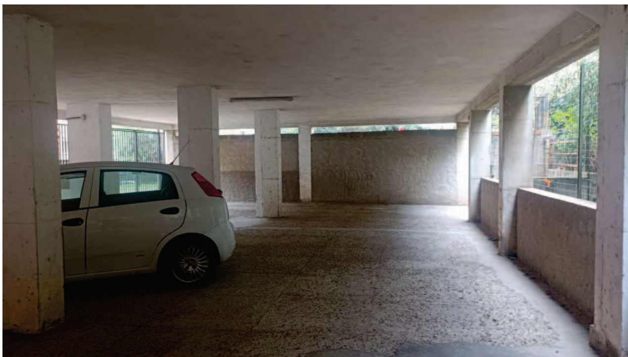
Foto n. 4. Vista del piano pilotis. A sinistra è presente l'ingresso carrabile.
