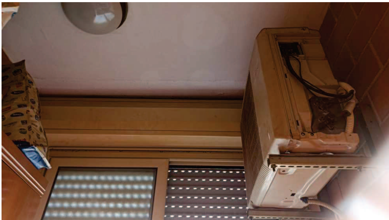
Foto n. 7. Particolare della parte alta della veranda chiusa.
