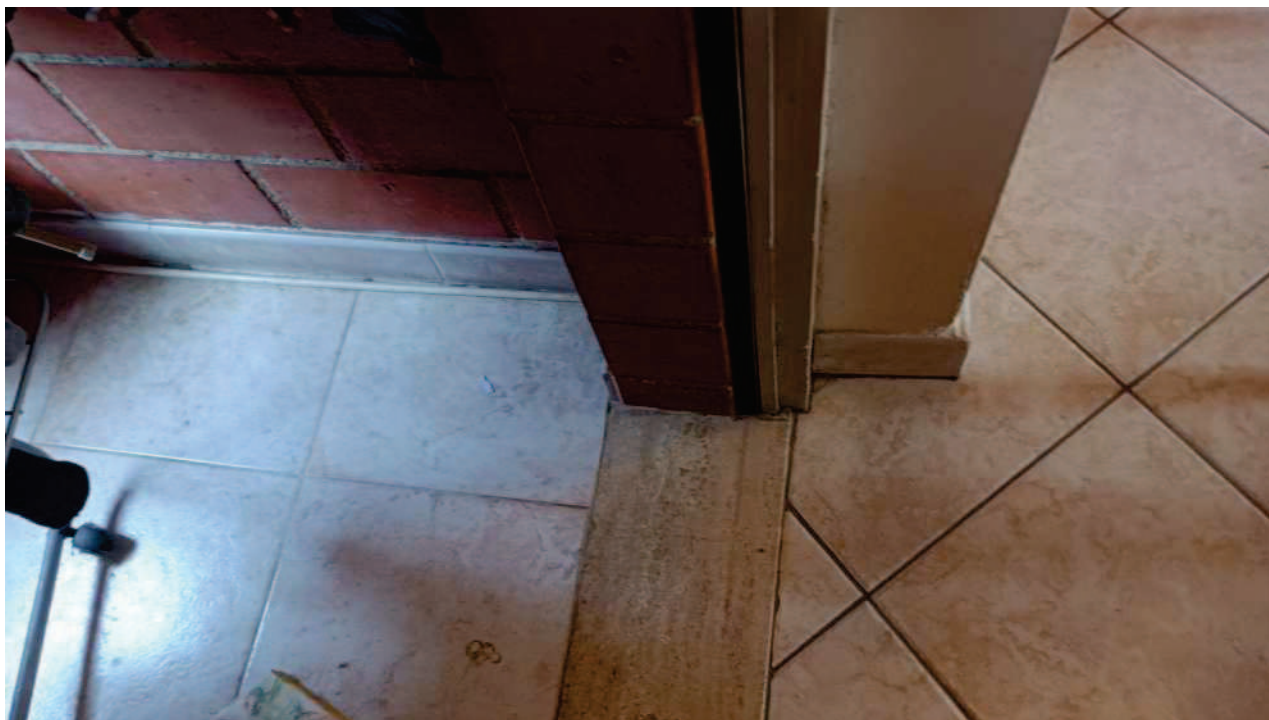
Foto n. 5. Particolare della pavimentazione. A destra é visibile la pavimentazione del soggiorno, a sinistra quella della veranda chiusa. Non é presente alcun dislivello.
