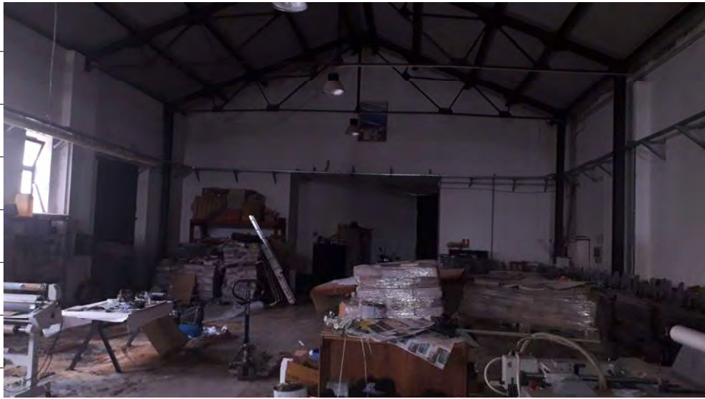
Foto n.9: immagine interna della zona adibita a tipografia ubicata al piano terra.
