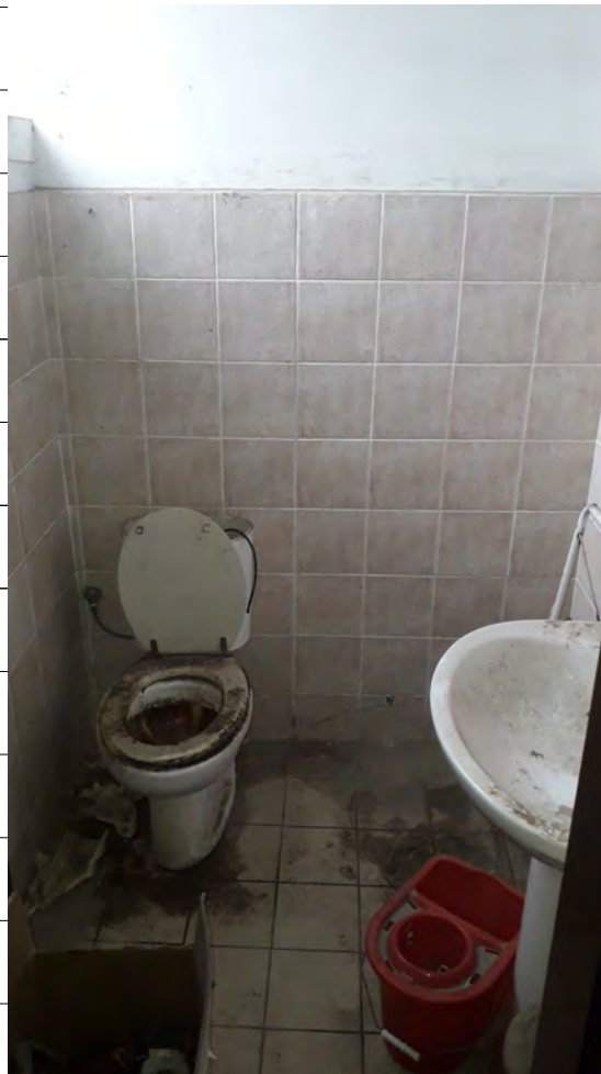
Foto n.14: immagine interna del wc ubicato al piano terra dell'edificio.
