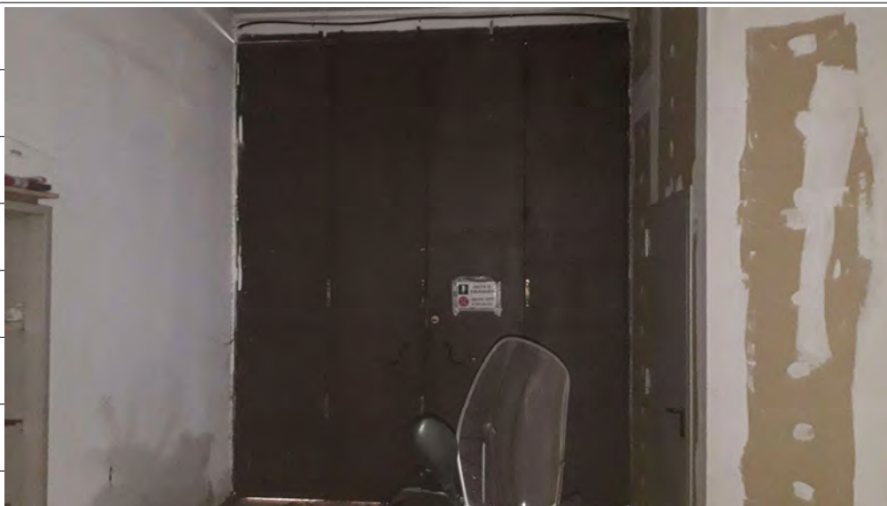
Foto n.11: immagine interna della zona adibita a tipografia ubicata al piano terra.
