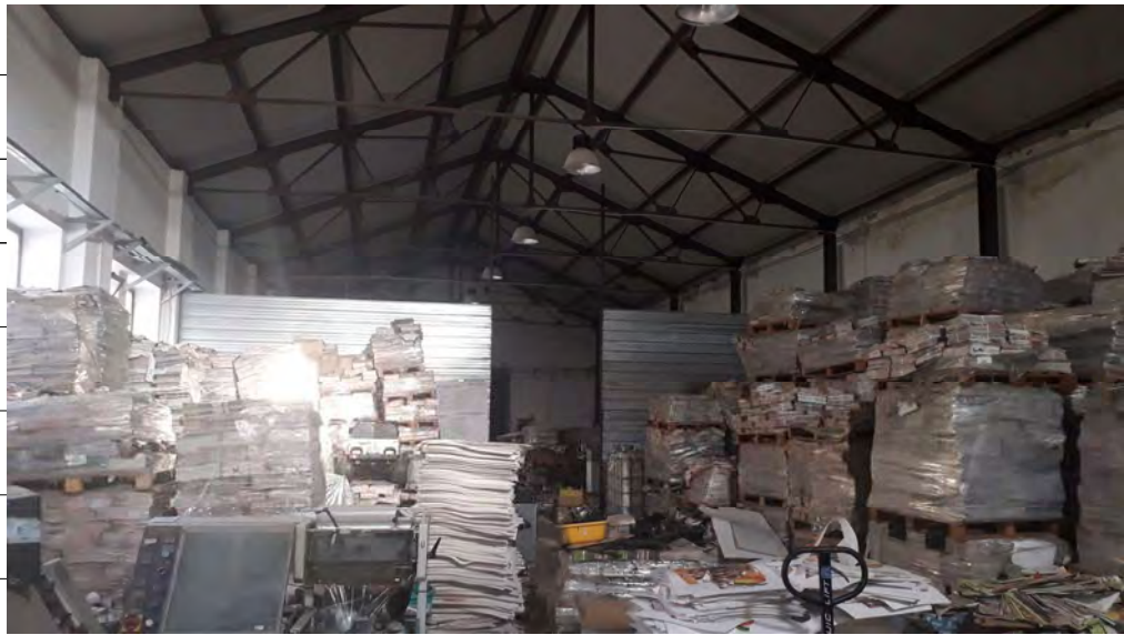
Foto n.6: immagine interna della zona adibita a confezionamento ubicata al piano terra.
