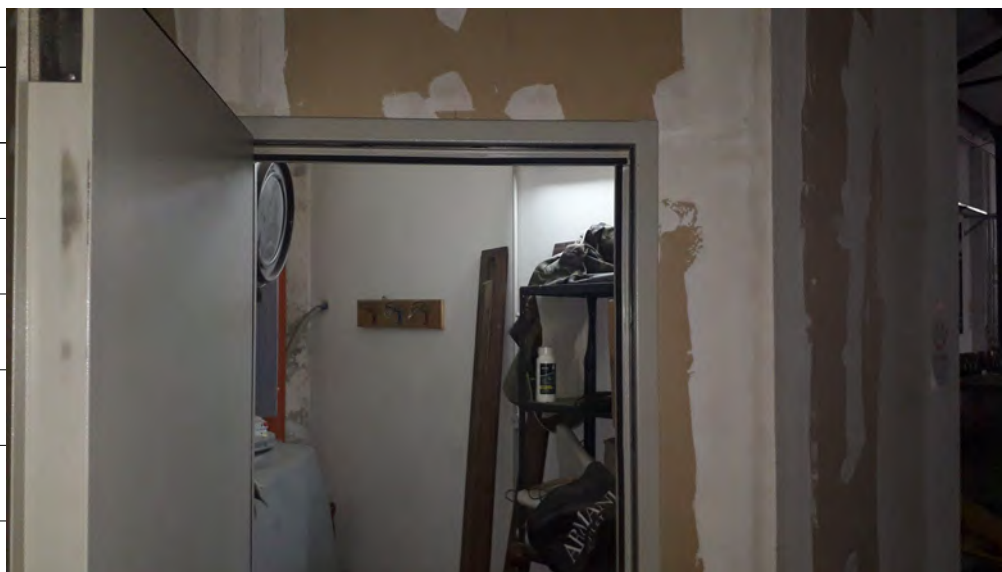
Foto n.12: immagine interna del ripostiglio ubicato al piano terra.
