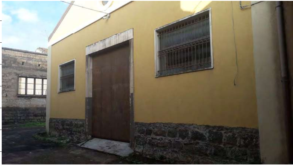
Foto n.5: immagine esterna dell'ingresso dell'edificio da via Atri s.n.c. a Lentini.
