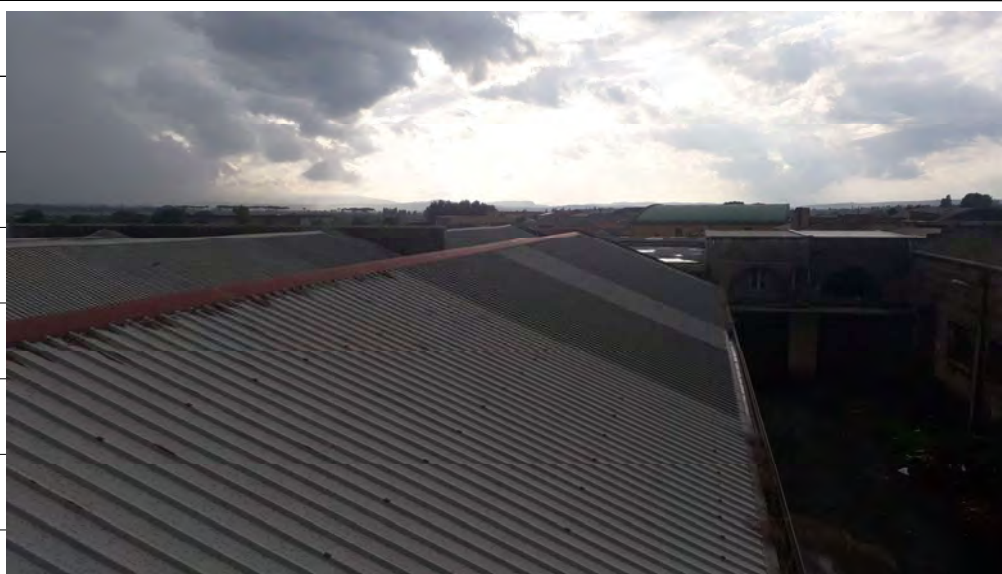
Foto n.32: immagine esterna della copertura a falde della tipografia.
