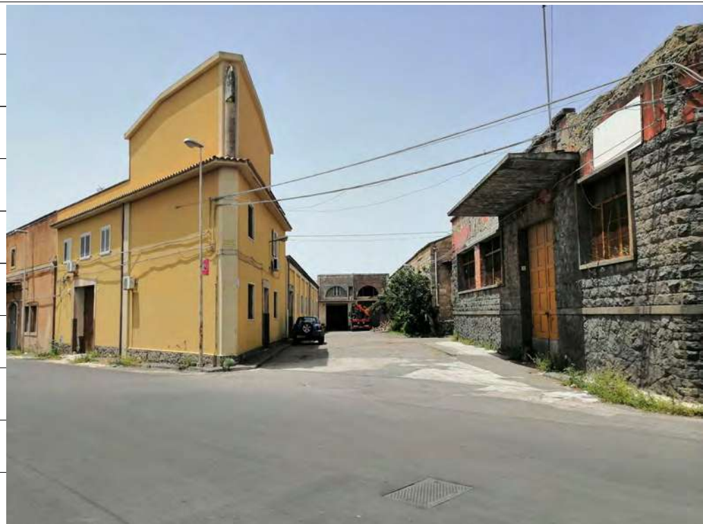
Foto n.2: immagine esterna dell'edificio angolo tra via Degli Esportatori e via Puglia a Lentini.
