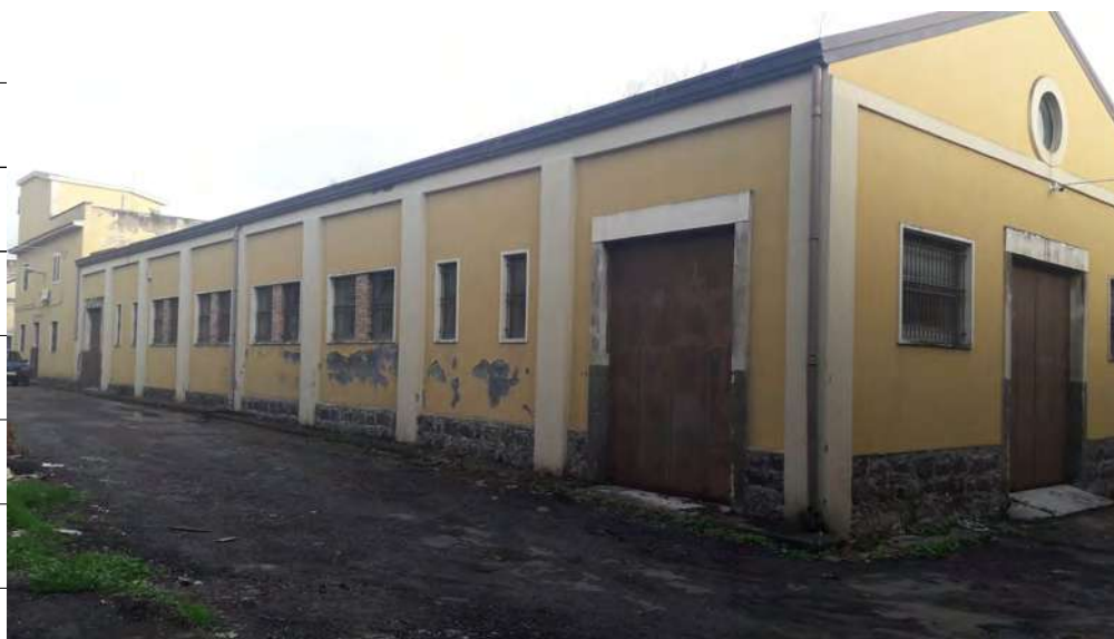
Foto n.4: immagine esterna dell'edificio angolo tra via Puglia e via Atri con relativi ingressi a Lentini.
