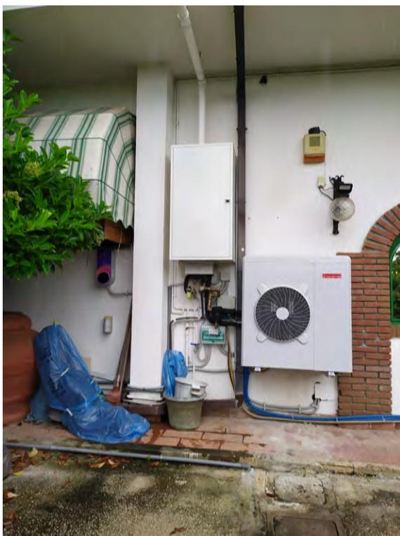
**FOTO 24 POMPA DI CALORE -
