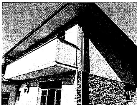
Veduta esterna del piano terra e primo
