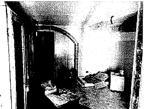
Particolare di un vano al piano seminterrato.
