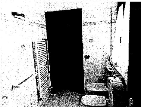
Particolare di altro bagno al piano primo
