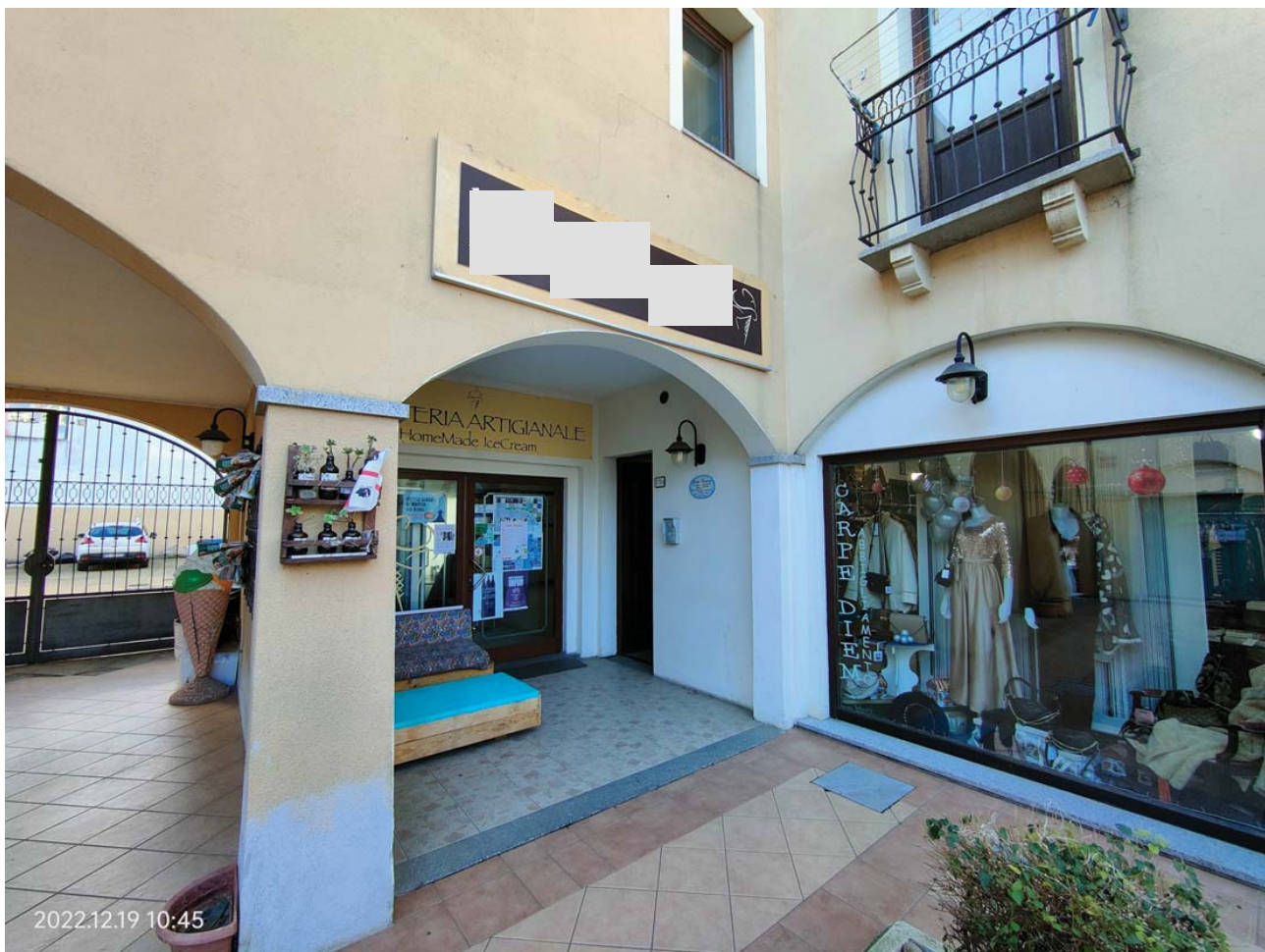
Foto 4 - Vista di insieme dell'accesso al Locale ed ai posti auto
