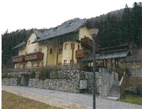
Vista del fabbricato
