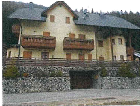
Vista del fabbricato con portone di accesso per le autorimesse
