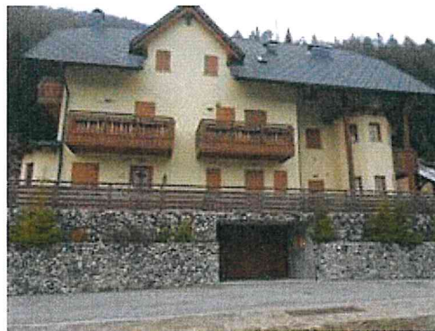
Vista del fabbricato con portone di accesso per le autorimesse
