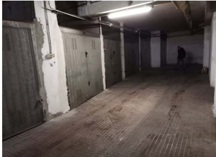
Le corsie di manovra
