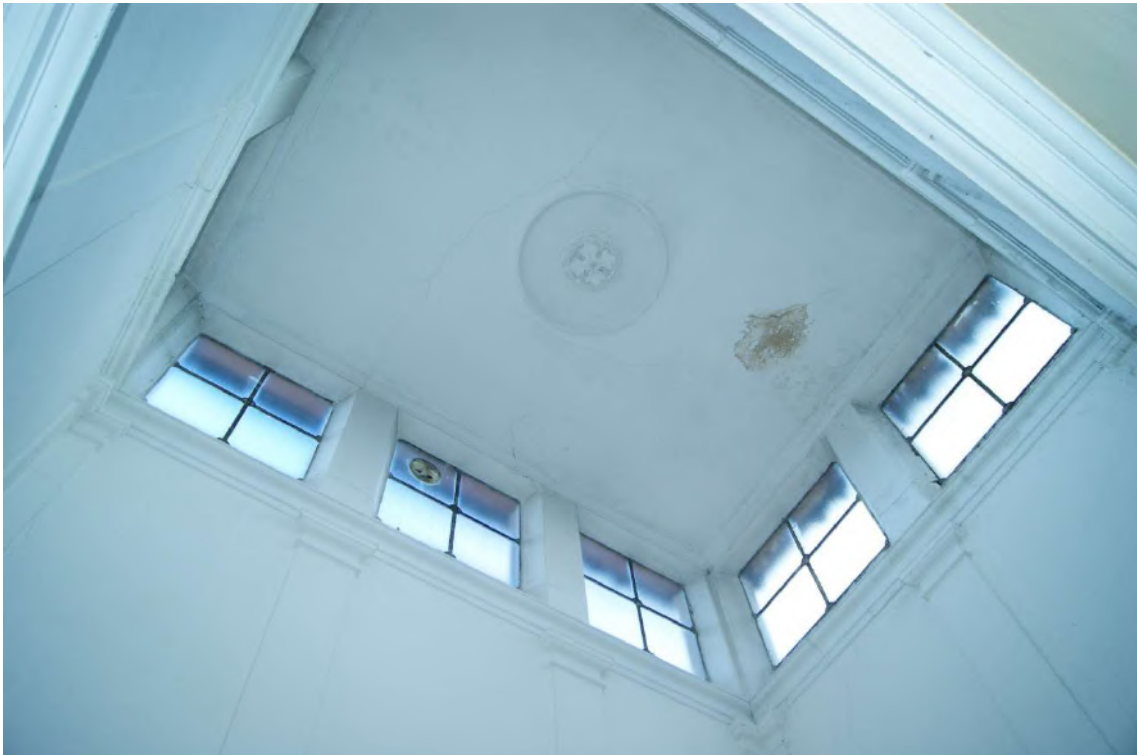
copertura del vano scala
