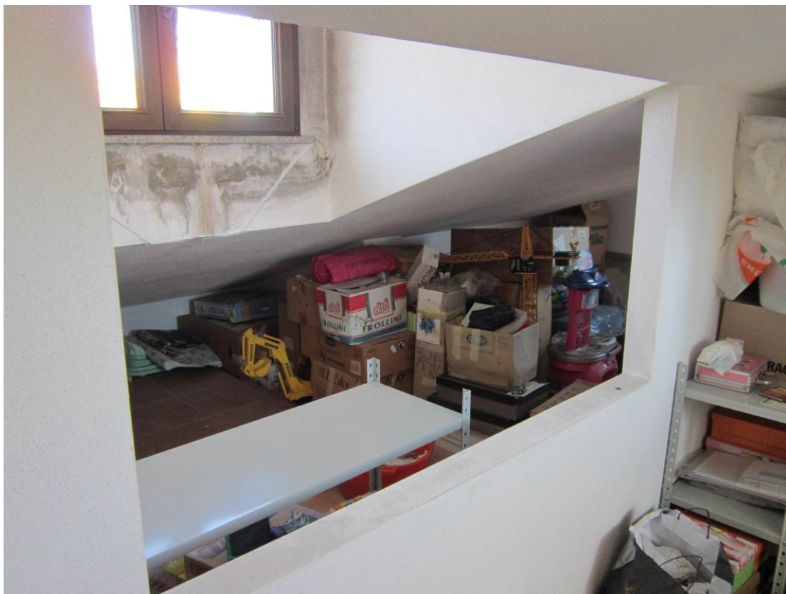
Foto 14, vista interna sottotetto
