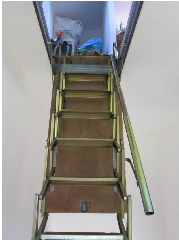
Foto 13, vista scaletta retrattile di accesso dal piano primo al piano sottotetto
