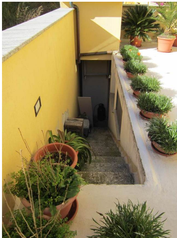
↳ Foto 6, vista scala esterna di collegamento corte posta al piano terra con locale garage
