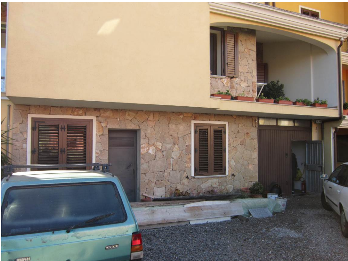
↳ Foto 1 e 2, vista esterna garage dalla via Allende e dall'area di corte
