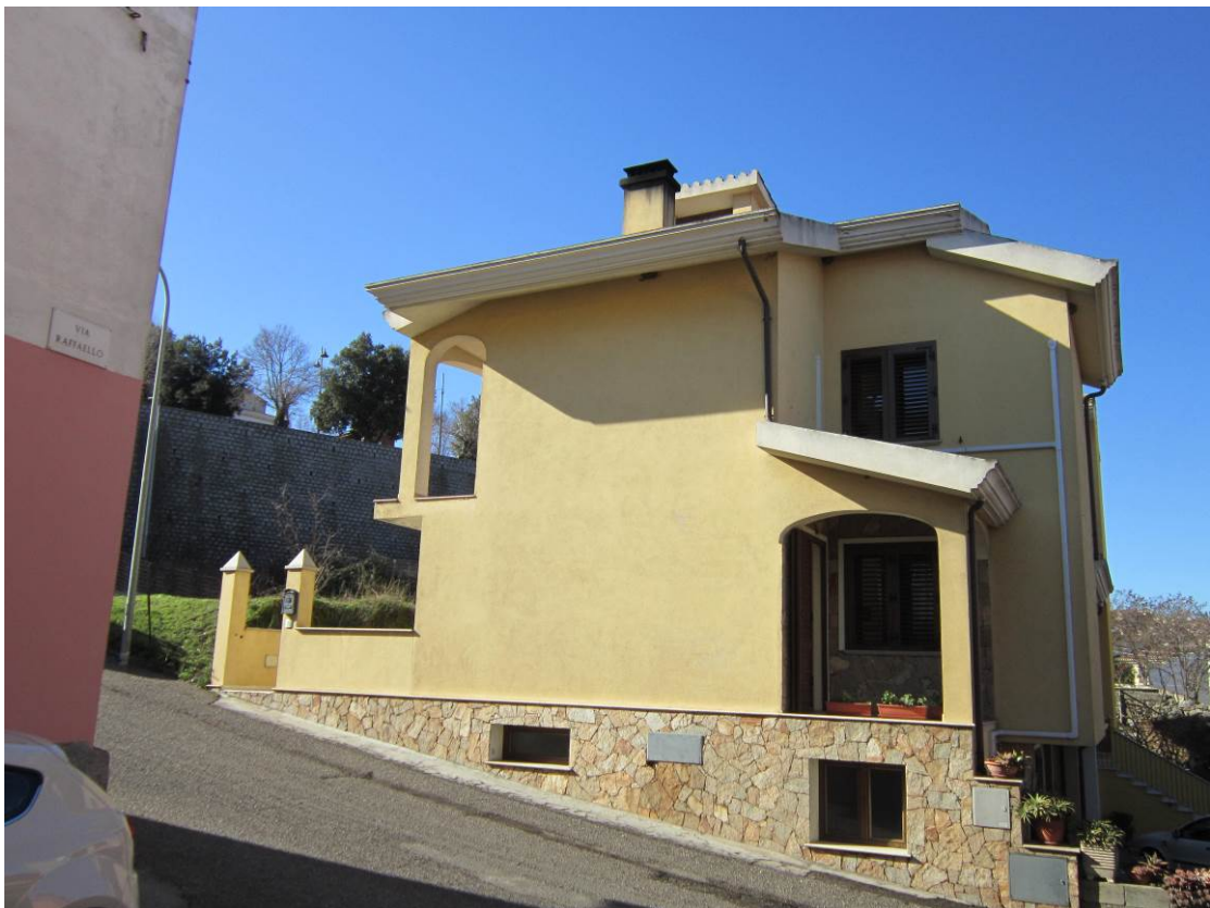
↳ Foto 1 e 2, vista esterna immobile dalla via Allende
