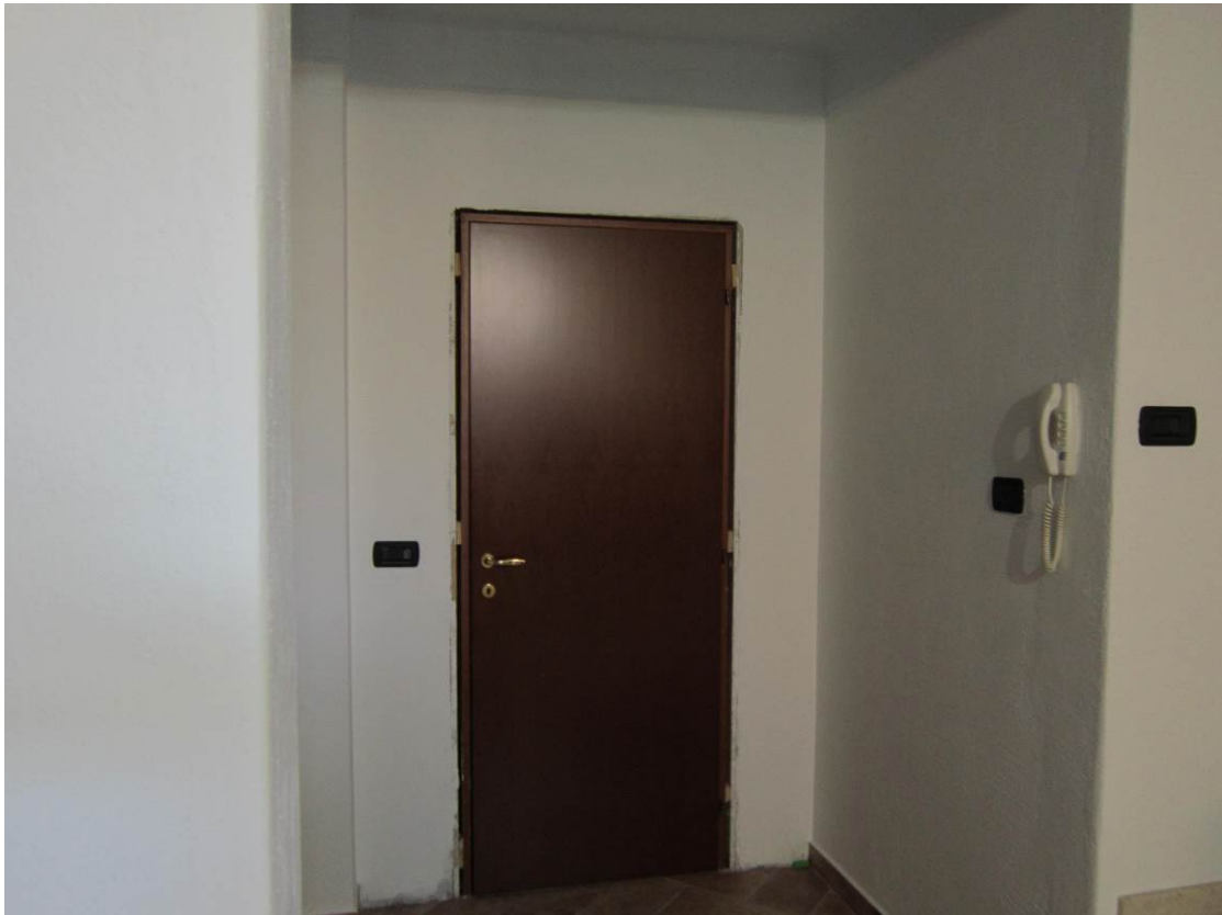
↳ Foto 19, vista porta di collegamento piano seminterrato/garage
